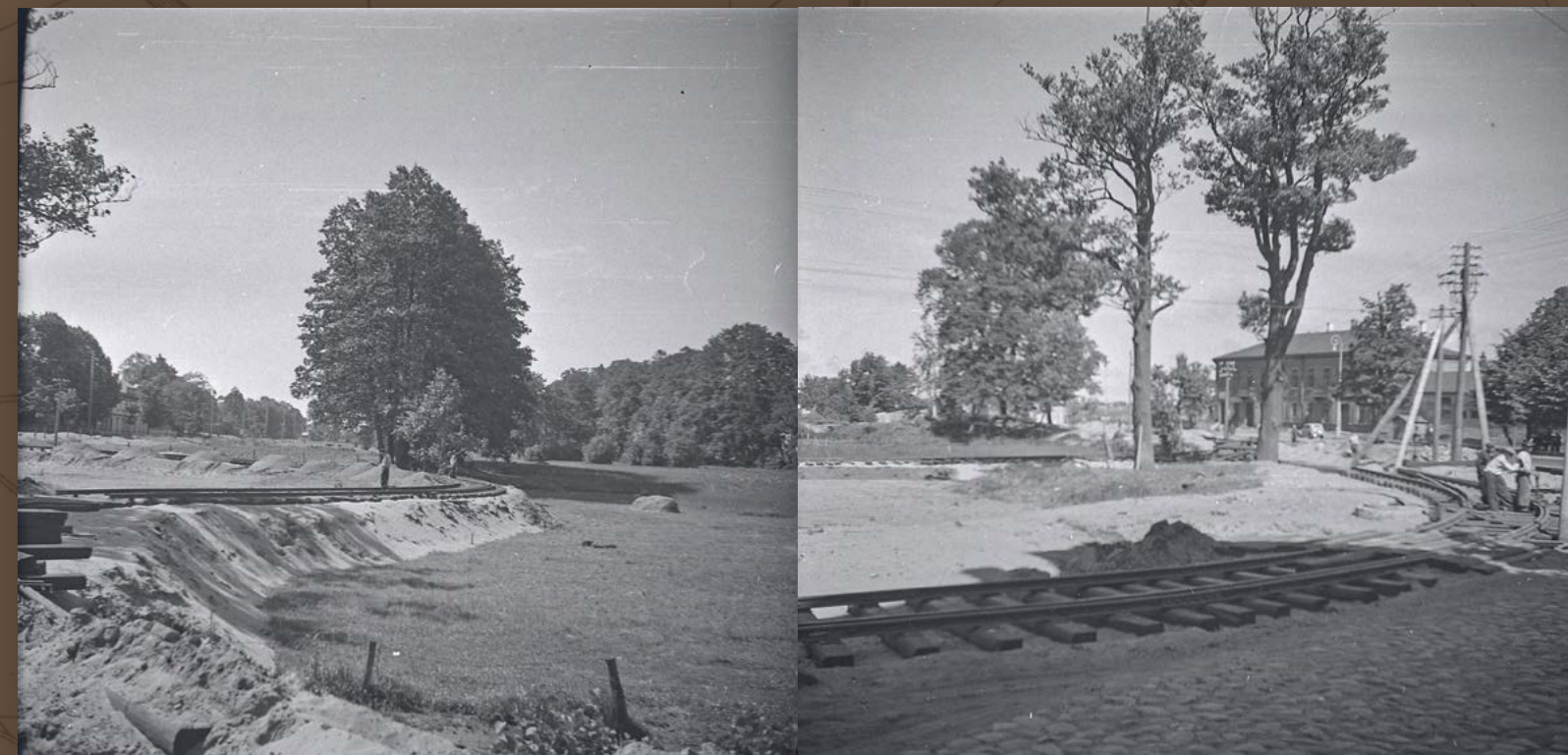
Tramvaja apgriešanās loks Katlakalnā (Bišumuižā), sliežu būve 1952. gada jūlijā. Fotogrāfiju autors nav zināms.
