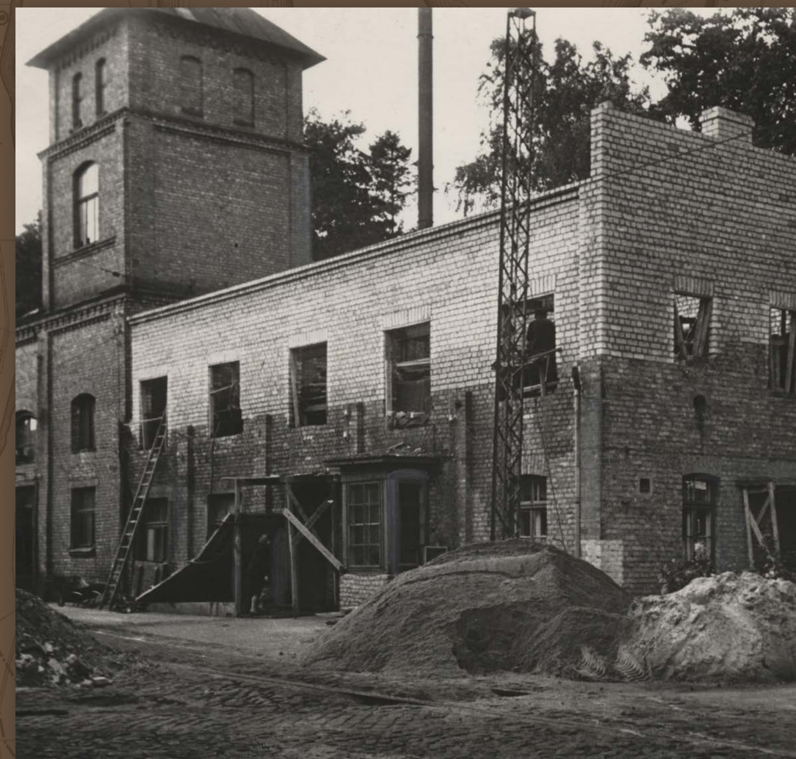
4. depo administrācijas ēkas otrā stāva būvniecība, 1962. gada septembris. Fotogrāfijas autors: Harijs Antonovičs
