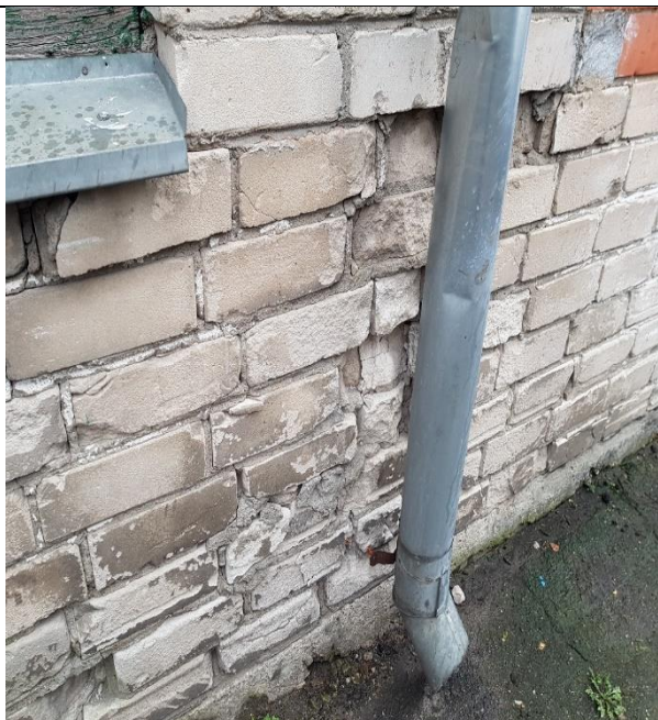
4.2.19.att. Mūra sienas bojājumi mitruma un sala ietekmē
