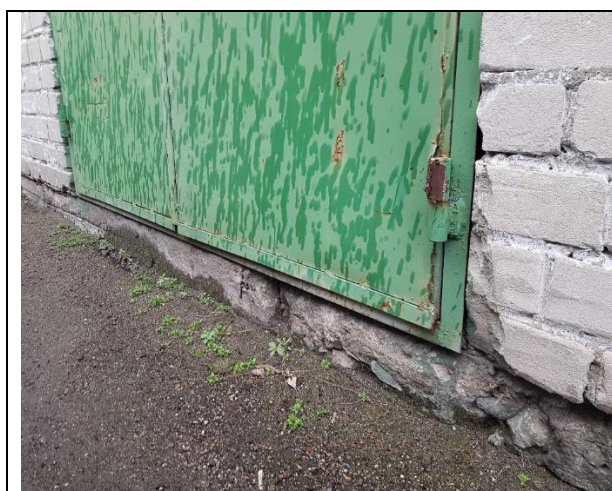
4.1.7.att. Pamatu cokola daļa ar betona struktūras bojājumiem (rietumu fasādes puse)
