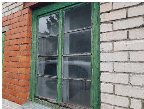
4.13.2.att. Koka logs neapmierinošā tehniskajā stāvoklī
