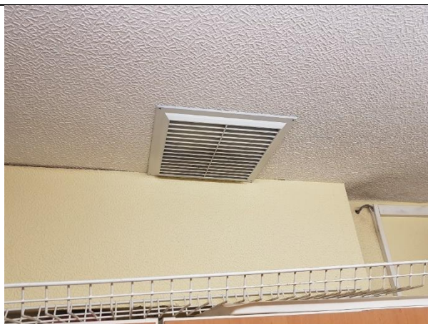
5.6.3.att. Nosūces ventilācijas reste telpā Nr.8. Nepieciešams attīrīt putekļu nosēdumus.
