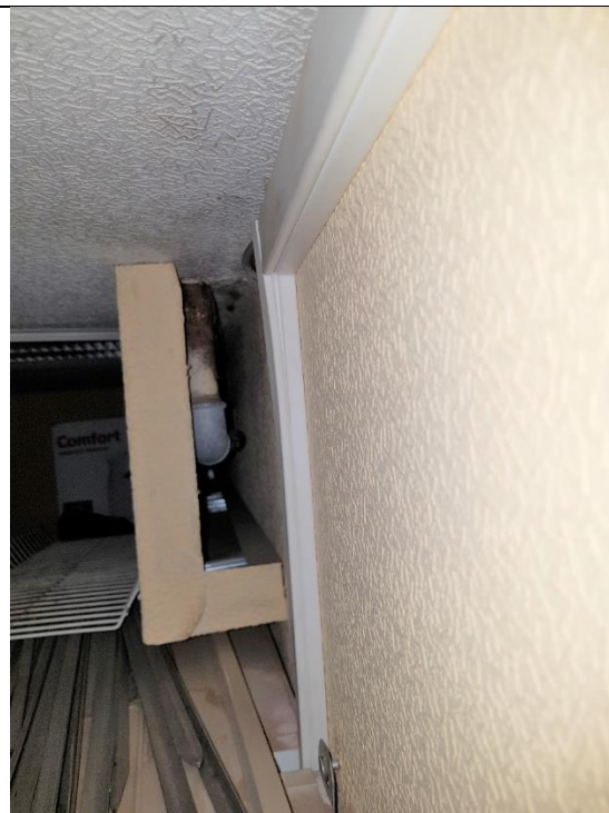
5.1.6.att. Aukstā ūdens cauruļvads ar korozijas bojājumiem (telpa Nr.8)
