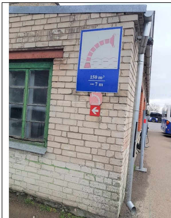
4.8.13.att. Cinkotā skārda notekcaurules apmierinošā tehniskajā stāvoklī
