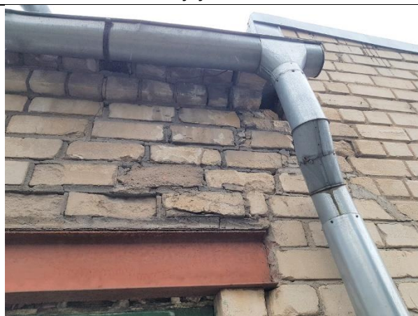
4.2.16.att. Loga ailes dubult-T profila pārsedze (h= 150 mm) ar korozijas bojājumiem
