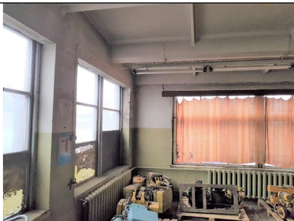
4.18.4.att. Ražošanas telpu sienu apdare ar eļļas krāsām un balsināti griesti
