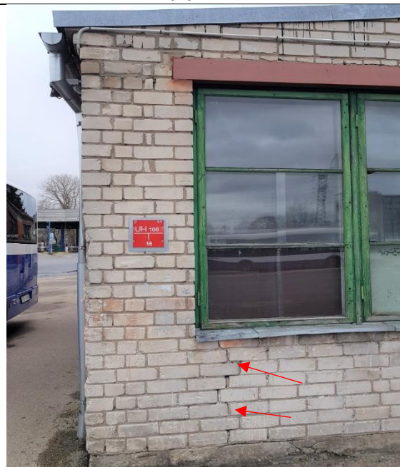
4.2.20.att. Caurejoša plaisa mūra sienā zem loga ailas, sk. tuvplānu attēlā 4.2.21., skats no iekšpuses dots attēlā 4.2.22.
