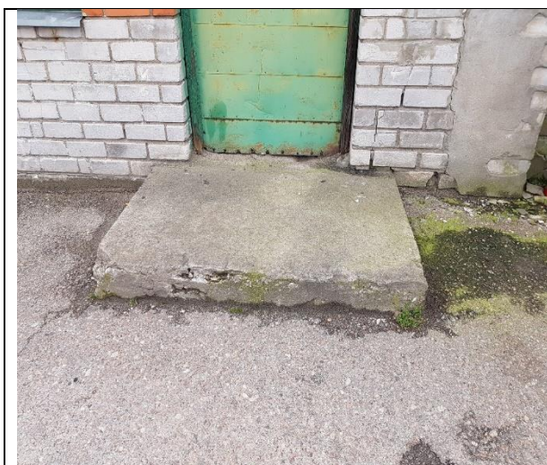
4.9.1.att. Lievenis pie ieejas telpā Nr.1 ar betona struktūras bojājumiem
