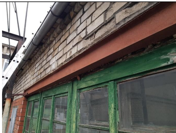
4.2.16.att. Loga ailes dubult-T profila pārsedze (h= 150 mm) ar korozijas bojājumiem
