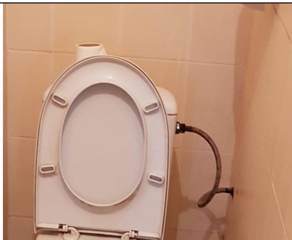
5.1.4.att. Klozetpoda pieslēgums ar lokano pievadu (telpa Nr.6)
