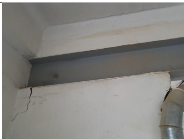
4.3.4.att. Nesošā mūra kolonna ar mehānisku bojājumu ventilācijas cauruļvada izbūves vietā un necaurejošu plaisu. Uz kolonnas
