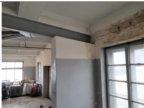
4.3.1.att. Nesošā mūra kolonna ar nebūtiskiem mitruma radītiem bojājumiem. Uz kolonnas balstīta U-profila ( h = 250 \text{ mm} ) pārseguma sija.
