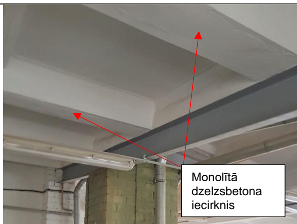
4.6.8. Dzelzsbetona pārseguma paneli telpā Nr.2 ar monolītā dzelzsbetona iecirkni
