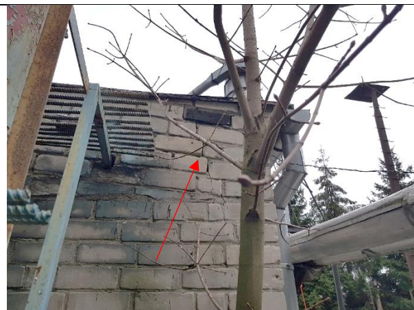
4.2.37.att. Nekvalitatīvi veikti mūrēšanas darbi un plaisas (ziemeļu fasāde)
