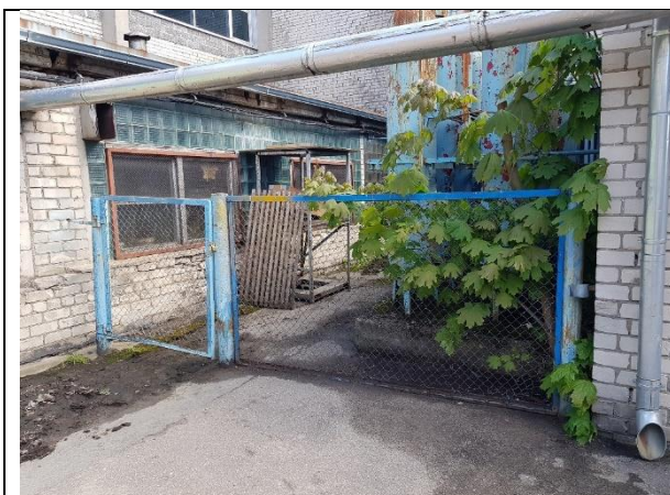
3.4.1.att. Nožogojums ēkas ziemeļu fasādes pusē, neapmierinošā tehniskajā stāvoklī.
