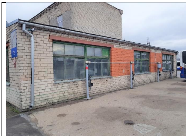
4.19.1.att. Ēkas dienvidu puses fasādes apdari veido neapstrādātas mūra virsmas
