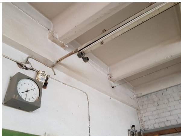
4.18.8.att. Ražošanas telpu sienu apdare ar eļļas krāsām un balsināti griesti
