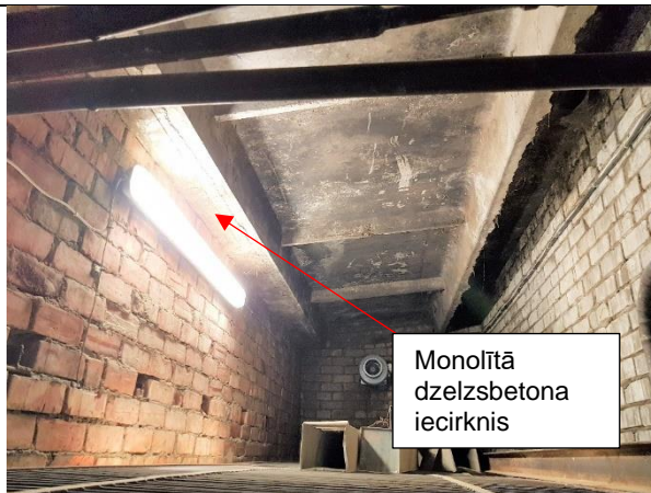
4.6.6.att. Dzelzsbetona pārseguma paneli, telpā Nr.10 ar monolītā dzelzsbetona iecirkni. Kokmateriālu kaltes telpā konstatētas apkvēpušas sienu un griestu virsmas.
