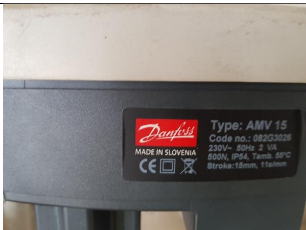
5.4.7.att. Trīsceļu vārsts ar elektropiedziņu
