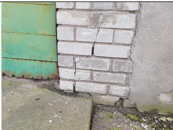
4.2.23.att. Nebūtiska plaisa mūra sienā (austrumu fasāde)
