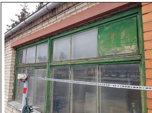
4.13.1.att. Koka logs neapmierinošā tehniskajā stāvoklī
