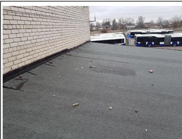
4.8.7.att. Uz apsekojamās ēkas jumta konstatēti ķieģeļi, kas atdalījušies no blakus ēkas (Vestienas iela 35 k-7) mūra sienām un krītot bojā jumta segumu
