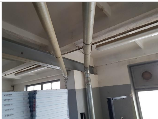
4.3.2.att. Nesošā mūra kolonna. Uz kolonnas balstīta dubulta U-profila ( h = 250 \text{ mm} ) pārseguma sija savienota ar bultskūvēm. Skatīt kopā ar attēlu 4.3.4.
