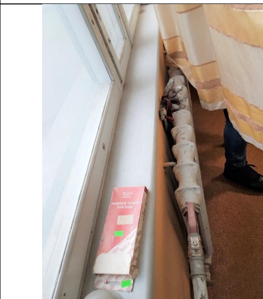
5.5.3.att. Čuguna radiatori apmierinošā tehniskajā stāvoklī
