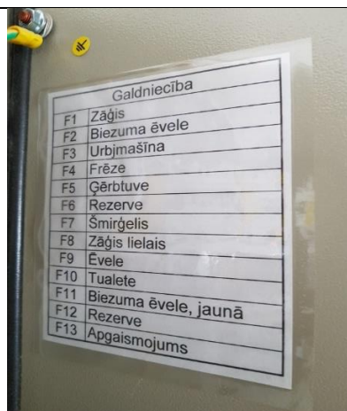
5.9.14.att. Neatbilstoši noformēta sadalnes shēma
