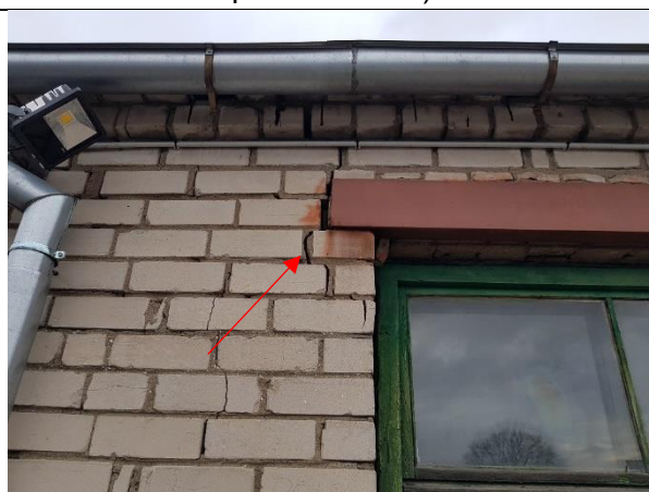
4.2.6.att. Caurejoša plaisa loga ailes pārsedzes balstmezglā. Loga ailes U-profila pārsedzes (h= 150 mm) balsta laukums nav atbilstošs. Skats no iekšpuses dots att. 4.2.7.
