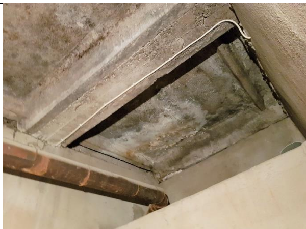
4.18.6.att. T. Nr.5 mūra sienām uzklāts cementa javas apmetums bez tālākas apdares. Griestu virsmas mitruma radīti plankumi un pelējums.
