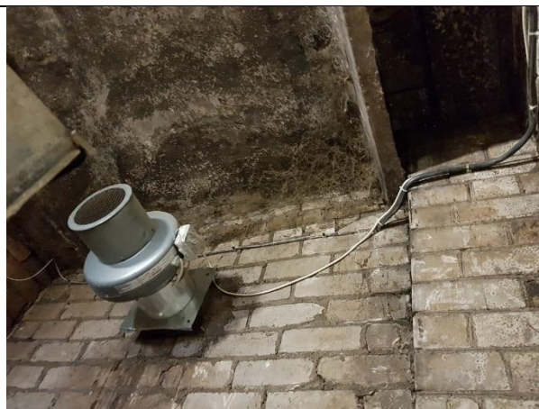
5.6.4.att. Nosūces ventilators telpā Nr.10
