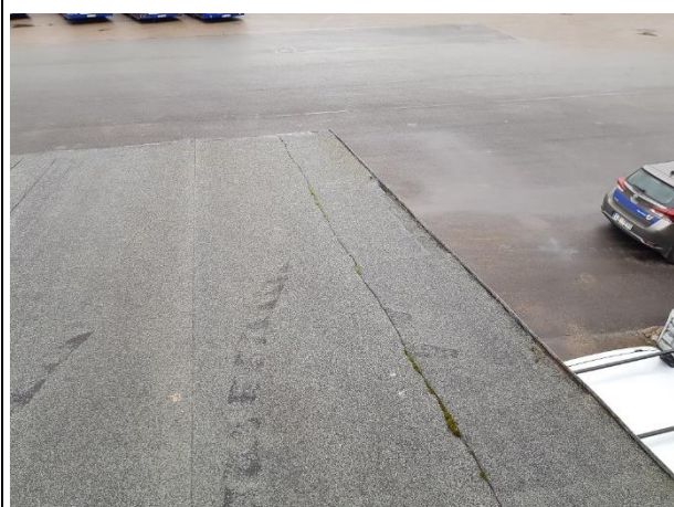
4.8.9.att. Bitumena ruļļveida materiāla segums labā tehniskajā stāvoklī
