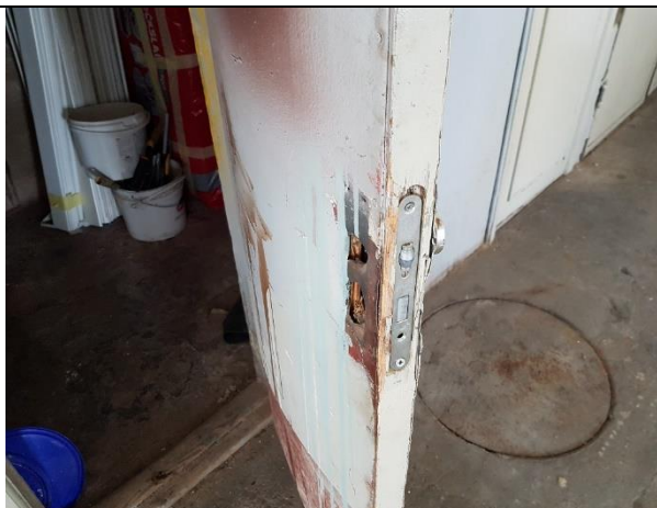
4.13.15.att. Koka iekšdurvis ar skārda apdari neapmierinošā tehniskajā stāvoklī
