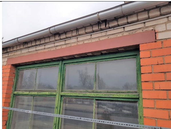
4.2.10.att. Loga aillas U-profila pārsedze (h= 150 mm) labā tehniskajā stāvoklī
