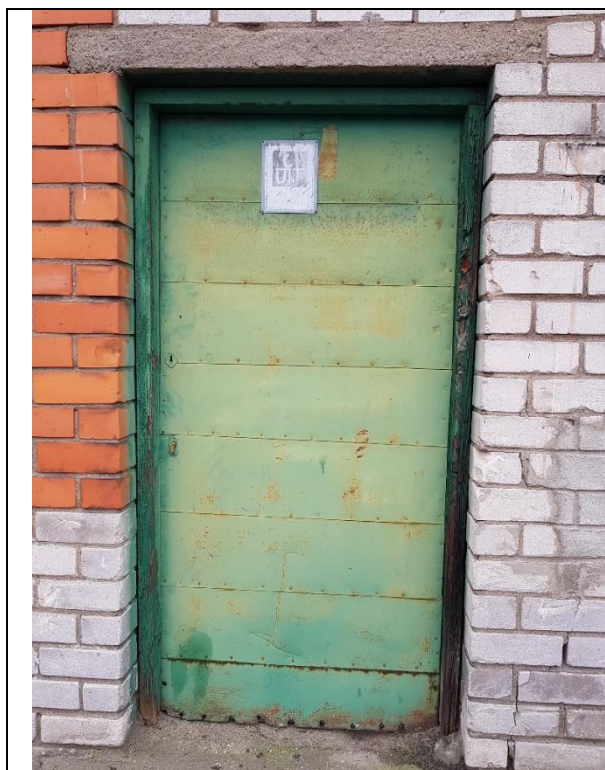
4.13.7.att. Koka ārdurvis ar skārda apdari neapmierinošā tehniskajā stāvoklī
