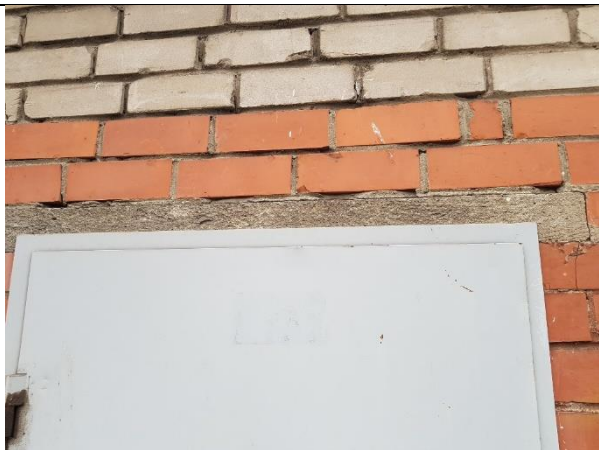
4.2.25.att. Dzelzsbetona pārsedze labā tehniskajā stāvoklī (ieeja telpā Nr.3)
