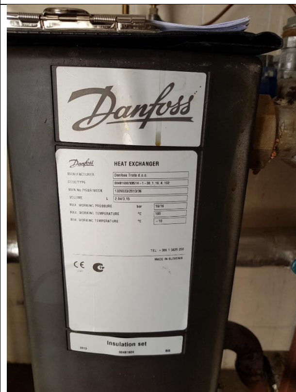
5.4.3.att. Danfoss siltummainis
