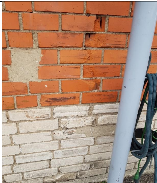
4.2.12.att. Mūra sienas bojājumi mitruma un sala ietekmē
