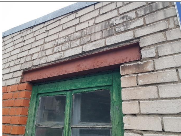
4.2.15.att. Loga ailes dubult-T profila pārsedze (h= 150 mm) ar korozijas bojājumiem
