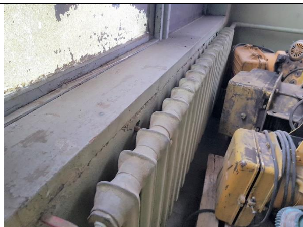
5.5.2.att. Čuguna radiatori apmierinošā tehniskajā stāvoklī
