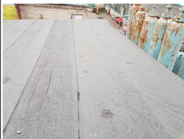
4.8.3.att. Bitumena ruļļveida materiāla segums labā tehniskajā stāvoklī
