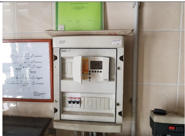
5.4.2.att. Siltummezgla automātikas vadības bloks
