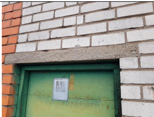
4.2.24.att. Dzelzsbetona pārsedze labā tehniskajā stāvoklī (ieeja telpā Nr.1)
