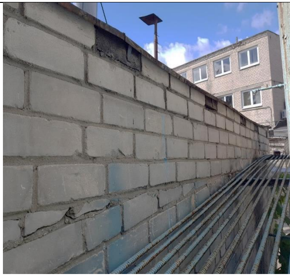
4.2.40.att. Nekvalitatīvi veikti mūrēšanas darbi (ziemeļu fasāde)
