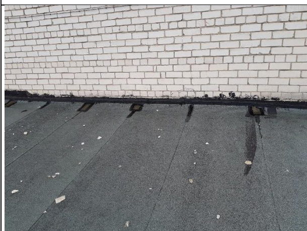
4.8.11.att. Bitumena ruļļveida materiāla segums labā tehniskajā stāvoklī
