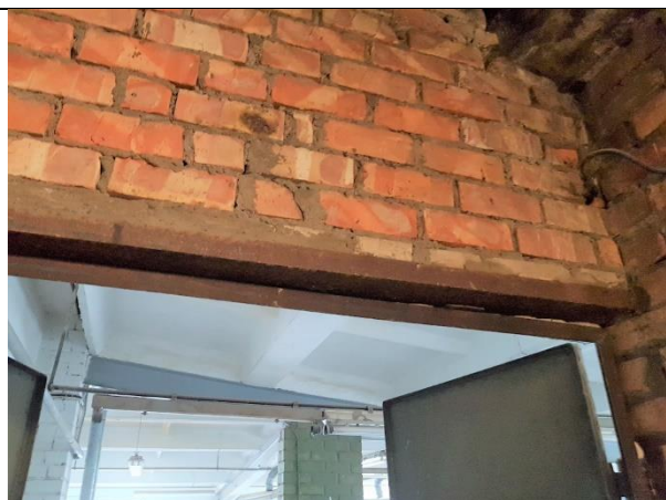
4.11.4.att. Mūra starpsiena telpā Nr.10 ar izbūvētu leņķadzelzs profilu pārsedzi
