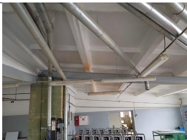
4.3.3.att. Nesošā mūra kolonna. Uz kolonnas balstītas U-profila ( h = 250 \text{ mm} ) pārseguma sijas.
