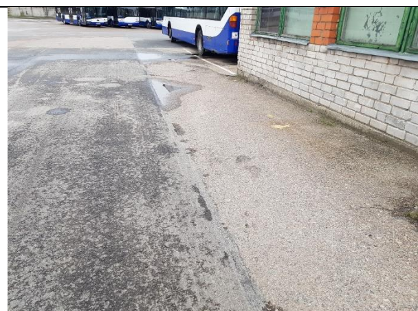
3.1.2.att. Asfaltbetona seguma laukums ēkas dienvidu fasādes pusē, labā tehniskajā stāvoklī
