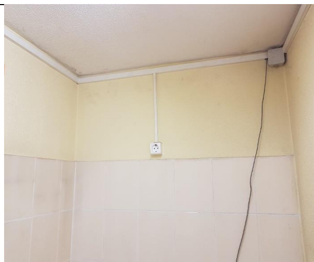
4.18.11.att. Sadzīves telpas Nr.8 sienu apdare ar flīžu segumu. Griesti un sienas krāsotas ar ūdens emulsijas krāsu.
