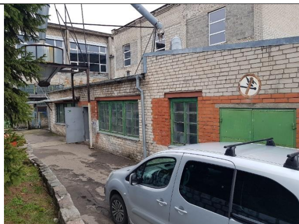
4.19.2.att. Ēkas ziemeļu puses fasādes apdari veido neapstrādātas mūra virsmas kā arī pamatu cokola daļas virsmas, daļēji izlīdzinātas ar apmetumu
