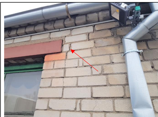
4.4.13.att. Caurejoša plaisa loga ailes pārsedzes balstmezglā. Loga ailes U-profila pārsedzes (h= 150 mm) balsta laukums nav atbilstošs. Skats no iekšpuses dots att. 4.2.14.
