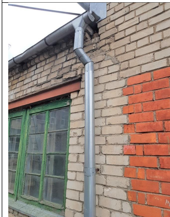
4.8.15.att. Cinkotā skārda notekcaurules apmierinošā tehniskajā stāvoklī
