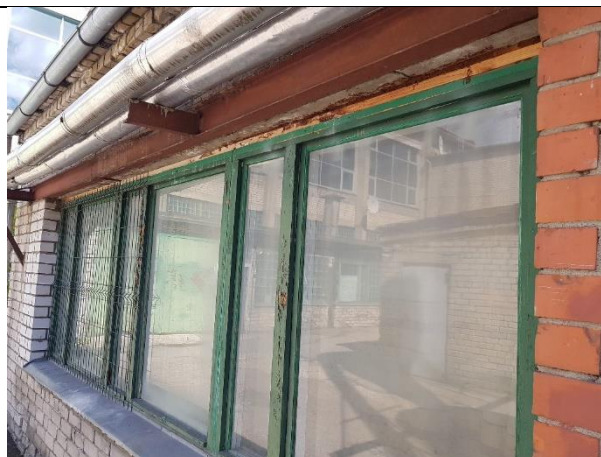
4.13.5.att. Koka logs neapmierinošā tehniskajā stāvoklī
