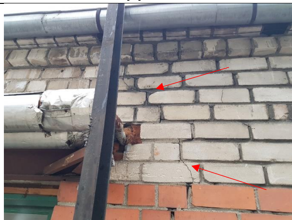
4.2.15.att. Loga ailes dubult-T profila pārsedze (h= 150 mm) ar korozijas bojājumiem
