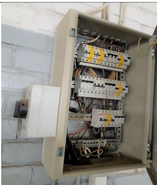
5.9.1.att. Elektroievada sadalnes skapis SS-52
