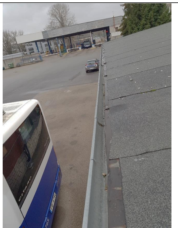
4.8.16.att. Cinkotā skārda notekrenes apmierinošā tehniskajā stāvoklī
