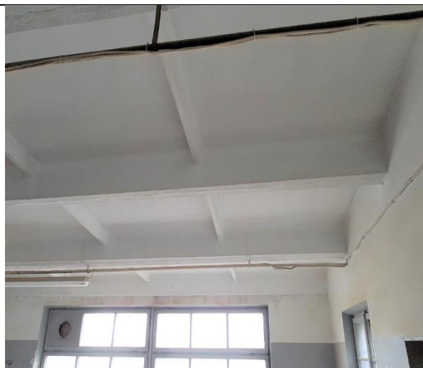
4.6.2.att. Dzelzsbetona pārseguma paneli telpā Nr.2
