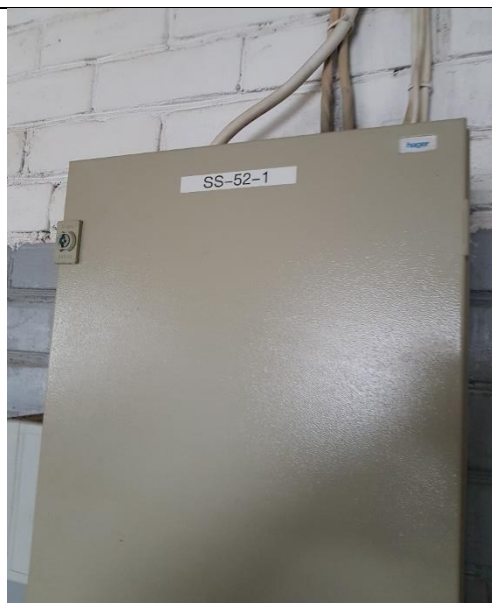
5.9.2.att. Elektrosadalne SS-52-1. Nav uzstādīta brīdinājuma zīme "Bīstami Elektrība"
