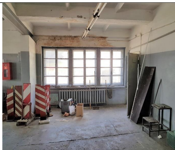
4.18.1.att. Ražošanas telpu sienu apdare ar eļļas krāsām un balsināti griesti. Mitruma radīti bojājumi un pelējums virs loga ailas.
