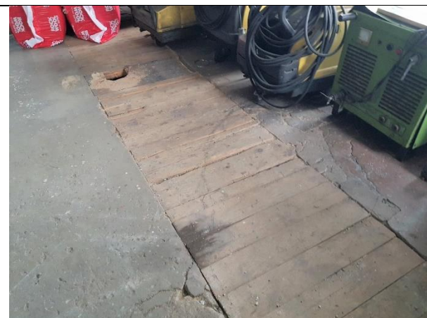
4.12.1.att. Betona grīda bez apdares telpā Nr.2 ar plaisām un izdrupumiem
