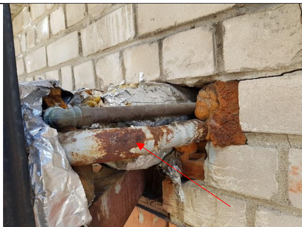
5.4.14.att. Apkures, aukstā un karstā ūdens ievads ēkā, cauruļvadiem bojāta siltumizolācija, ar korozijas bojājumiem.
