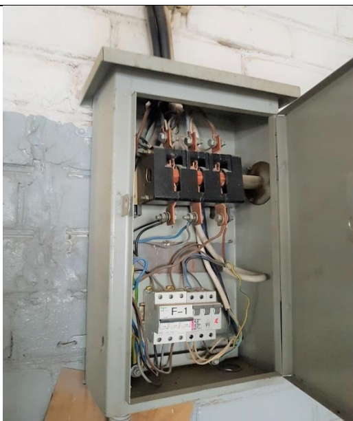
5.9.1.att. Elektroievada sadalnes skapis SS-52
