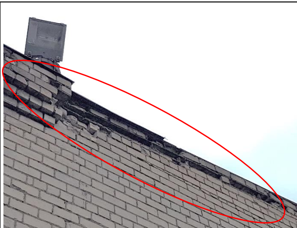
4.8.8.att. Blakus esošās ēkas (Vestienas iela 35 k-7) nesošās mūra sienas bojājumi
