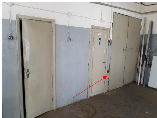
4.11.2.att. Mūra starpsiena telpā Nr.2. Nebūtisks izdrupums pie durvju aillas.
