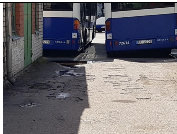
3.1.4.att. Asfaltbetona segums ar bedrēm, dienvidrietumu daļā, neapmierinošā tehniskajā stāvoklī
