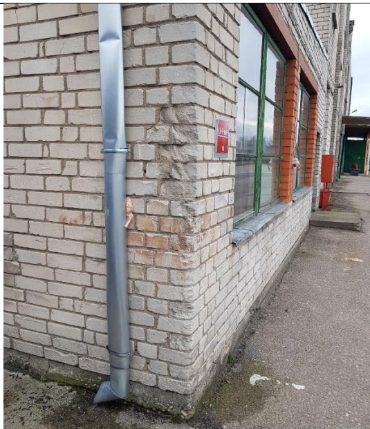
4.2.11.att. Mūra sienas mehāniski bojājumi
