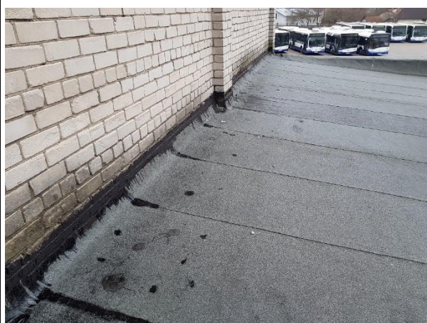
4.8.2.att. Bitumena ruļļveida materiāla segums labā tehniskajā stāvoklī
