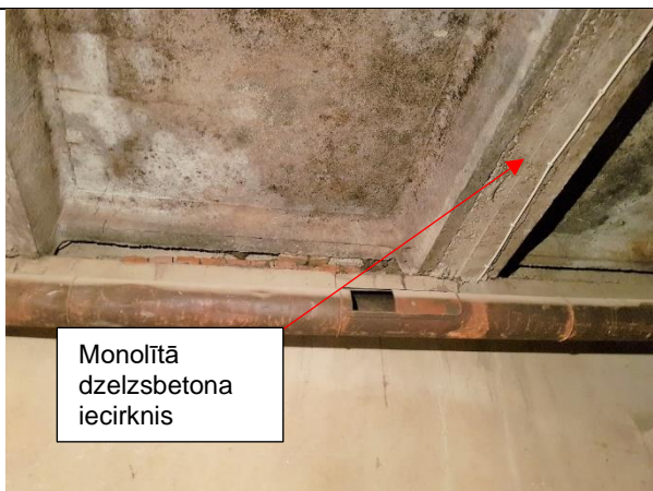
4.6.7.att. Dzelzsbetona pārseguma paneli telpā Nr.5 ar monolītā dzelzsbetona iecirkni.
