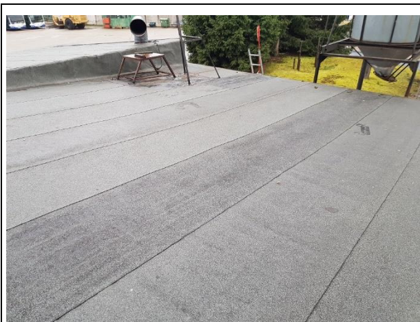
4.8.1.att. Bitumena ruļļveida materiāla segums labā tehniskajā stāvoklī
