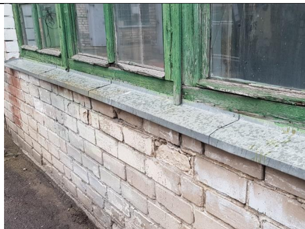
4.13.4.att. Koka logs neapmierinošā tehniskajā stāvoklī
