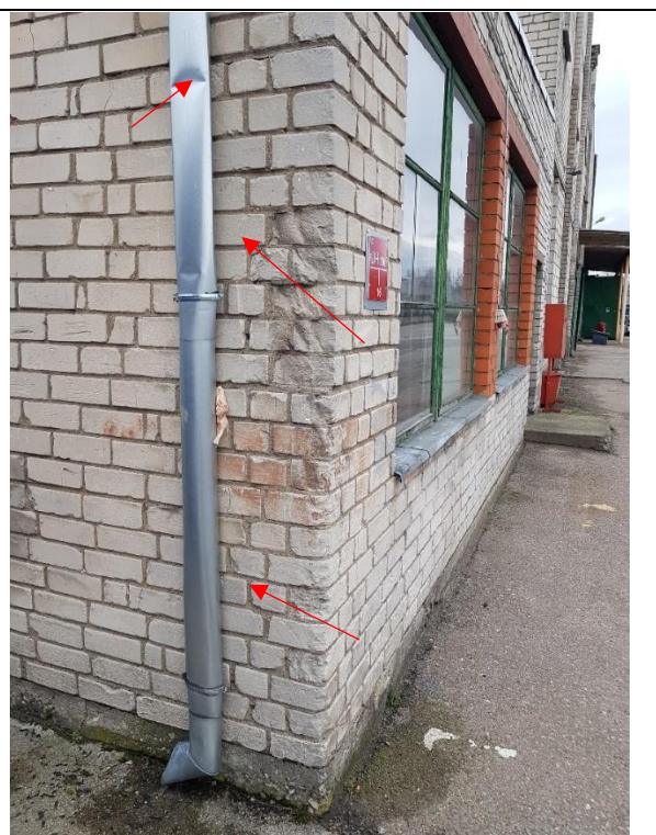
4.8.14.att. Cinkotā skārda notekcaurules ar mehāniskiem bojājumiem
