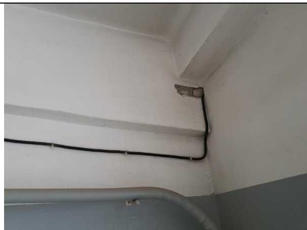
4.18.3.att. Ražošanas telpu sienu apdare ar eļļas krāsām un balsināti griesti. Izdrupums elektrokabeļa ievada vietā.
