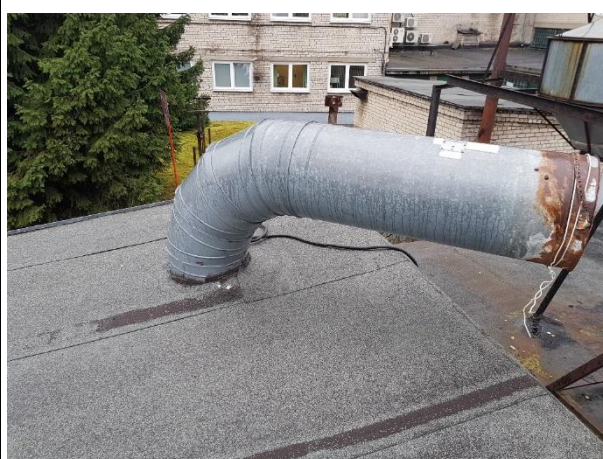
4.8.6.att. Skaidu nosūkšanas iekārtas cauruļvads (iekārta netiek ekspluatēta)
