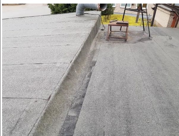
4.8.4.att. Bitumena ruļļveida materiāla segums labā tehniskajā stāvoklī
