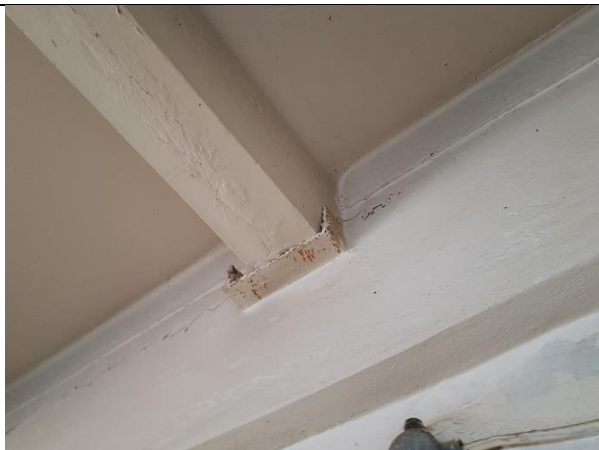
4.6.5.att. Dzelzsbetona pārseguma paneļu balsta mezgls uz mūra nesošās iekšsienas, telpā Nr.1
