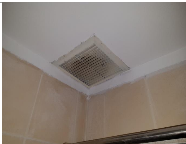
5.6.1.att. Nosūces ventilācijas reste telpā Nr.9. Nepieciešams attīrīt putekļu nosēdumus.
