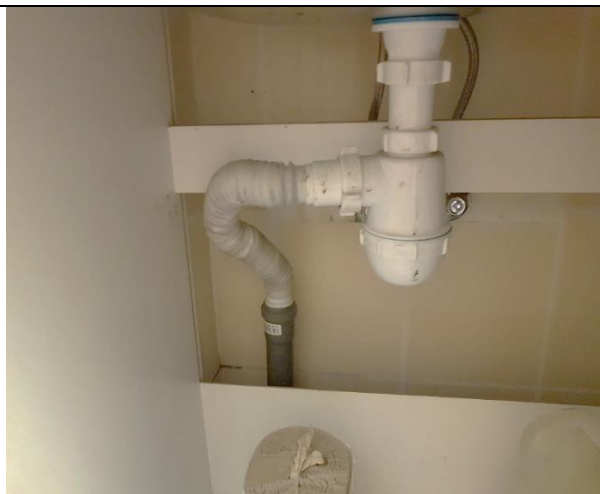
5.1.3.att. PVC kanalizācijas cauruļvadi (telpa Nr.8)
