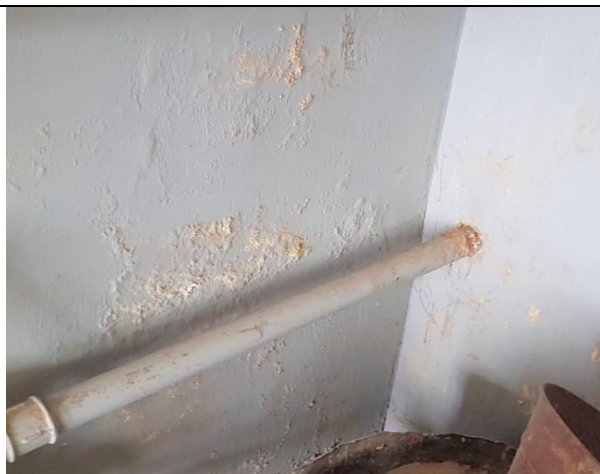
5.4.11.att. Apkures cauruļvads telpā Nr.2 ar korozijas pazīmēm. Mūra ārsiena ar mitruma bojājumiem.
