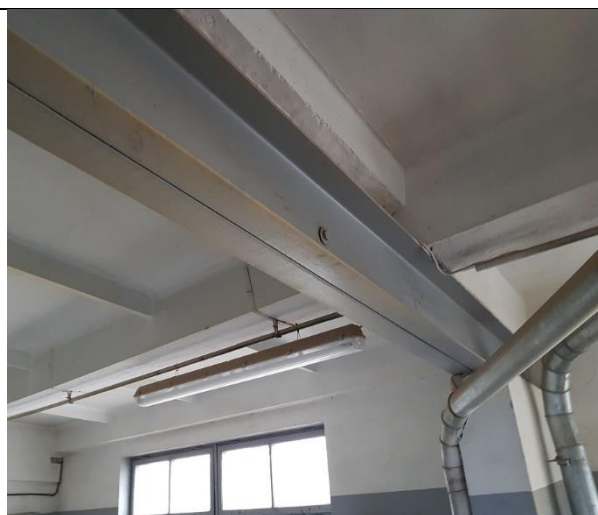
4.18.2.att. Ražošanas telpu sienu apdare ar eļļas krāsām un balsināti griesti.
