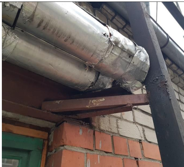
6.1.2.att. Cauruļvadu siltumizolācija ar nebūtiskiem bojājumiem
