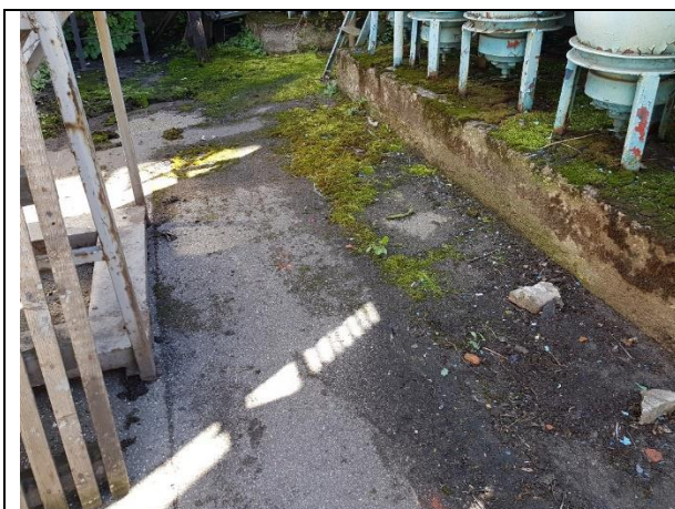
3.1.3.att. Asfaltbetona seguma laukums ēkas ziemeļu fasādes pusē, ar plaisām, izdrupumiem un apaugumu, neapmierinošā tehniskajā stāvoklī
