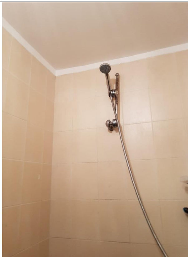
4.18.10.att. Sanitārā mezgla sienu apdare ar flīžu segumu. Griesti krāsoti ar ūdens emulsijas krāsu (telpa Nr.9)
