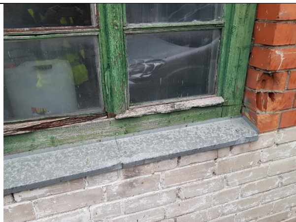
4.13.3.att. Koka logs neapmierinošā tehniskajā stāvoklī
