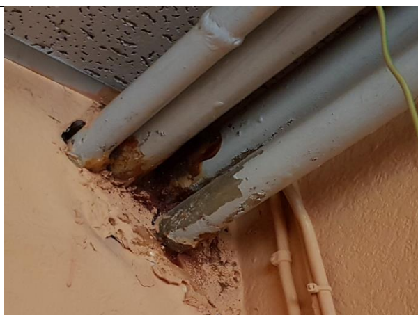
5.4.15.att. Apkures, aukstā un karstā ūdens cauruļvadi telpā Nr.7 ar korozijas bojājumiem
