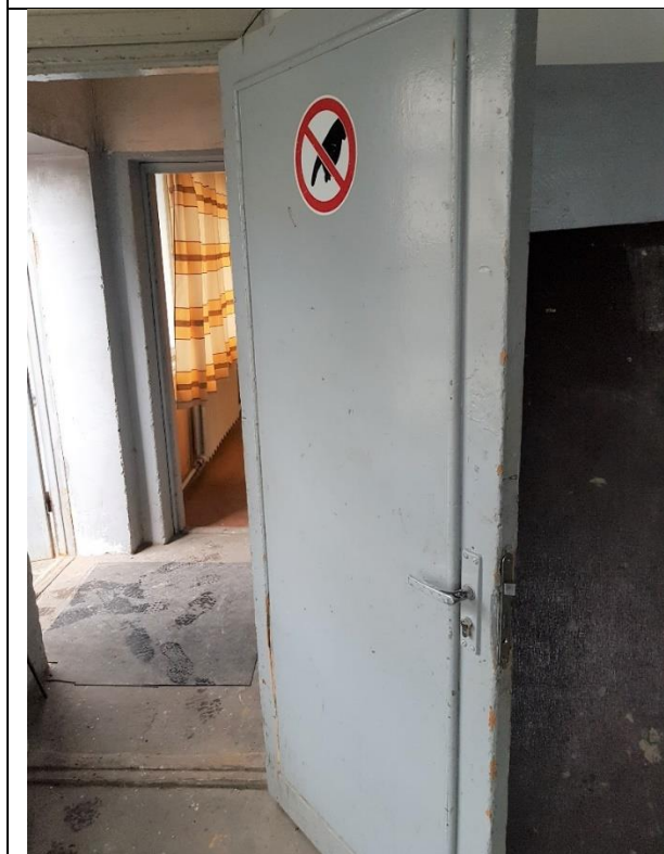
4.13.13.att. Koka iekšdurvis neapmierinošā tehniskajā stāvoklī
