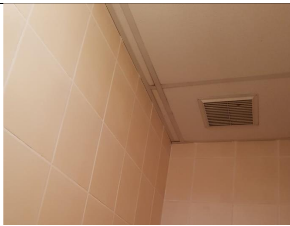
5.6.2.att. Nosūces ventilācijas reste telpā Nr.6. Nepieciešams attīrīt putekļu nosēdumus.
