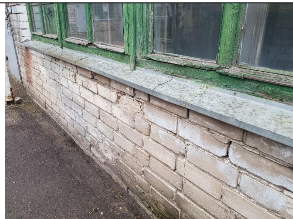
4.2.35.att. Mūra sienas bojājumi mitruma un sala ietekmē
