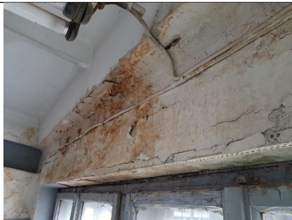
4.2.26.att. Mitruma izraisīti bojājumi nehermētiska jumta seguma un bojātas mūra dzegas ekspluatācijas laikā
