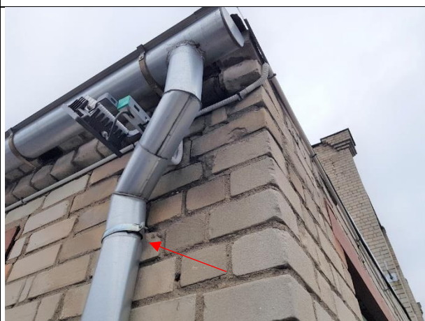
4.8.12.att. Cinkotā skārda notekcaurules ar mehāniskiem bojājumiem
