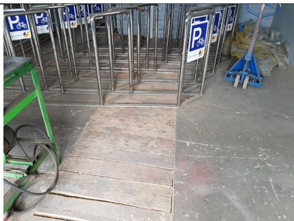
4.12.4.att. Betona grīda bez apdares telpā Nr.2 ar plaisām un izdrupumiem
