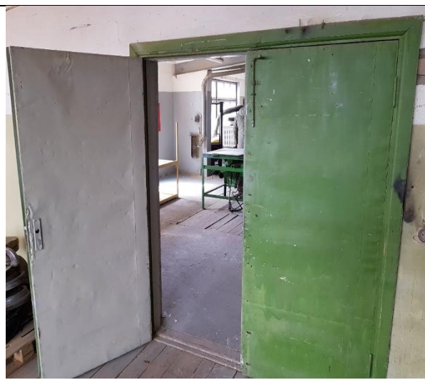
4.13.10.att. Koka divviru durvis ar skārda apdari daļēji apmierinošā tehniskajā stāvoklī
