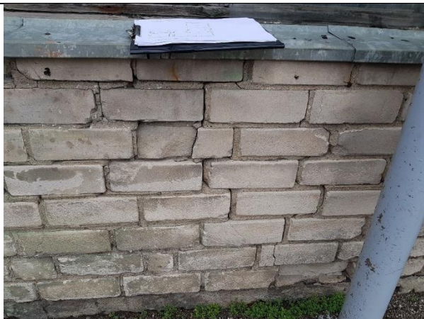
4.2.9.att. Nebūtiska plaisa mūra sienā zem loga aillas
