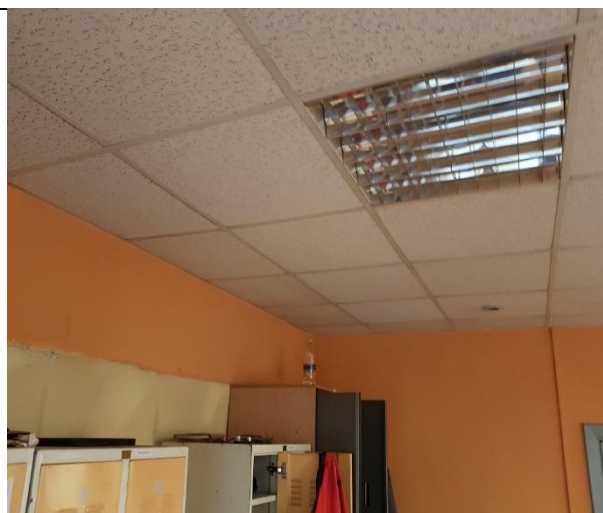
4.18.12.att. Sadzīves telpas Nr.7 sienu apdare ar krāsojamām tapetēm. Uzstādītas piekārto griestu konstrukcijas ar minerālšķiedras plātnēm.
