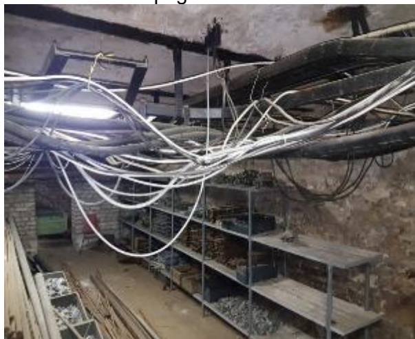
5.9.24. att. Nesakārtoti kabeļi un vadi pagrabstāvā
