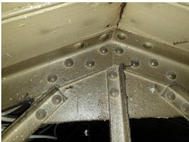
4.8.3.att. Tērauda kopņu jumta nesošās konstrukcijas
