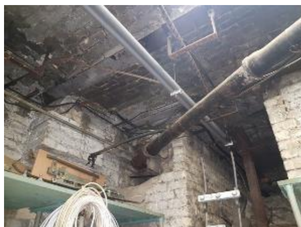
5.9.18. att. Apgaismojuma un spēka kabeli pagrabstāvā
