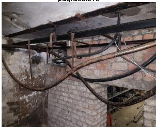
5.9.26. att. Nesakārtoti kabeļi pagrabstāvā
