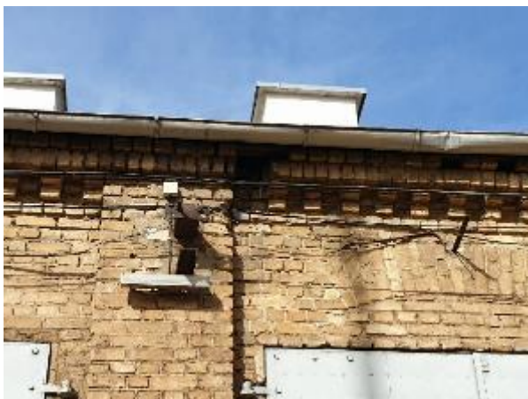
4.2.19.att. Nesošā ķieģeļu siena, mūra izdrupumi karnīzes daļā
