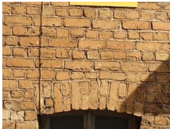
4.2.4.att. Nesošā ķieģeļu siena, nevienmērīgas sēšanās plaisa
