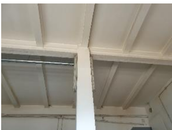
4.3.3. att. Karkasa elementi
