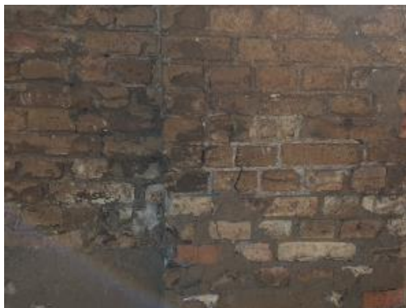
4.2.8.att. Nesošā ķieģeļu siena, nevienmērīgas sēšanās plaisa
