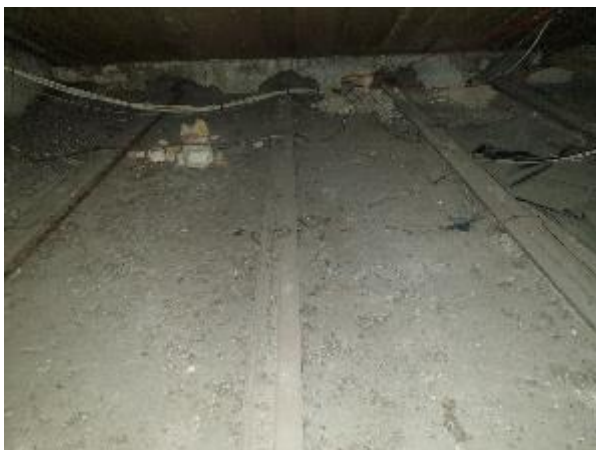
4.6.21.att. Bēniņu stāva pārsegums
