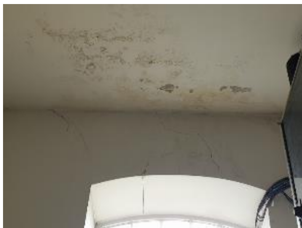
4.2.1.att. Nesošā ķieģeļu siena, nevienmērīgas sēšanās plaisa
