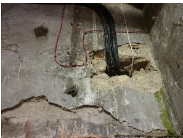
4.1.27.att. Ēkas pagrabstāvs, pēc inženiertīklu montāžas nav veikta atvērums aizpildīšana
