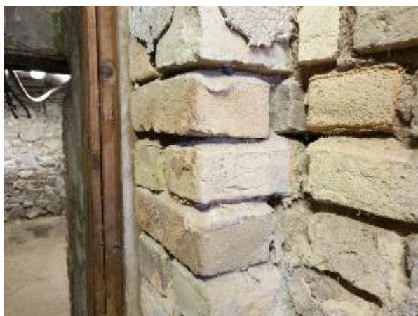
4.1.19.att. Ēkas pagrabstāvs, kapilārā mitruma radīti bojājumi, mūra erozija
