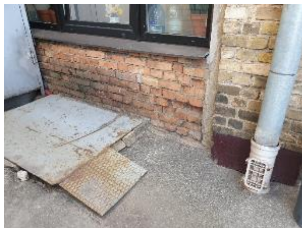
4.2.12.att. Nesošā ķieģeļu siena, nebūtiska mūra erozija
