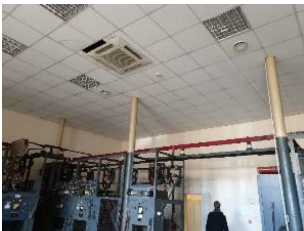
4.3.1.att. Karkasa elementi
