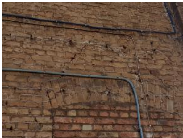
4.2.10.att. Nesošā ķieģeļu siena, nevienmērīgas sēšanās plaisa
