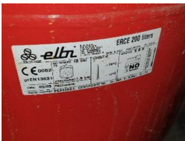
5.4.10.att. Apkures sistēmas izplešanās tvertne
