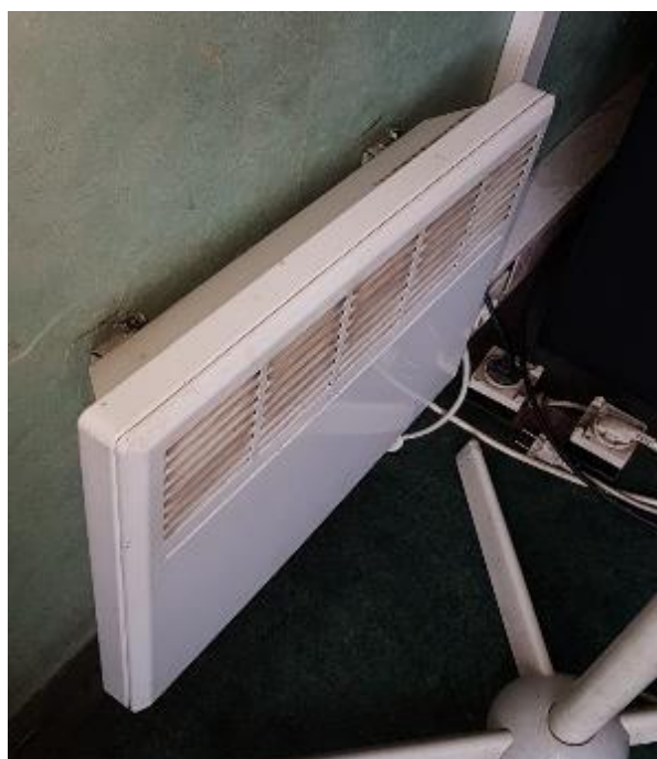
5.9.13. att. Elektriskais sildītājs 0,6kV līdzstrāvas sadalnes telpā
