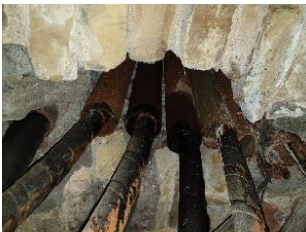
4.6.7.att. Pagrabstāva pārsegums, pēc inženiertīklu montāžas nav veikta pārseguma konstrukcijas atjaunošana
