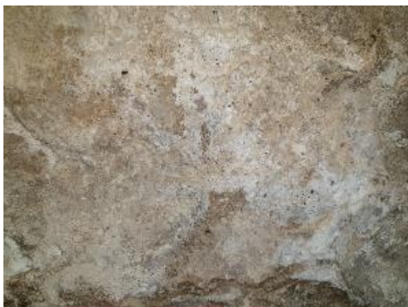
4.1.13.att. Ēkas pagrabstāvs, kapilārā mitruma radīti bojājumi
