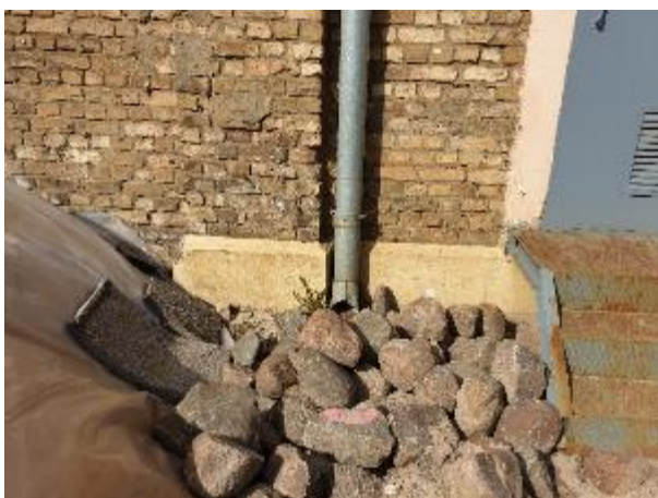
4.8.22.att. Lietus ūdens novadīšana sistēma, neefektīva un neatbilstoša lietus ūdeņu novadīšana
