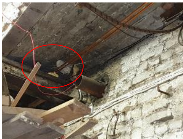
4.15.6.att. Inženiertīklu šķērsojums ugunsdrošajā konstrukcijā, veikta šķērsojumu aizdare ar neatbilstošiem būvizstrādājumiem
