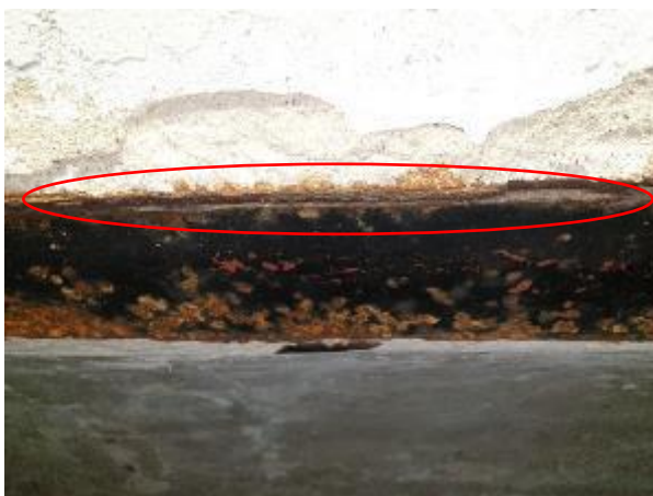
4.6.13 .att. Pagrabstāva pārsegums, būtiska metāla siju korozija
