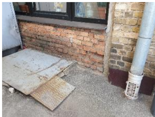
3.1.10.att. Asfaltbetona segums
