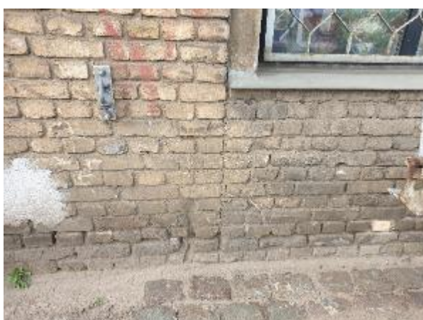
4.1.5.att. Nebūtiska pamata virszemes daļas mūra un mūrjavas erozija, uz virsmas izveidojies nebūtisks apsūnojums un izsālījumi
