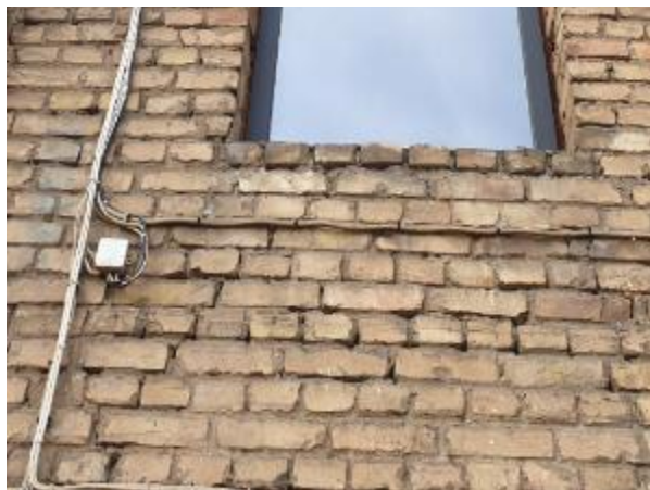
4.2.3.att. Nesošā ķieģeļu siena, nevienmērīgas sēšanās plaisa
