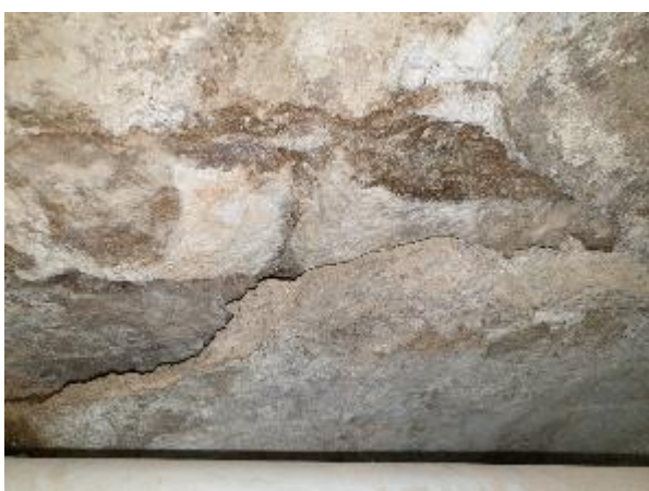
4.1.11.att. Ēkas pagrabstāvs, kapilārā mitruma radīti bojājumi
