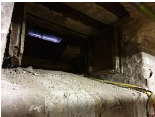
4.13.5.att. Ēkas pagrabstāva logi ar koka kārbu un vērtņēm
