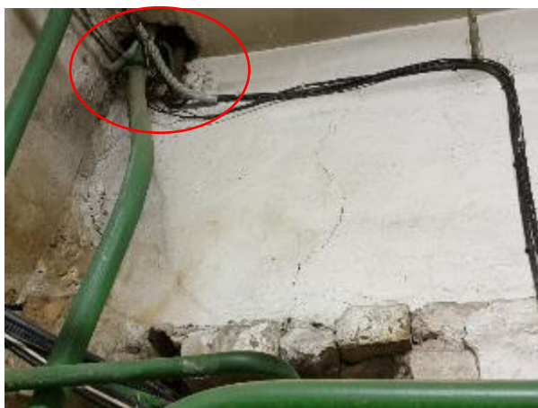
4.15.3.att. Inženiertīklu šķērsojums ugunsdrošajā konstrukcijā, nav veikta šķērsojuma aizdare
