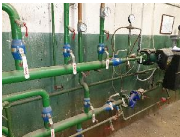
5.4.4.att. Apkures sistēmas siltummezgls
