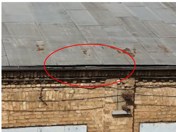
4.8.25.att. Lietus ūdens novadīšana sistēma, neatbilstošs sistēmas tekņu kritums
