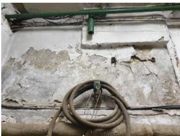
4.1.9.att. Ēkas pagrabstāvs, kapilārā mitruma radīti bojājumi
