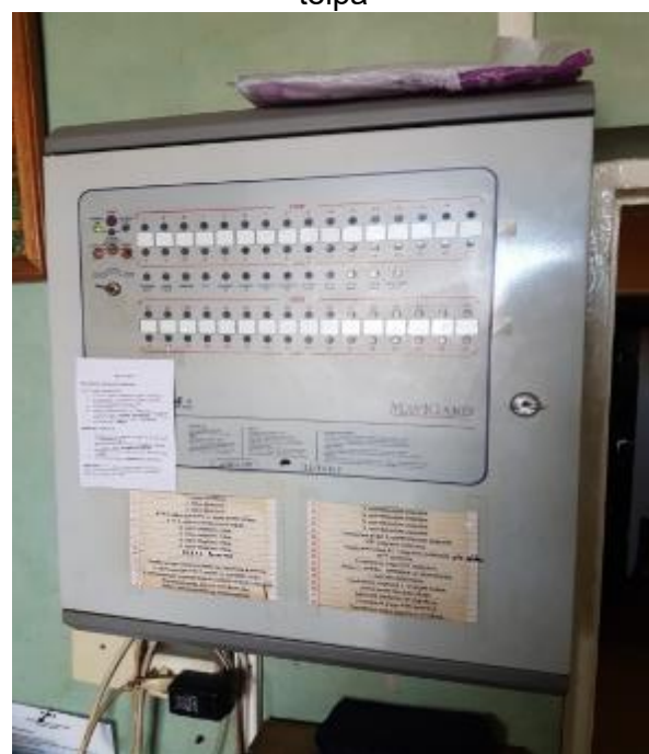
5.9.14. att. Ugunsdrošības signalizācijas panelis
