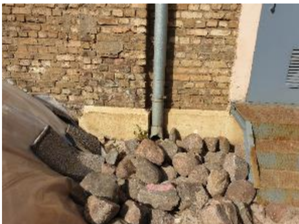
4.10.9.att. Kāpnes Nr.6, kāpņu bojājumi
