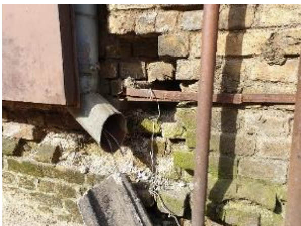
4.1.7.att. Būtiski mūra izdrupumi, uz virsmas izveidojies apsūņojums
