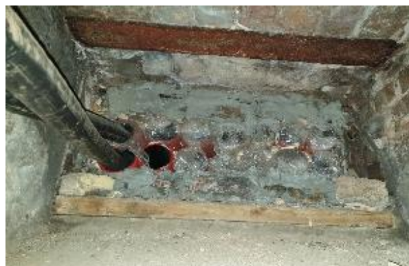
4.5.4.att. Inženiertīklu šķērsojums ēkas pamatu konstrukcijā, izmantoti neatbilstoši būvizstrādājumi
