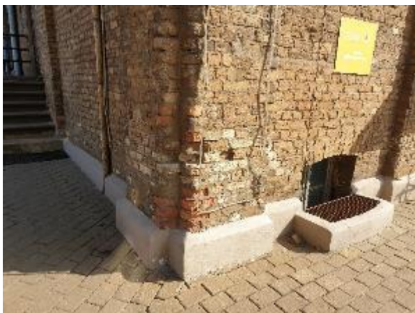
4.2.13.att. Nesošā ķieģeļu siena, nebūtiska mūra erozija, nebūtiski mūra izdrupumi
