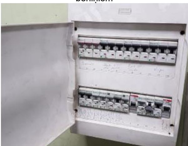
5.9.50. att. Spēka sadalne 2.stāvā
