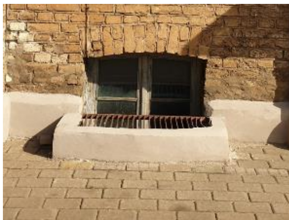
4.13.6.att. Ēkas pagrabstāva logi ar koka kārbu un vērtņēm
