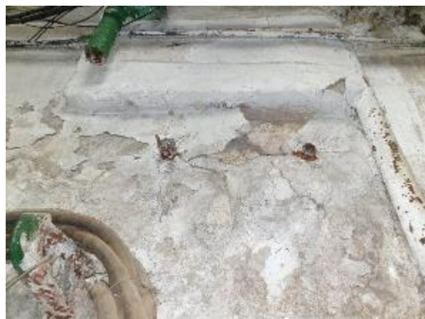
4.1.14.att. Ēkas pagrabstāvs, kapilārā mitruma radīti bojājumi
