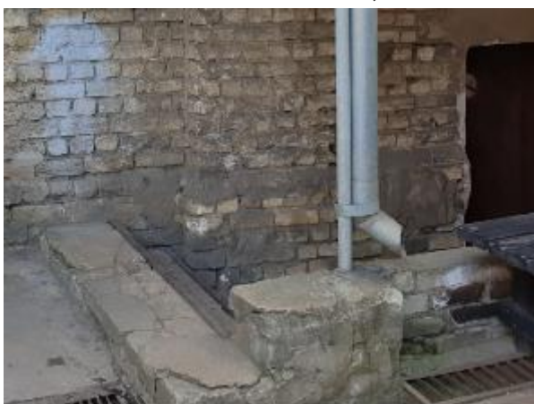
4.10.5.att. Kāpnes Nr.3, kāpņu bojājumi
