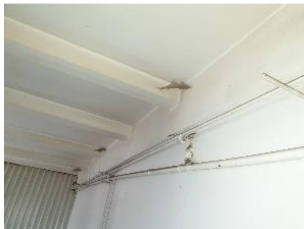
4.6.18.att. Pirmā stāva telpas Nr.3 pārsegums
