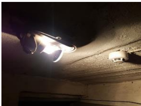
5.9.45. att. Gaismeklis bez aizsargvāka pagrabstāvā (ieeja no dzelzceļa puses)
