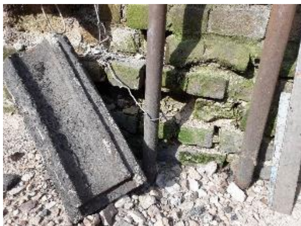
4.1.8.att. Būtiski mūra izdrupumi, uz virsmas izveidojies apsūņojums
