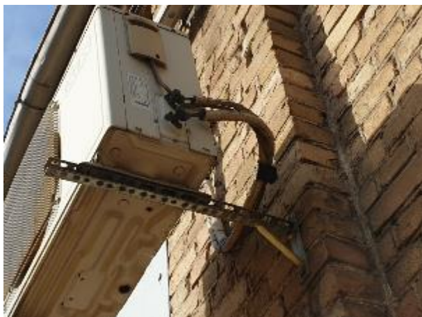
5.6.1.att. Dzesēšanas sistēmas ārējais bloks, nekvalitatīva cauruļvadu pretkondensāta izolācijas montāža
