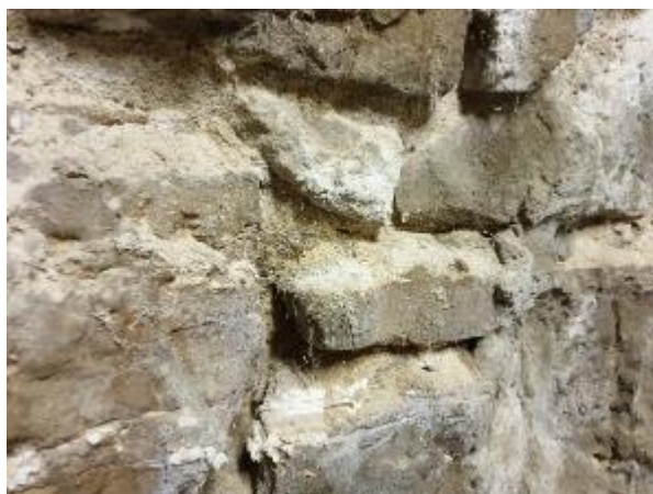
4.1.20.att. Ēkas pagrabstāvs, kapilārā mitruma radīti bojājumi, mūra erozija
