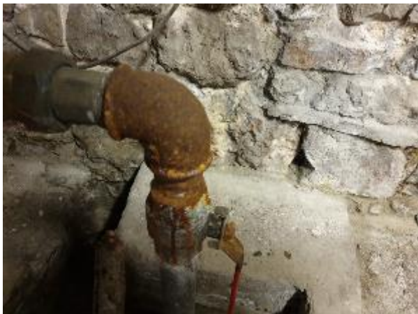
5.1.7.att. Aukstā ūdensvada ievada vieta, pastiprināta sistēmas elementu korozija
