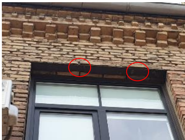
4.2.28.att. Metāla sijas pārsedzes, nebūtiska sijas korozija, sijas plauktu vājinājumi
