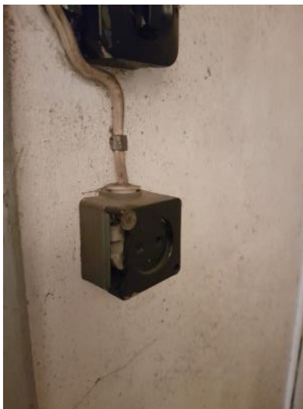
5.9.38. att. Bojāts kontaktligzdas korpuss pagrabstāvā (ieeja no dzelzceļa puses)
