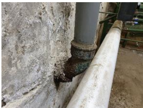
4.1.10.att. Ēkas pagrabstāvs, kapilārā mitruma radīti bojājumi
