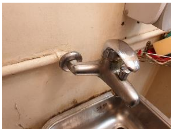
5.1.4.att. Aukstais ūdensvads, krāsoti melnā metāla cauruļvadi
