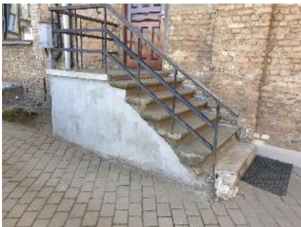
4.10.7.att. Kāpnes Nr.4, kāpņu bojājumi
