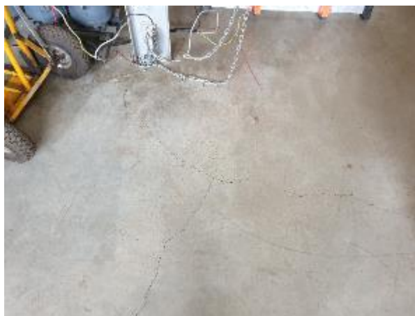
4.12.8.att. Betona grīdas segums ēkas pirmajā stāvā, betona virsmā konstatētas betona rukuma un deformāciju plaisas
