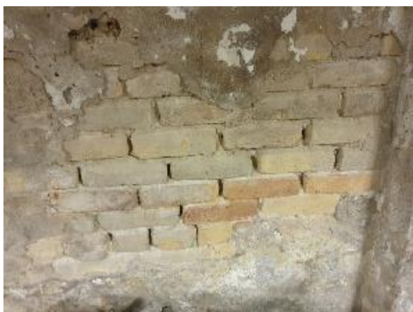
4.1.23.att. Ēkas pagrabstāvs, kapilārā mitruma radīti bojājumi, mūra erozija
