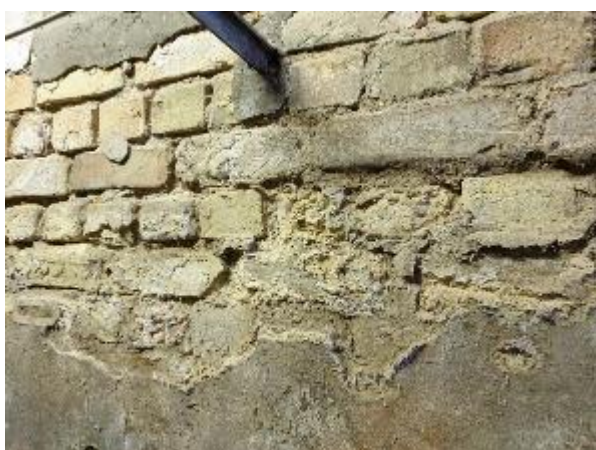
4.1.17.att. Ēkas pagrabstāvs, kapilārā mitruma radīti bojājumi, mūra erozija
