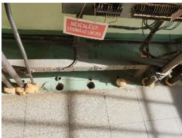
4.15.1.att. Inženiertīklu šķērsojums ugunsdrošajā konstrukcijā, nav veikta šķērsojuma aizdare, kā arī veikta šķērsojumu aizdare ar neatbilstošiem būvizstrādājumiem
