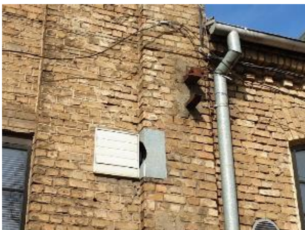
4.2.17.att. Nesošā ķieģeļu siena, nebūtiska mūra erozija
