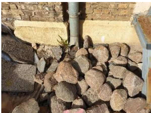
3.1.3.att. Granīta bruģakmens segums, bojāta seguma struktūra
