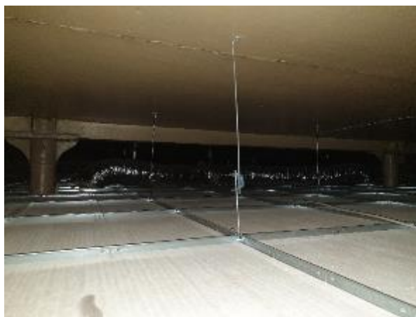
4.3.2.att. Karkasa elementi
