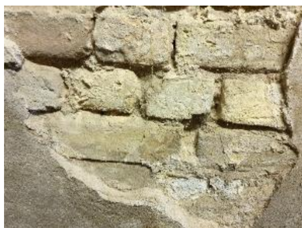
4.1.18.att. Ēkas pagrabstāvs, kapilārā mitruma radīti bojājumi, mūra erozija
