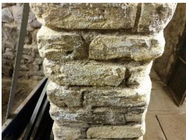
4.1.21.att. Ēkas pagrabstāvs, kapilārā mitruma radīti bojājumi, mūra erozija, mehāniski radīti mūra bojājumi
