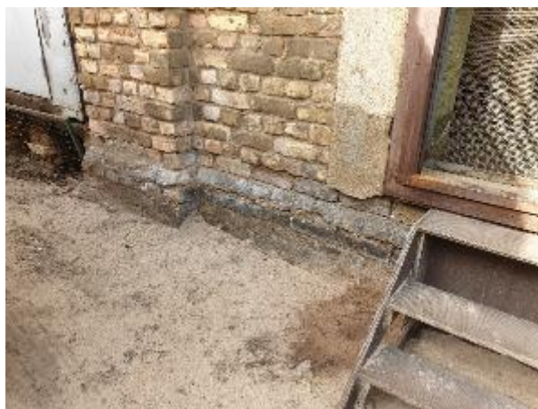
4.19.4.att. Ēkas ārējā apdare, uz virsmas izveidojies būtisks apsūnojums un izsāļējumi
