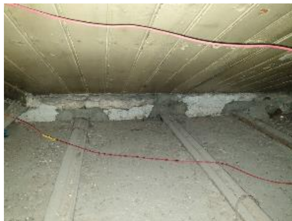
4.6.22.att. Bēniņu stāva pārsegums
