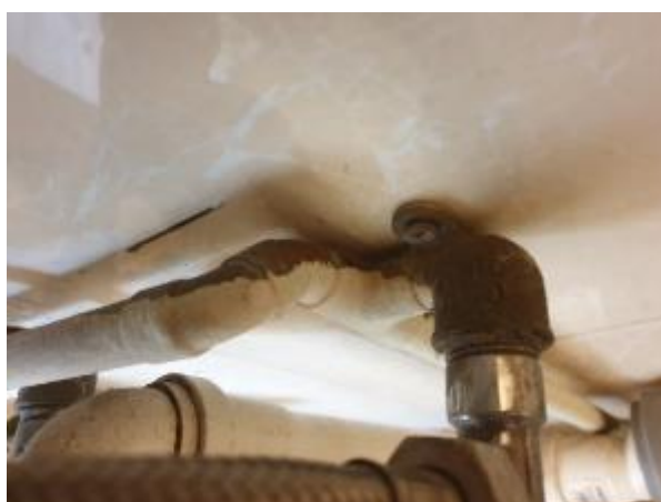
5.1.6.att. Aukstais ūdensvads, vara cauruļvadu pievads
