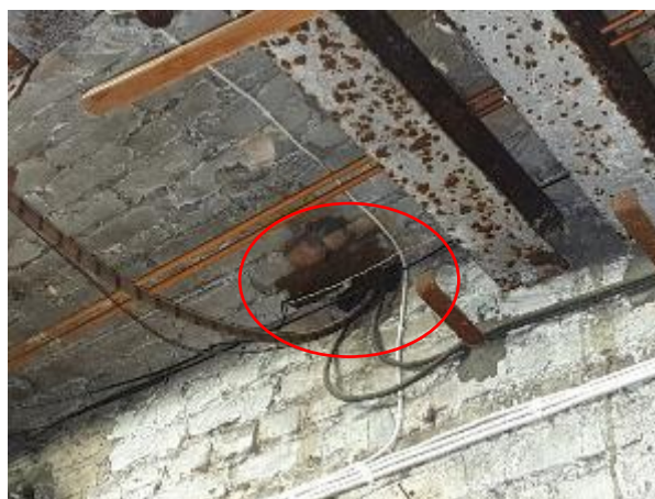
4.15.2.att. Inženiertīklu šķērsojums ugunsdrošajā konstrukcijā, nav veikta šķērsojuma aizdare
