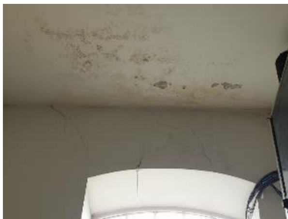
4.18.2.att. Ēkas iekšējā apdare, mitruma caursūkšanās rezultātā bojāta iekšējā apdare
