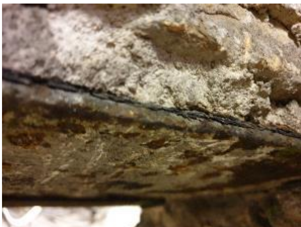
4.2.31.att. Metāla sijas pārsedzes, būtiska sijas korozija
