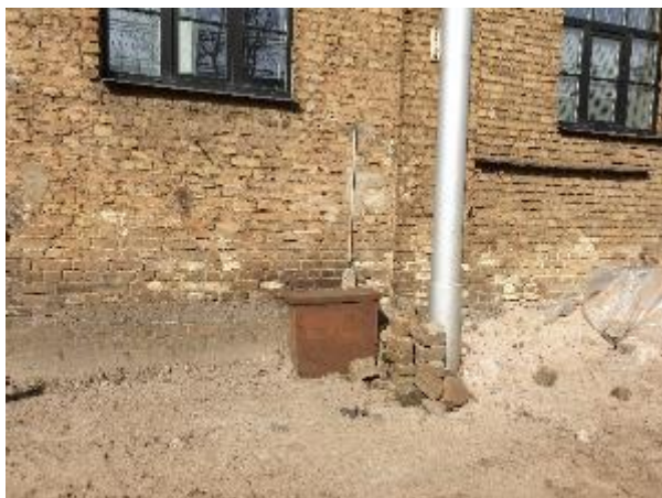
4.19.5.att. Ēkas ārējā apdare, uz virsmas izveidojies būtisks apsūnojums
