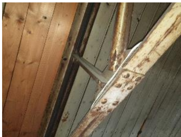
4.8.2.att. Tērauda kopņu jumta nesošās konstrukcijas
