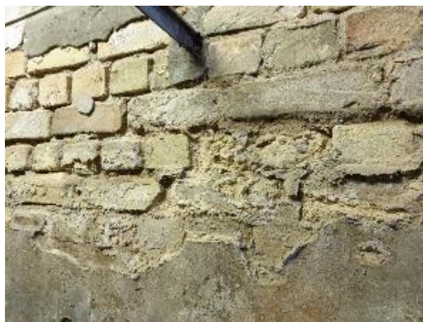
4.18.14.att. Pagrabstāva iekšējā apdare, kapilārā mitruma rezultātā radīti apdares bojājumi
