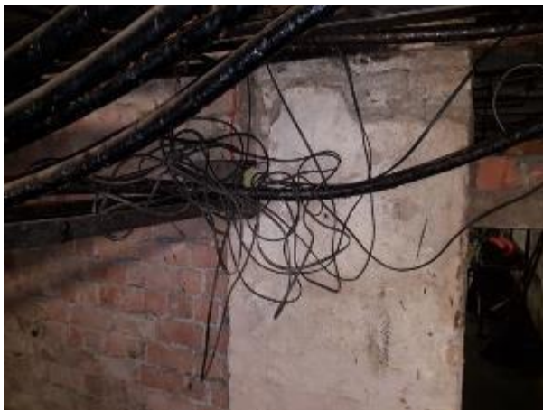
5.9.27. att. Nepieslēgts/nedemontēts kabelis pagrabstāvā
