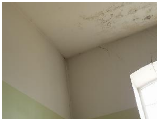
4.2.2.att. Nesošā ķieģeļu siena, nevienmērīgas sēšanās plaisa
