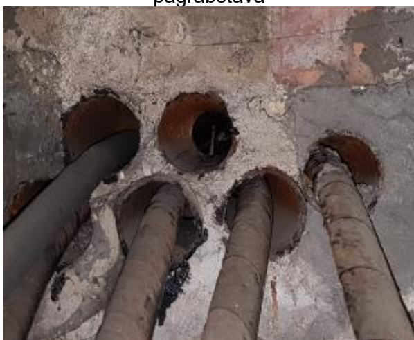
5.9.25. att. Kabeļu šķērsojums caur pagrabstāva nesošo sienu
