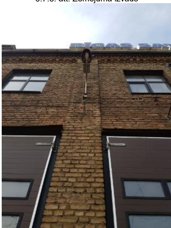
6.7.5. att. Gaismeklis ar dzīvsudraba gāzizlādes spuldzi
