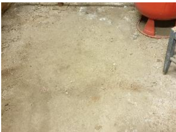
4.12.1.att. Betona grīdas segums ēkas pagrabstāvā, seguma nolietojums
