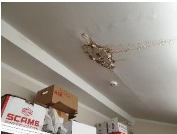
4.8.18.att. Mitruma caursūkšanās rezultātā radīti apdares bojājumi
