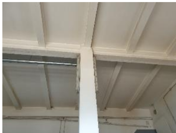
4.6.16.att. Pirmā stāva telpas Nr.3 pārsegums
