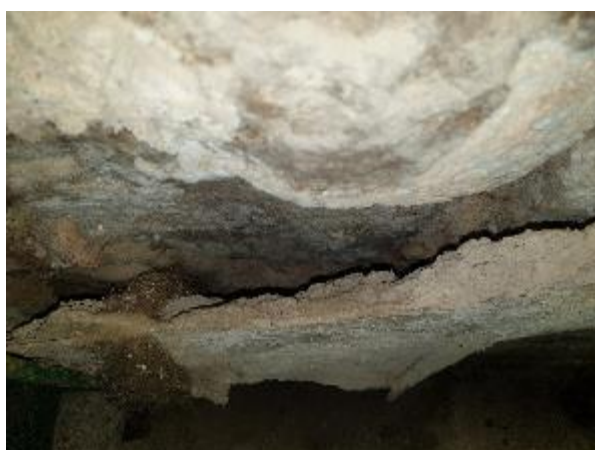
4.1.12.att. Ēkas pagrabstāvs, kapilārā mitruma radīti bojājumi
