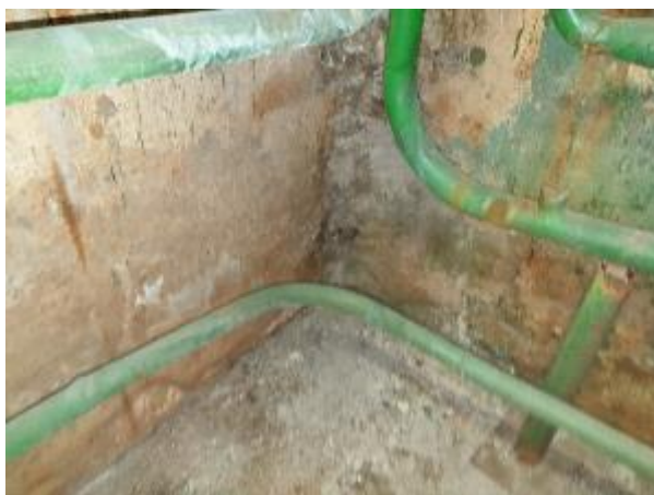
4.18.13.att. Pagrabstāva iekšējā apdare, kapilārā mitruma rezultātā radīti apdares bojājumi
