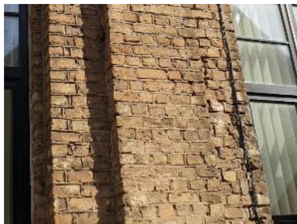
4.2.18.att. Nesošā ķieģeļu siena, nebūtiska mūra erozija
