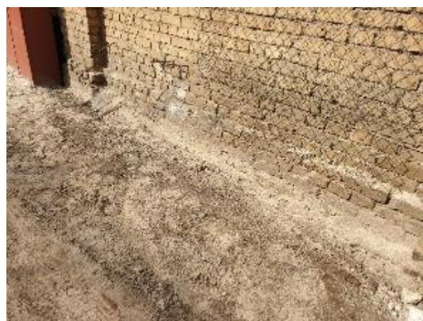
4.19.2.att. Ēkas ārējā apdare, uz virsmas izveidojies nebūtisks apsūnojums
