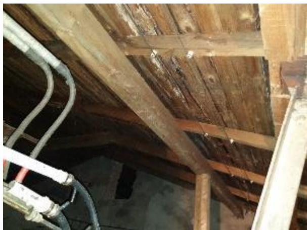
4.8.12.att. Jumta nesošās konstrukcijas
