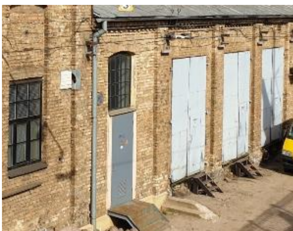
4.13.13.att. Transformatoru telpas vārti
