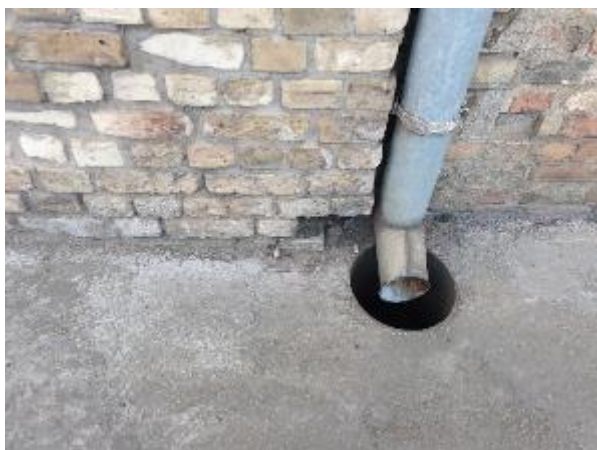
3.1.9.att. Asfaltbetona segums
