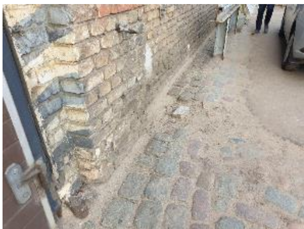
3.1.1.att. Granīta bruģakmens segums, bojāta seguma struktūra, uz seguma izveidojies smilšu slānis
