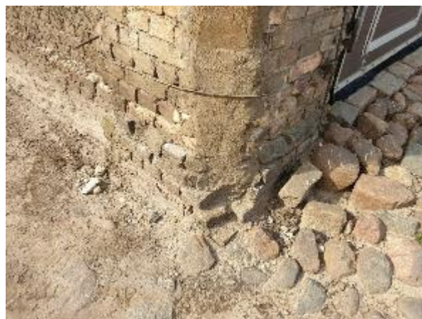
3.1.2.att. Granīta bruģakmens segums, bojāta seguma struktūra, uz seguma izveidojies smilšu slānis
