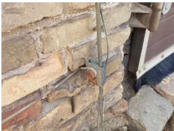
6.7.3. att. Zemējuma izvads
