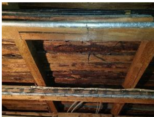
4.8.11.att. Jumta nesošās konstrukcijas
