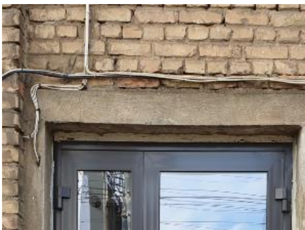
4.5.5.att. Ārdurvju montāžai izmantotas celtniecības putas, izveidota nekvalitatīva ārējā apdare/noblīvējums
