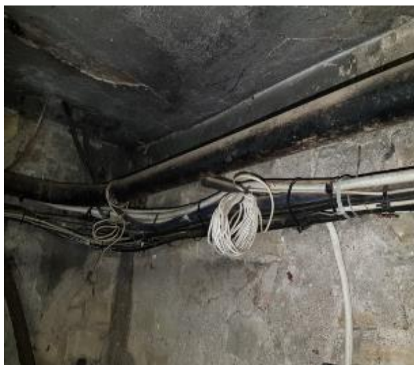
5.9.22. att. Nepieslēgts/nedemontēts kabelis pagrabstāvā
