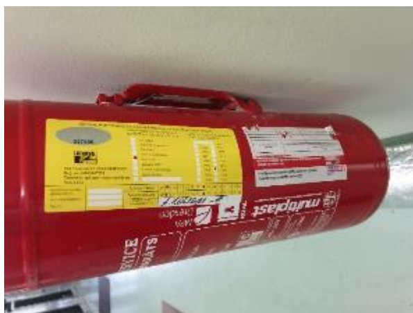
5.3.4.att. Izvietotais ugunsdzēsamais aparāts, izdarītas atzīmes par tehniskajām apkopēm
