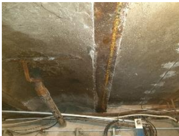
4.18.6.att. Ēkas iekšējā apdare, pagrabstāva apdare tehniski nolietojusies
