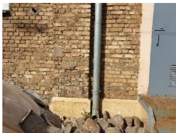
4.2.16.att. Nesošā ķieģeļu siena, nebūtiska mūra erozija
