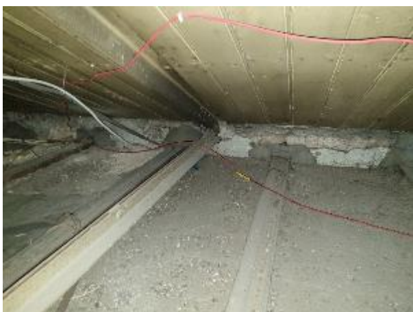
4.8.7.att. Tērauda kopņu jumta nesošās konstrukcijas
