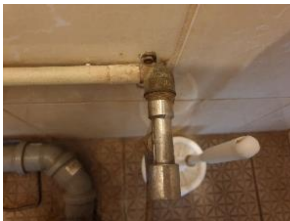
5.1.14.att. Sanitārtehniskās iekārtas pievienojums ar lokanās caurules palīdzību
