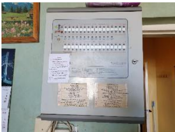
5.3.1.att. Automātiskās ugunsgrēka atklāšanas un trauksmes signalizācijas sistēmas panelis
