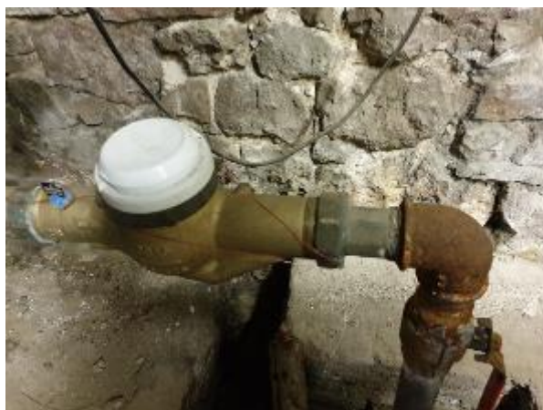
5.1.2.att. Aukstā ūdensvada ievada vieta un ievada vietā uzstādītais ūdens patēriņa uzskaites skaitītājs
