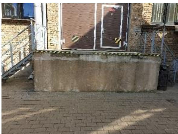
3.1.8.att. Betona bruģakmens segums
