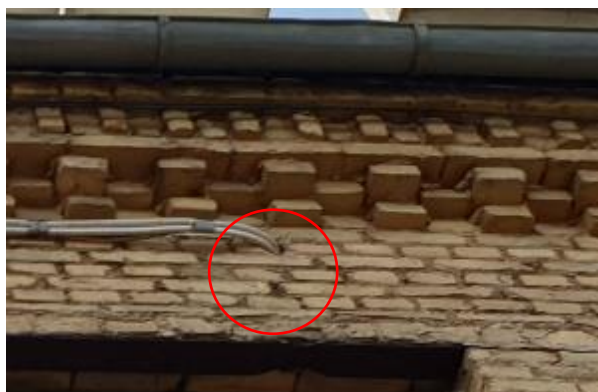
4.5.1.att. Inženiertīklu šķērsojums ēkas ār sienā, nav veikta šķērsojuma aizdare
