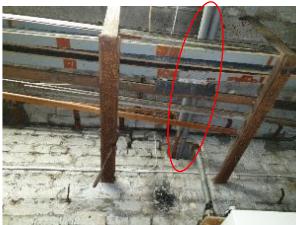
5.4.8.att. Apkures sistēmas turpgaitas un atpakaļgaitas cauruļvadi
