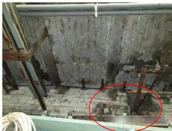
4.1.32.att. Ēkas pagrabstāvs, pēc inženiertīklu montāžas nav veikta atvērumu aizpildīšana
