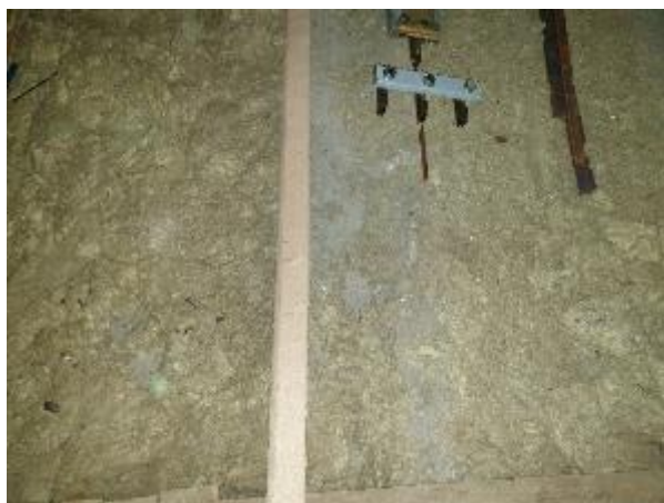
4.6.25.att. Bēniņu stāva pārsegums, ieklātais minerālvates siltumizolācijas slānis
