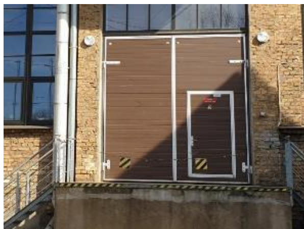
4.13.12.att. Ēkas tehnisko telpu vārti
