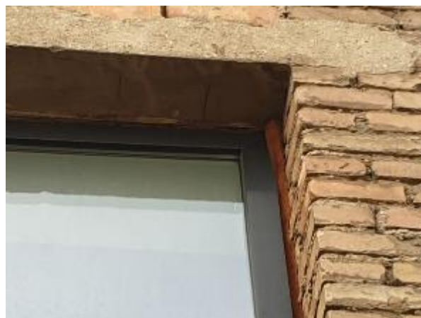
4.5.6.att. Logu montāžai izmantotas celtniecības putas, nav izveidota ārējā apdare
