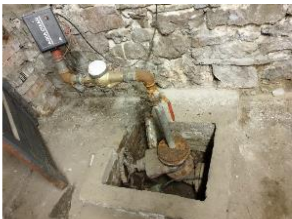
5.1.1.att. Aukstā ūdensvada ievada vieta un ievada vietā uzstādītais ūdens patēriņa uzskaites skaitītājs
