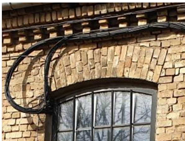
4.2.24.att. Ķieģeļu velvju pārsedze, nebūtiska mūra un mūrjavas erozija
