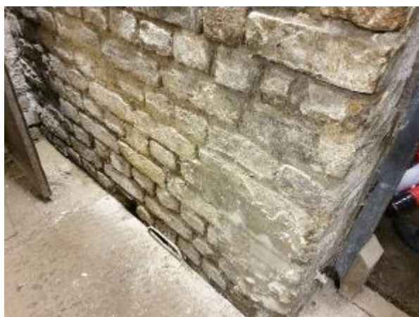
4.1.22.att. Ēkas pagrabstāvs, kapilārā mitruma radīti bojājumi, mūra erozija
