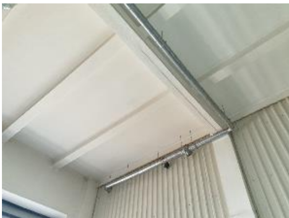
4.6.17.att. Pirmā stāva telpas Nr.3 pārsegums
