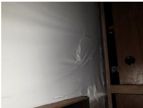
4.18.3.att. Ēkas iekšējā apdare, mitruma caursūkšanās rezultātā bojāta iekšējā apdare
