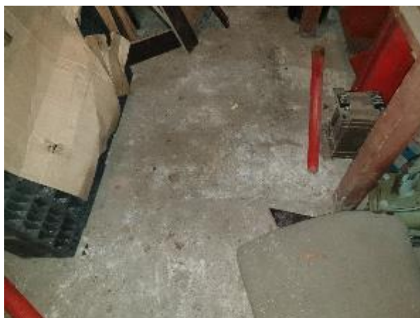
4.12.2.att. Betona grīdas segums ēkas pagrabstāvā, seguma nolietojums
