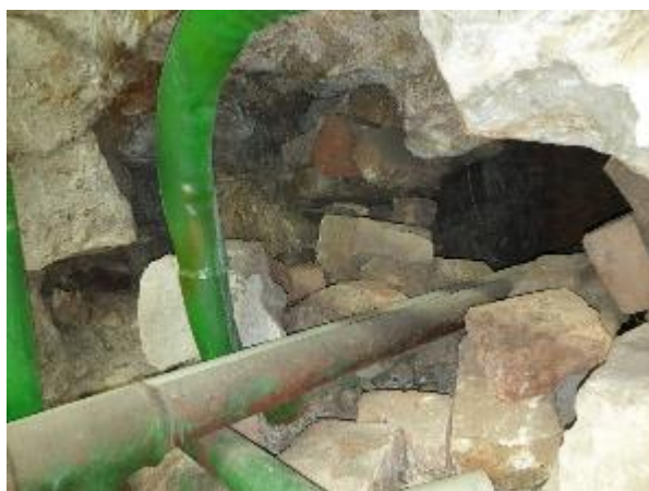
4.1.28.att. Ēkas pagrabstāvs, pēc inženiertīklu montāžas nav veikta atvērums aizpildīšana
