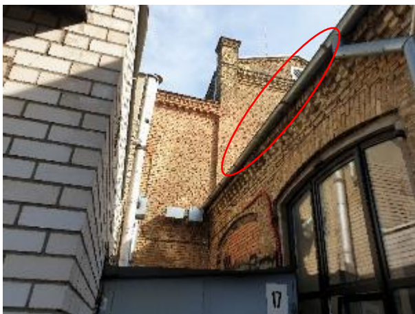
4.8.20.att. Lietus ūdens novadīšana sistēma, neatbilstoši sistēmas tekņu stiprinājumi
