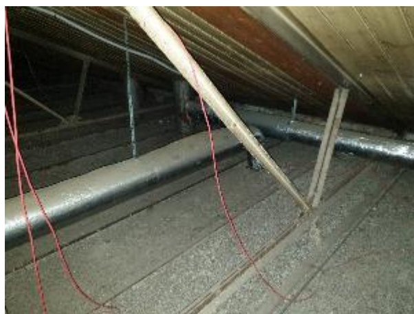
4.8.8.att. Tērauda kopņu jumta nesošās konstrukcijas
