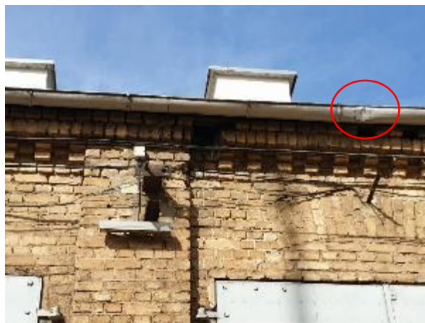
4.8.21.att. Lietus ūdens novadīšana sistēma, mehāniski bojāta sistēmas tekne
