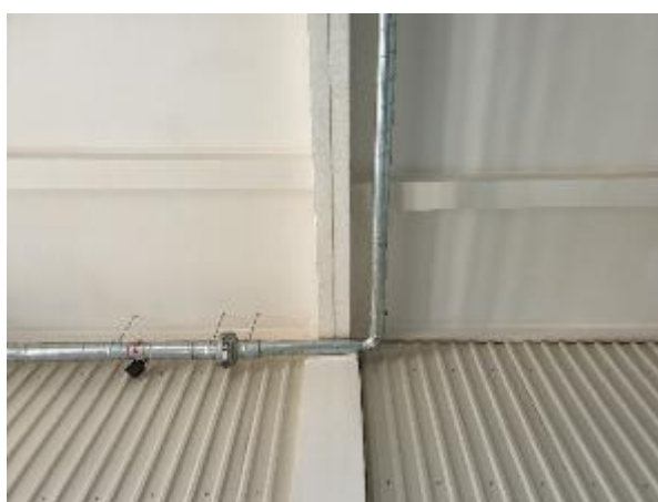
4.3.4. att. Karkasa elementi
