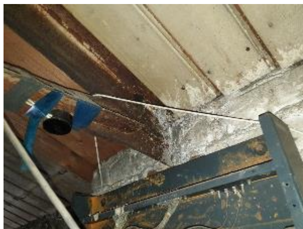
4.8.6.att. Tērauda kopņu jumta nesošās konstrukcijas
