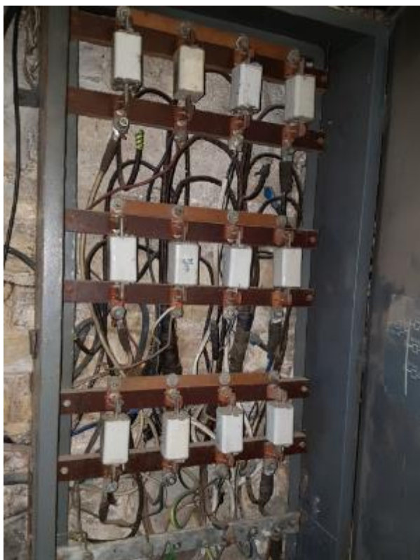
5.9.33. att. SS-18-1-3 sadalnes drošinātāji un aizējošo grupu kabelu pievienojumi
