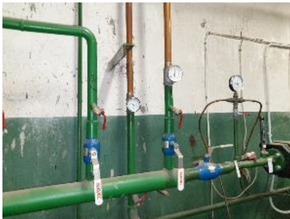
5.4.6.att. Apkures sistēmas turpgaitas un atpakaļgaitas cauruļvadi
