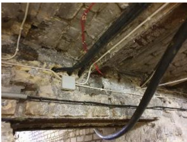
4.2.29.att. Metāla sijas pārsedzes, būtiska sijas korozija
