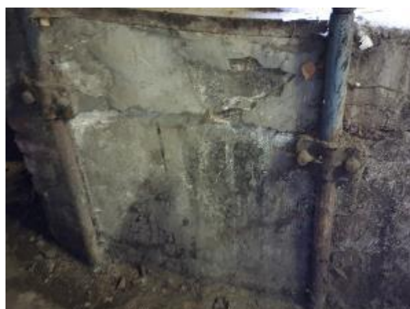
4.1.16.att. Ēkas pagrabstāvs, kapilārā mitruma radīti bojājumi
