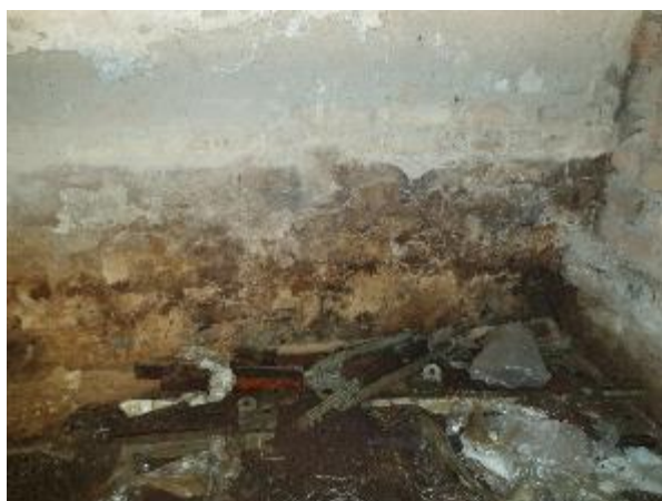
4.1.24.att. Ēkas pagrabstāvs, kapilārā mitruma radīti bojājumi
