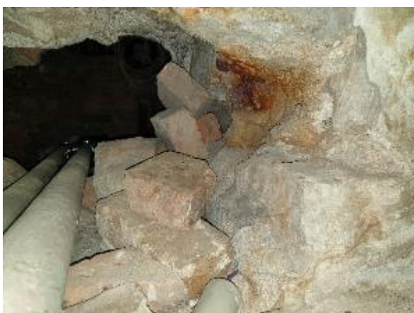
4.1.29.att. Ēkas pagrabstāvs, pēc inženiertīklu montāžas nav veikta atvērums aizpildīšana
