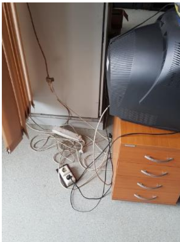
5.9.34. att. Nesakārtotie kabeli vilces apakšstacijas 0,6kV sadalnes telpā
