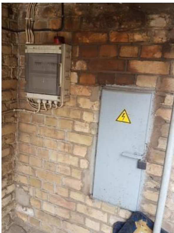
6.7.1. att. Āra sadalnes pie ieejas uz ēkas pagrabu
