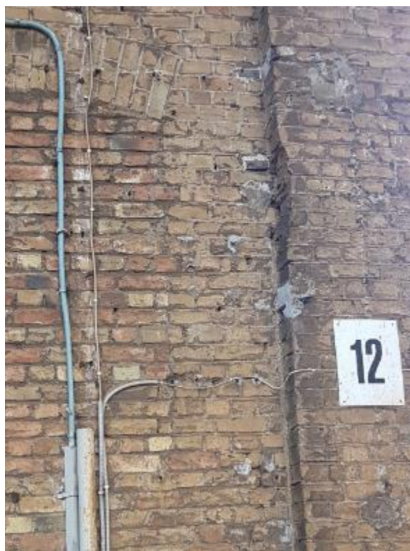
6.7.2. att. NYM kabeli uz ēkas fasādes bez aizsargcaurulēm
