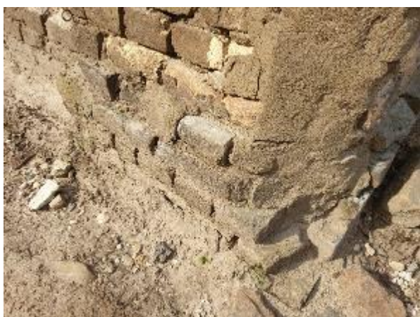
4.1.3.att. Nebūtiska pamata virszemes daļas mūra un mūrjavas erozija, uz virsmas izveidojies nebūtisks apsūnojums un izsālījumi
