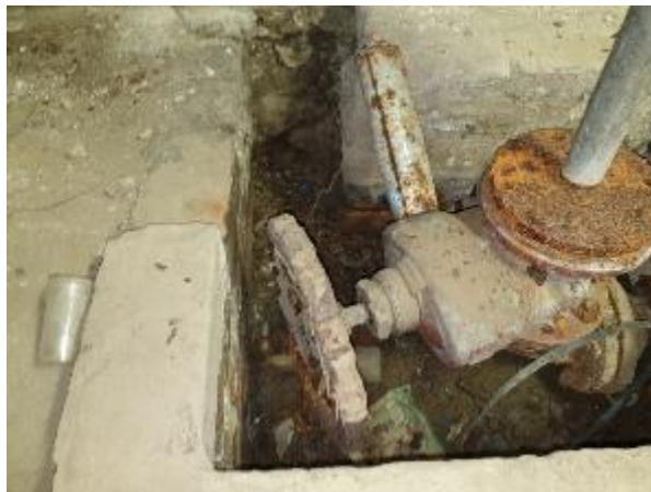
5.1.8.att. Aukstā ūdensvada ievada vieta, pastiprināta sistēmas elementu korozija
