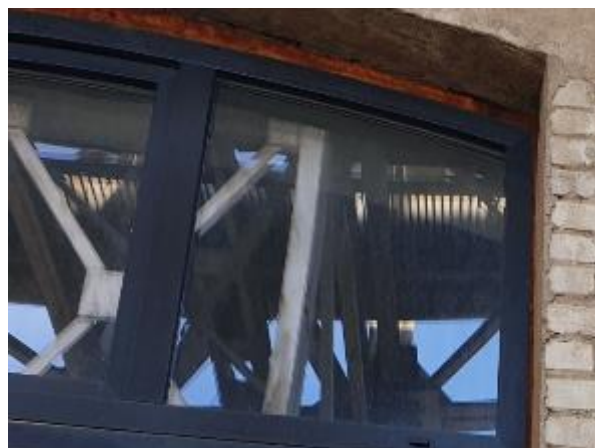
4.5.8.att. Logu montāžai izmantotas celtniecības putas, nav izveidota ārējā apdare
