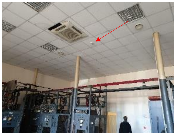
5.3.8.att. Izvietotais dūmu detektors
