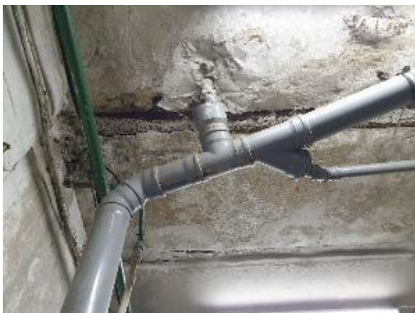
5.1.9.att. Sadzīves kanalizācijas PVC cauruļvadi
