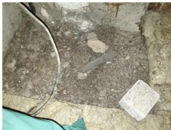
4.6.26.att. Bēniņu stāva pārsegums, ieklātais minerālvates siltumizolācijas slānis
