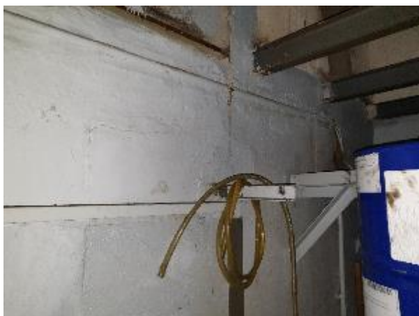
4.18.7.att. Ēkas iekšējā apdare, tehniskās telpas apdare tehniski nolietojusies
