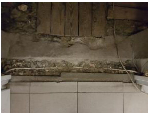
5.9.48. att. Kabelis ejā starp 2.stāva telpu un bēniņiem
