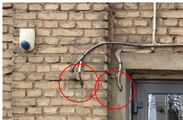
4.5.2.att. Inženiertīklu šķērsojums ēkas ār sienā, nav veikta šķērsojuma aizdare
