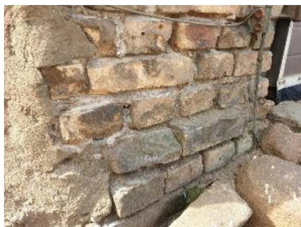
4.1.4.att. Nebūtiska pamata virszemes daļas mūra un mūrjavas erozija, uz virsmas izveidojies nebūtisks apsūnojums un izsālījumi
