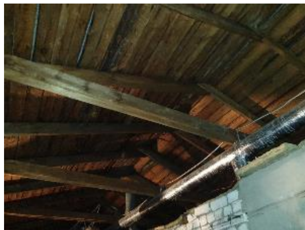
4.8.13.att. Jumta nesošās konstrukcijas
