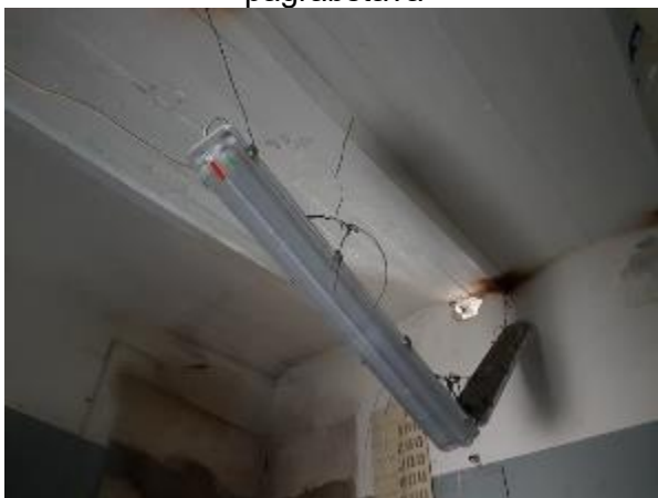
5.9.31. att. Nepiestiprinātie gaismekļi 1.stāva telpā (telpa Nr.30)
