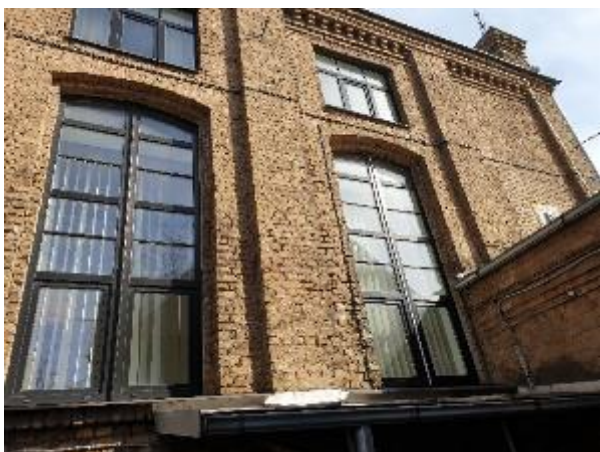
4.13.3.att. Logi ar PVC kārbu un stikla pakešu pildījumu
