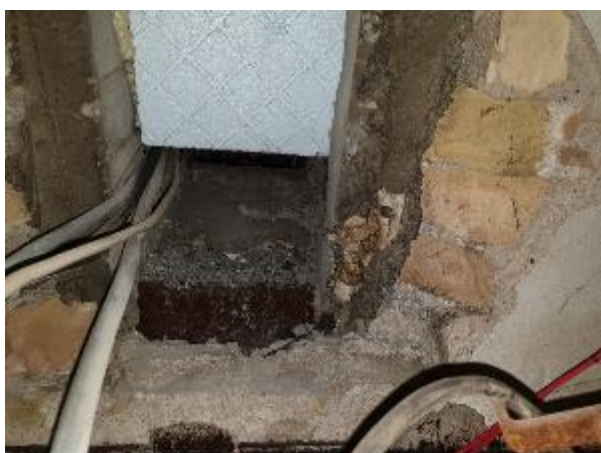
4.15.7.att. Inženiertīklu šķērsojums ugunsdrošajā konstrukcijā, veikta šķērsojumu aizdare ar neatbilstošiem būvizstrādājumiem
