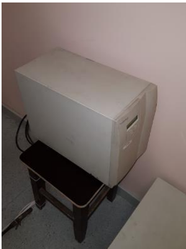
5.9.37. att. 1,4 kW UPS iekārta taisngriežu telpā
