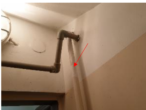
5.1.5.att. Aukstais ūdensvads, krāsoti melnā metāla cauruļvadi
