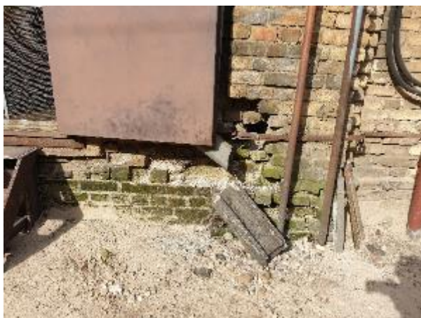
4.19.3.att. Ēkas ārējā apdare, uz virsmas izveidojies būtisks apsūnojums
