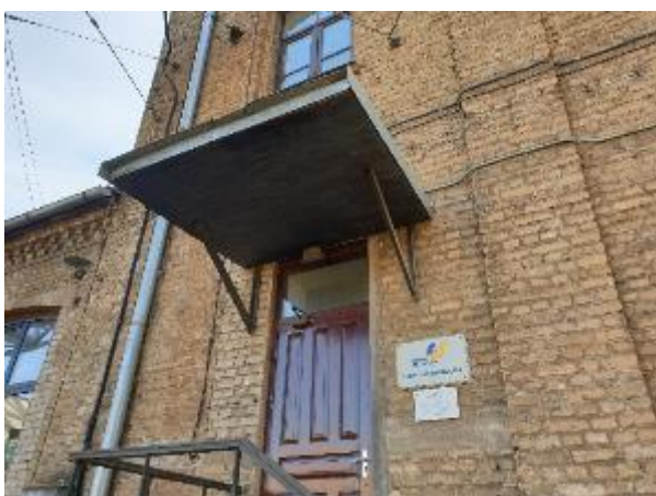
4.13.9.att. Ēkas koka ārdurvis
