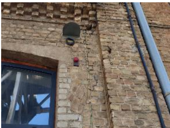
4.2.11.att. Nesošā ķieģeļu siena, nevienmērīgas sēšanās plaisa
