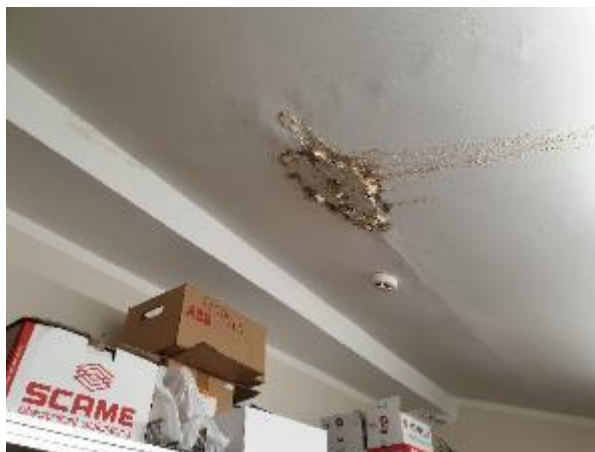
4.18.4.att. Ēkas iekšējā apdare, mitruma caursūkšanās rezultātā bojāta iekšējā apdare
