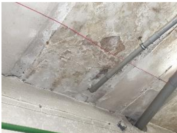
4.18.9.att. Ēkas iekšējā apdare, pagrabstāva apdare tehniski nolietojusies
