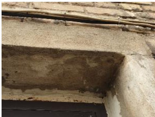
4.2.26.att. Metāla siju pārsedze, saplaisājis apmetums
