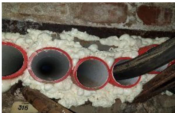
4.5.3.att. Inženiertīklu šķērsojums ēkas pamatu konstrukcijā, izmantoti neatbilstoši būvizstrādājumi
