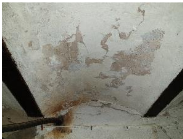
4.18.8.att. Ēkas iekšējā apdare, pagrabstāva apdare tehniski nolietojusies
