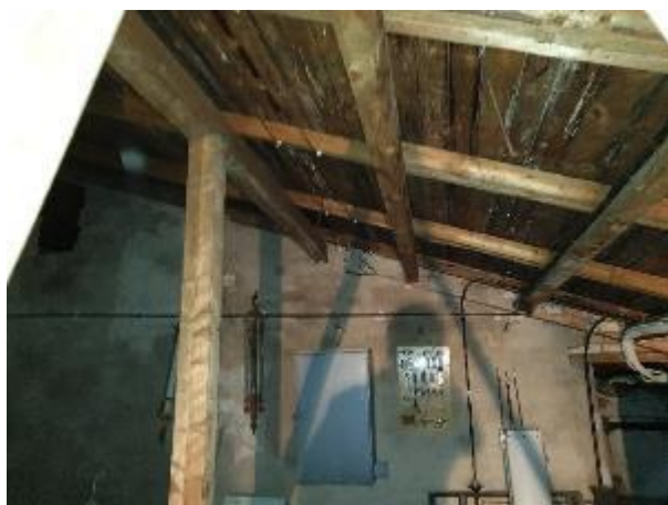
4.8.10.att. Jumta nesošās konstrukcijas
