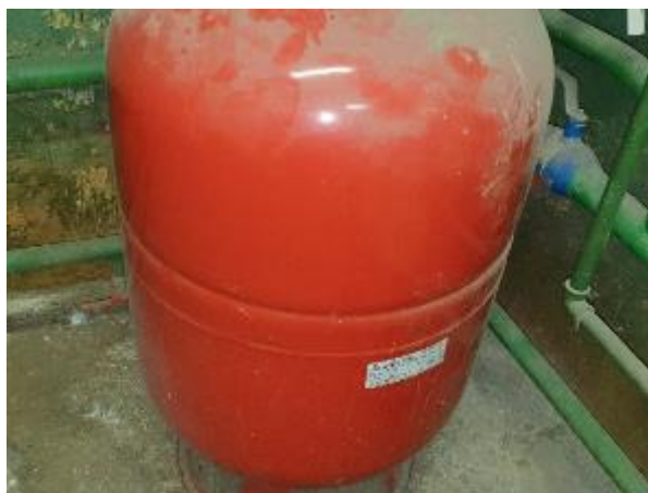
5.4.9.att. Apkures sistēmas izplešanās tvertne
