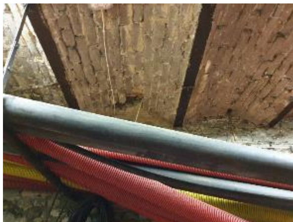
4.6.4.att. Pagrabstāva pārsegums, velvju mūra un mūrjavas erozija, mūra izdrupumi
