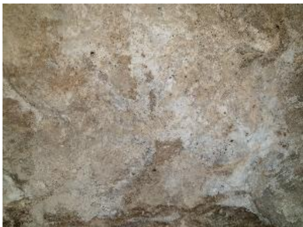
4.18.11.att. Pagrabstāva iekšējā apdare, kapilārā mitruma rezultātā radīti apdares bojājumi
