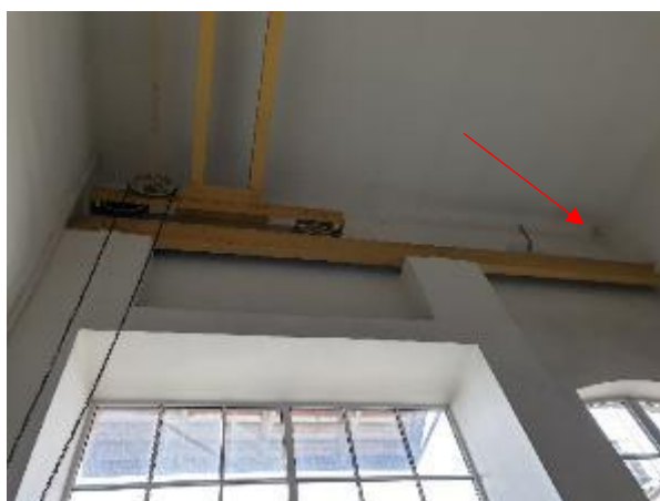
5.3.10.att. Izvietotais dūmu detektors
