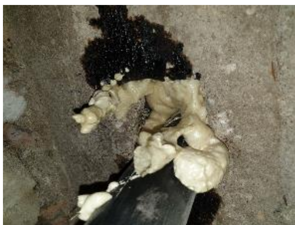
4.15.8.att. Inženiertīklu šķērsojums ugunsdrošajā konstrukcijā, veikta šķērsojumu aizdare ar neatbilstošiem būvizstrādājumiem
