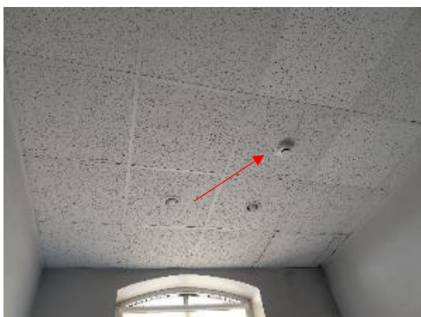
5.3.9.att. Izvietotais dūmu detektors
