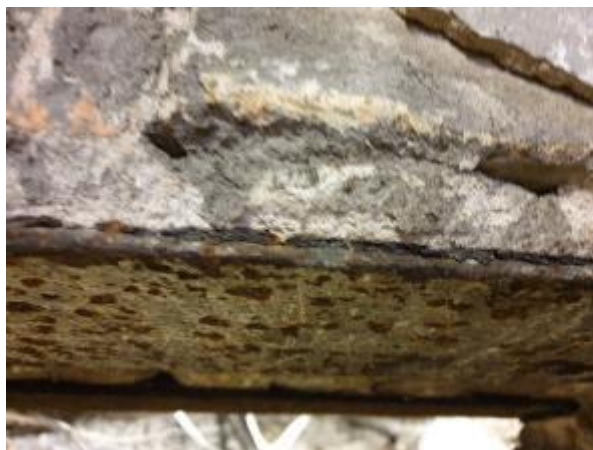
4.2.32.att. Metāla sijas pārsedzes, būtiska sijas korozija
