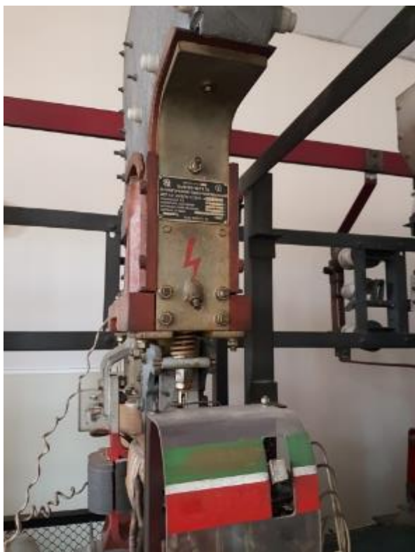
5.9.5. att. Līdzstrāvas ātrdarbīgs automātslēdzis
