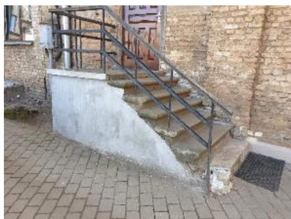
3.1.8.att. Betona bruģakmens segums
