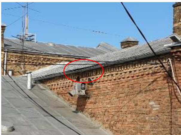
4.8.24.att. Lietus ūdens novadīšana sistēma, neatbilstošs sistēmas tekņu kritums
