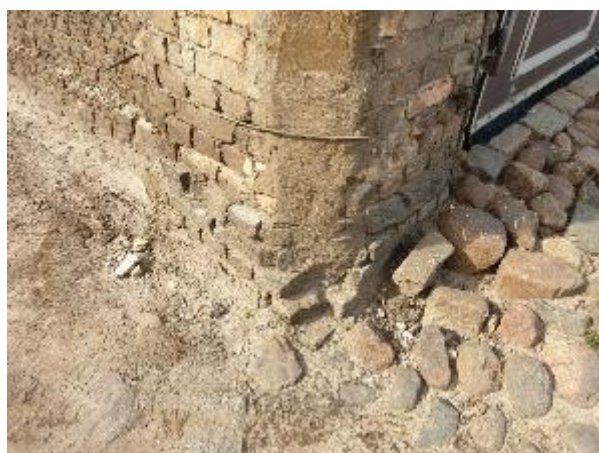
4.19.1.att. Nebūtiska mūra un mūrjavas erozija, uz virsmas izveidojies nebūtisks apsūnojums un izsāļījumi
