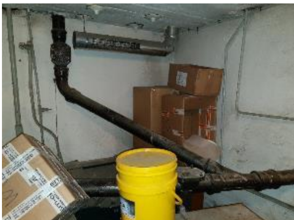
5.1.11.att. Sadzīves kanalizācijas ķeta cauruļvadu stāvvadi
