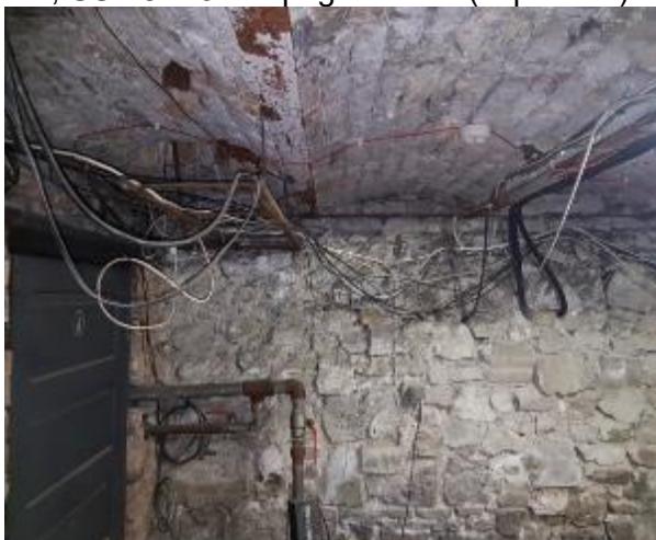
5.9.23. att. Nesakārtoti kabeļi un vadi pagrabstāvā
