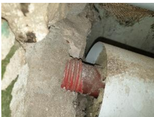
5.4.3.att. Siltumtīklu ievads ēkā, šķērsojuma vieta starp telpām Nr.1 un Nr.2
