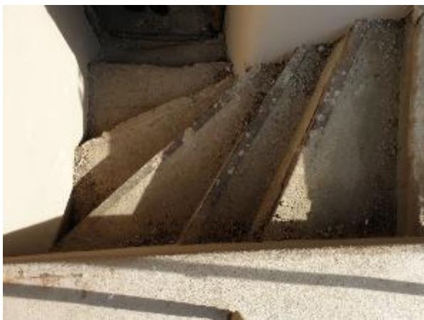
4.10.3.att. Kāpnes Nr.1, kāpņu bojājumi
