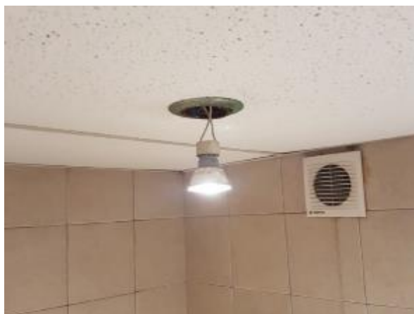
5.9.52. att. Gaismeklis 2.stāva sanmezglā
