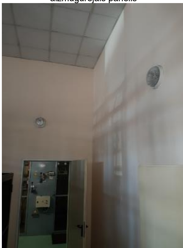
5.9.8. att. Apgaismojums līdzstrāvas sadalnes telpā
