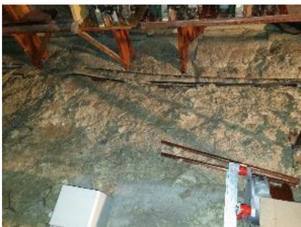
4.6.23.att. Bēniņu stāva pārsegums, ieklātais minerālvates siltumizolācijas slānis
