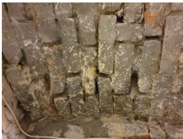
4.6.2.att. Pagrabstāva pārsegums, velvju mūra un mūrjavas erozija
