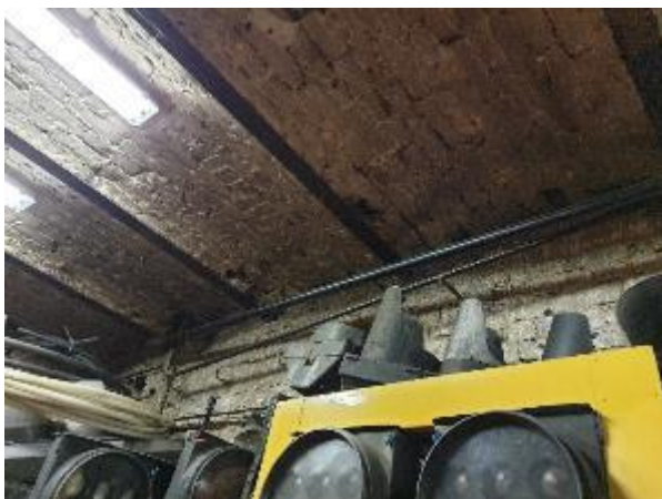
4.6.5.att. Pagrabstāva pārsegums, velvju mūra un mūrjavas erozija, mūra izdrupumi
