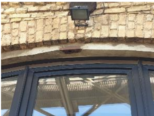
4.2.25.att. Metāla arkveida siju pārsedze, apmetuma izdrupumi, nebūtiska sijas korozija
