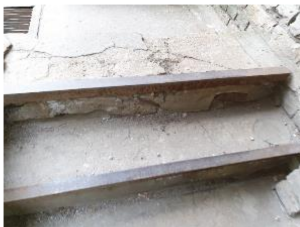
4.10.6.att. Kāpnes Nr.3, kāpņu bojājumi
