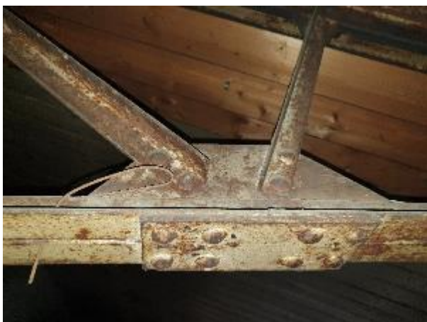
4.8.5.att. Tērauda kopņu jumta nesošās konstrukcijas
