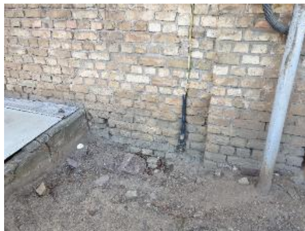
4.2.14.att. Nesošā ķieģeļu siena, mūra erozija, nebūtiski mūra izdrupumi
