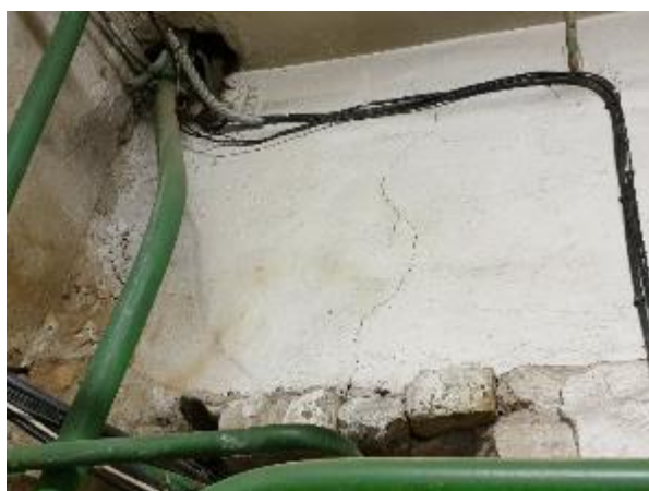
4.1.30.att. Ēkas pagrabstāvs, pēc inženiertīklu montāžas nav veikta atvērums aizpildīšana
