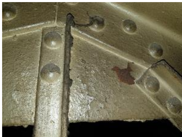
4.8.4.att. Tērauda kopņu jumta nesošās konstrukcijas
