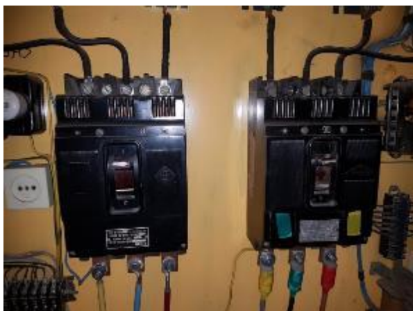
5.9.9. att. Pašpatēriņa sadalnes ievada automātslēdži
