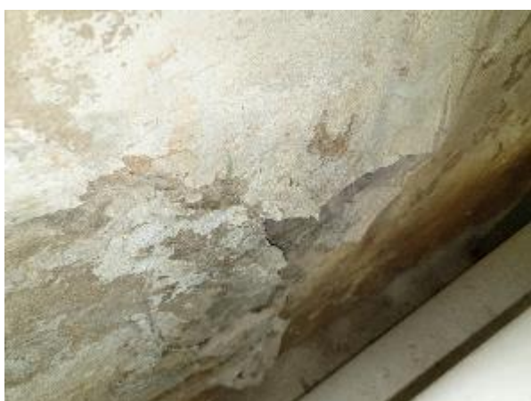
4.1.15.att. Ēkas pagrabstāvs, kapilārā mitruma radīti bojājumi
