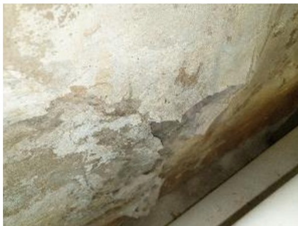
4.18.12.att. Pagrabstāva iekšējā apdare, kapilārā mitruma rezultātā radīti apdares bojājumi
