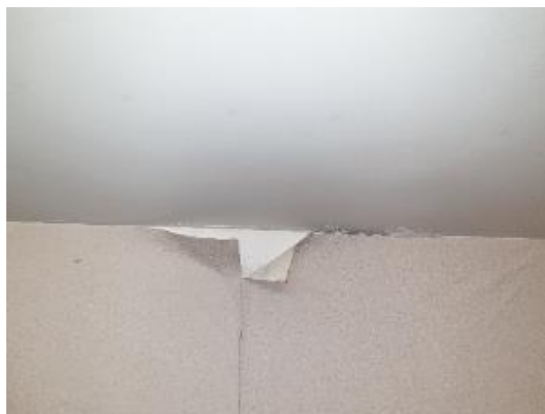
4.8.19.att. Mitruma caursūkšanās rezultātā radīti apdares bojājumi
