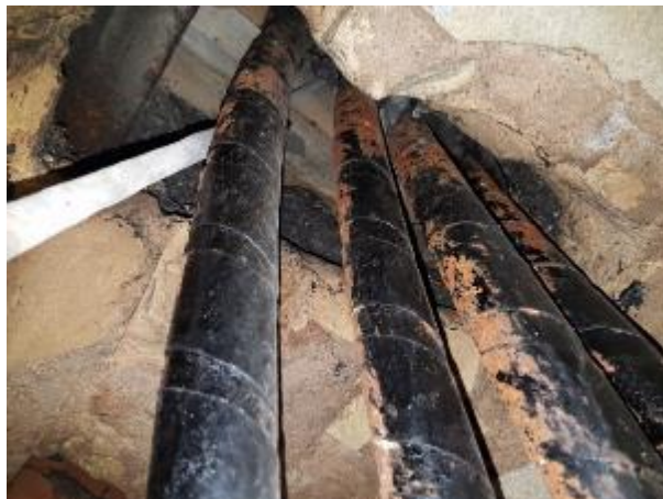
5.9.28. att. Kabelu šķērsojums caur pagrabstāva un 1.stāva pārsegumu
