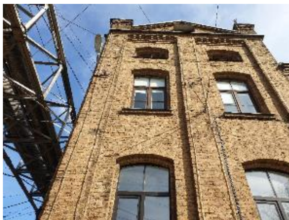
4.13.4.att. Logi ar PVC kārbu un stikla pakešu pildījumu
