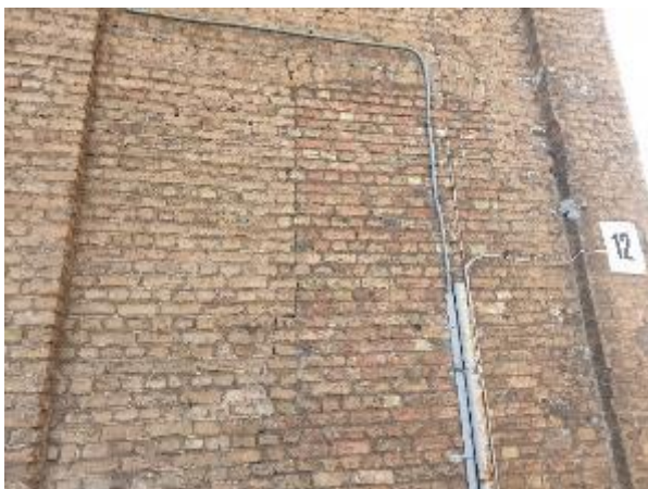
4.2.9.att. Nesošā ķieģeļu siena, nevienmērīgas sēšanās plaisa
