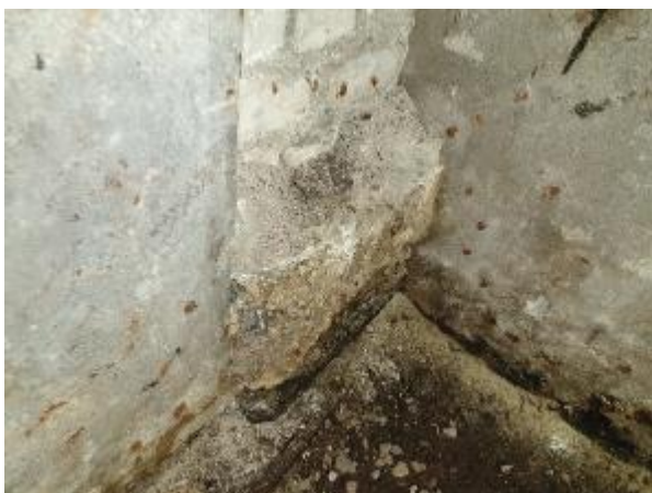
4.1.25.att. Ēkas pagrabstāvs, kapilārā mitruma radīti bojājumi
