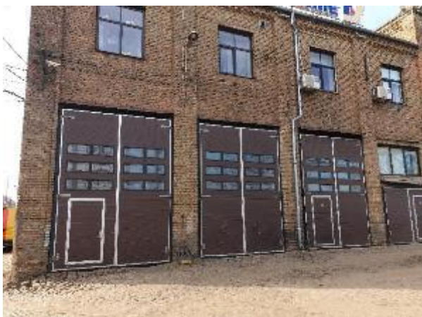
4.13.11.att. Ēkas tehnisko telpu vārti
