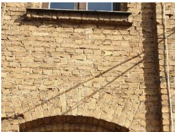
4.2.5.att. Nesošā ķieģeļu siena, nevienmērīgas sēšanās plaisa
