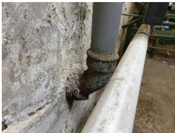
5.1.10.att. Sadzīves kanalizācijas stāvvadi, PVC un ķeta cauruļvadu savienojums
