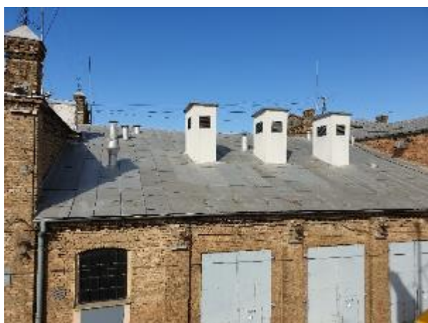
4.8.14.att. Skārda lokšņu jumta segums
