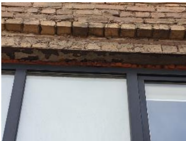
4.2.27.att. Metāla sijas pārsedzes, nebūtiska sijas korozija
