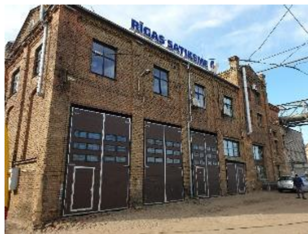
1.2. att. Apsekotā ēka, ziemeļaustrumu fasāde
