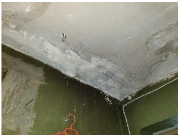
4.18.5.att. Ēkas iekšējā apdare, mitruma caursūkšanās rezultātā bojāta iekšējā apdare
