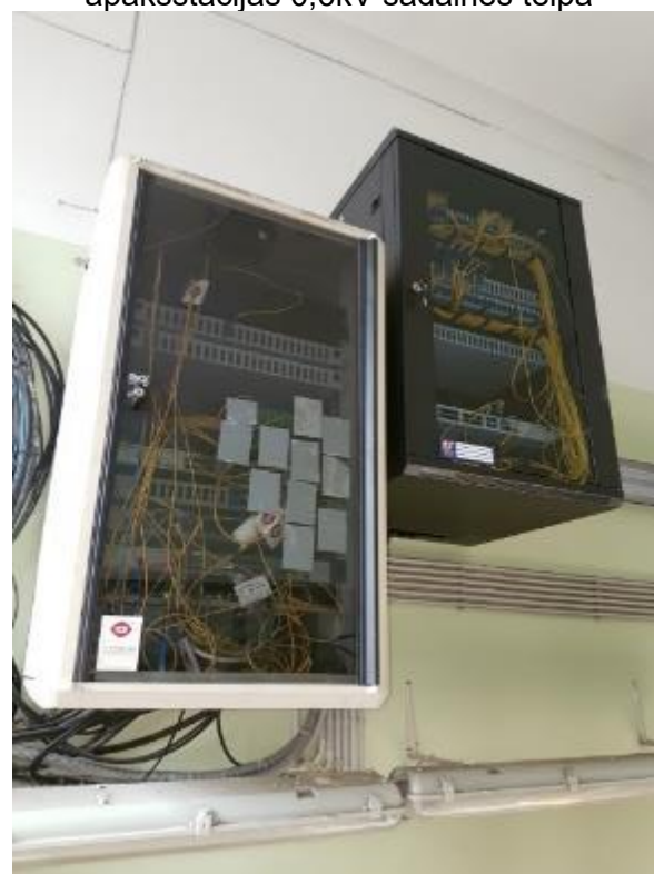
5.9.36. att. Komunikācijas skapji 0,6kV līdzstrāvas sadalnes telpā
