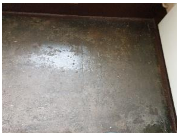
4.12.4.att. Betona grīdas segums ēkas kāpņu telpā, seguma nolietojums
