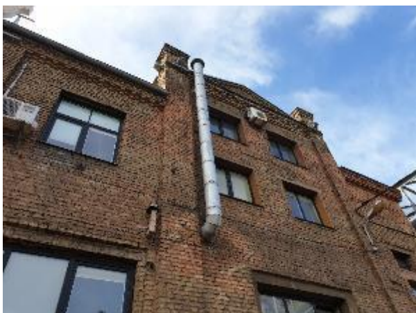
4.13.1.att. Logi ar PVC kārbu un stikla pakešu pildījumu
