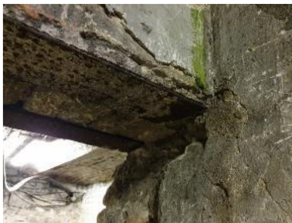
4.2.30.att. Metāla sijas pārsedzes, būtiska sijas korozija
