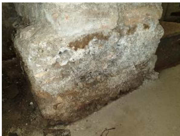
4.1.26.att. Ēkas pagrabstāvs, kapilārā mitruma radīti bojājumi
