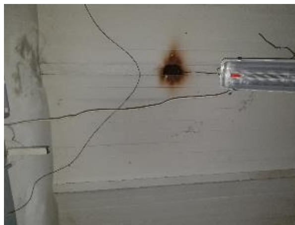
4.6.20.att. Pirmā stāva telpas Nr. 30 pārsegums
