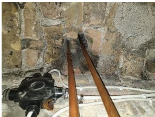
4.6.6.att. Pagrabstāva pārsegums, pēc inženiertīklu montāžas nav veikta pārseguma konstrukcijas atjaunošana
