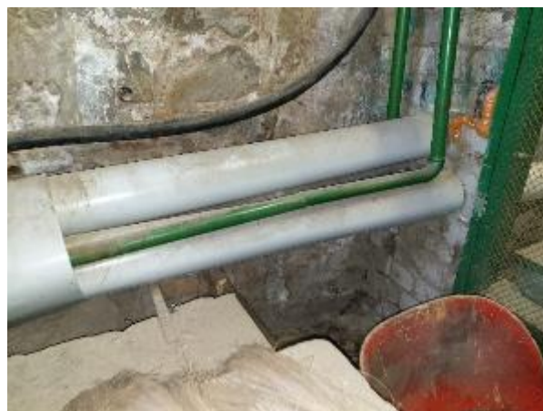
5.4.2.att. Siltumtīklu ievads ēkā
