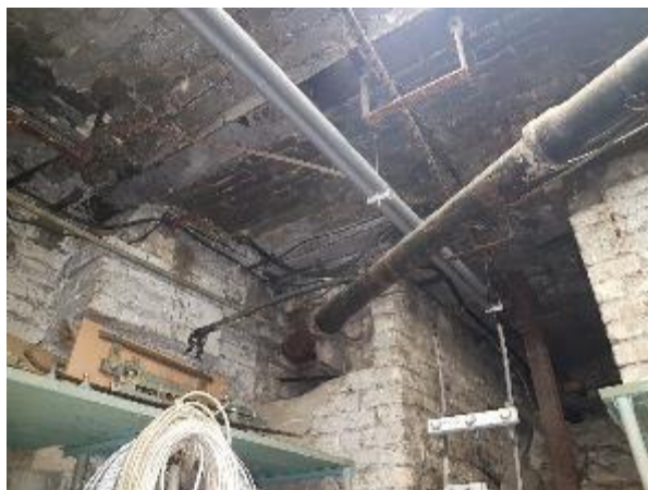
5.1.12.att. Sadzīves kanalizācijas ķeta cauruļvadi
