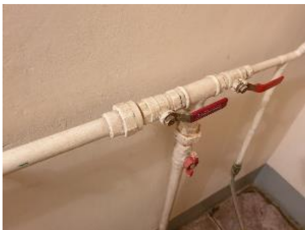
5.1.13.att. Sanitārtehniskās iekārtas pievienojums ar lokanās caurules palīdzību
