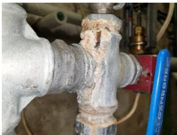
5.2.4.att. Karstā ūdens sistēmas loks, nehermētisks sistēmas elementu savienojums
