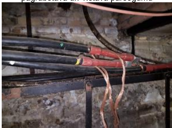
5.9.30. att. Nepieslēgts/nedemontēts kabelis pagrabstāvā
