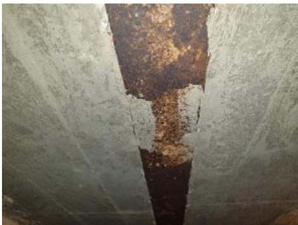
4.6.11.att. Pagrabstāva pārsegums, nebūtiska metāla siju korozija
