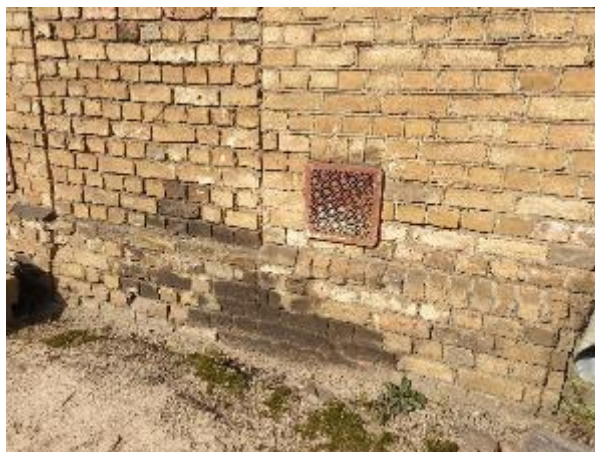
4.19.6.att. Ēkas ārējā apdare, uz virsmas izveidojies būtisks apsūnojums
