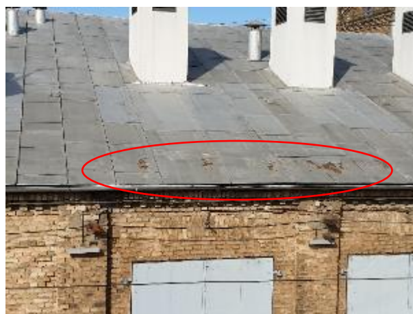
4.8.15.att. Skārda lokšņu jumta segums, nebūtiski pretkorozijas pārklājumi bojājumi, nebūtiska lokšņu korozija
