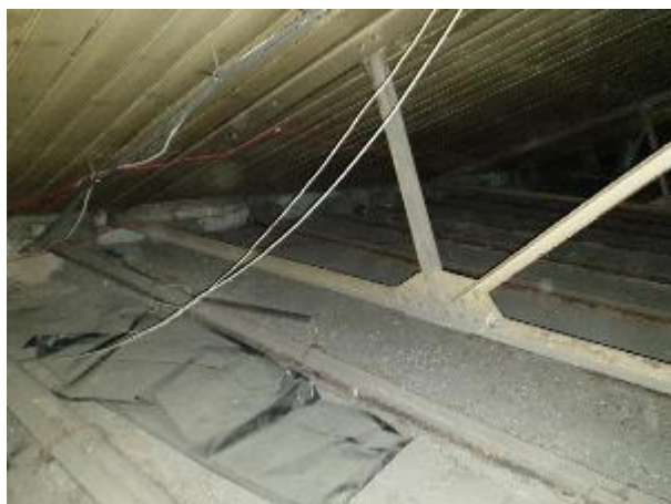
4.8.1.att. Tērauda kopņu jumta nesošās konstrukcijas
