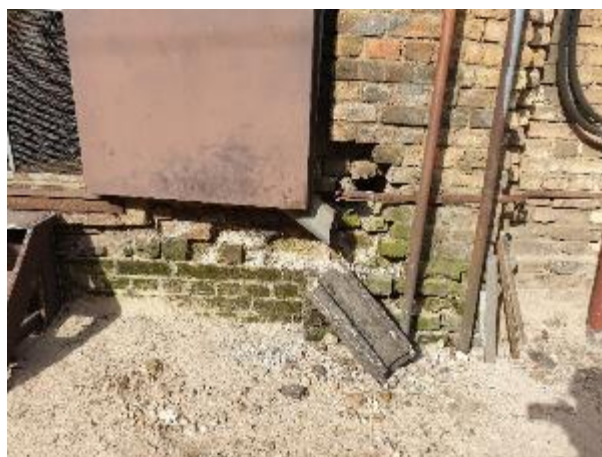
4.8.23.att. Lietus ūdens novadīšana sistēma, neefektīva un neatbilstoša lietus ūdeņu novadīšana
