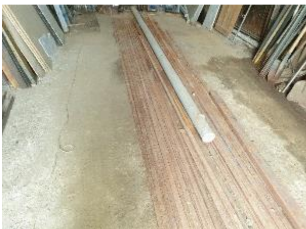
4.12.3.att. Betona grīdas segums ēkas pirmajā stāvā, seguma nolietojums
