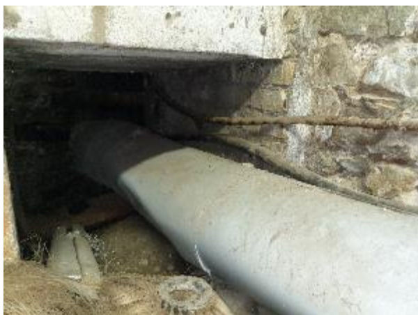
5.4.1.att. Siltumtīklu ievads ēkā
