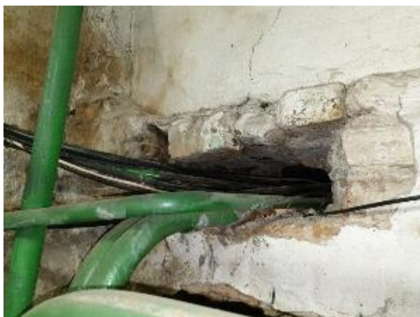
4.1.31.att. Ēkas pagrabstāvs, pēc inženiertīklu montāžas nav veikta atvērumu aizpildīšana
