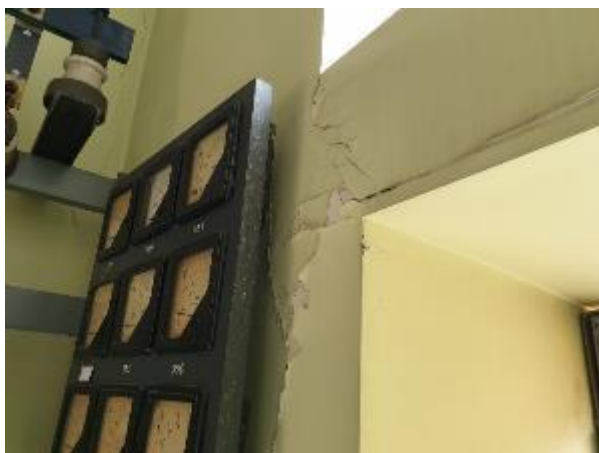
4.18.1.att. Ēkas iekšējā apdare, mitruma caursūkšanās rezultātā bojāta iekšējā apdare
