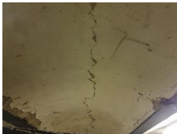
4.6.8.att. Pagrabstāva pārsegums, plaša pārsegumā aptuveni zem starpsienas izbūves vietas
