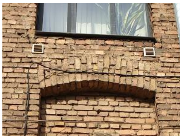
4.2.22.att. Ķieģeļu velvju pārsedze
