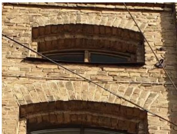
4.2.6.att. Nesošā ķieģeļu siena, nevienmērīgas sēšanās plaisa
