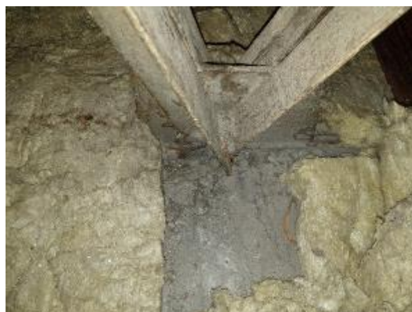
4.6.24.att. Bēniņu stāva pārsegums, ieklātais minerālvates siltumizolācijas slānis
