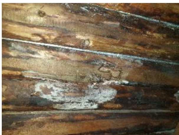
4.8.16.att. Jumta nesošās konstrukcijas, jumta spārēm nav izveidots atbilstošs nabalstījums
