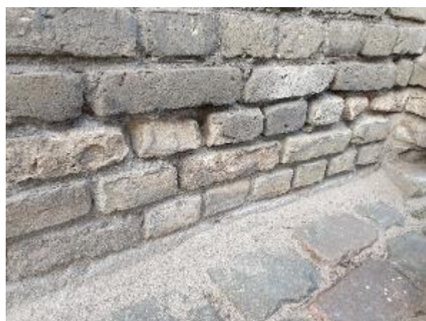
4.1.6.att. Nebūtiska pamata virszemes daļas mūra un mūrjavas erozija, uz virsmas izveidojies nebūtisks apsūnojums un izsālījumi
