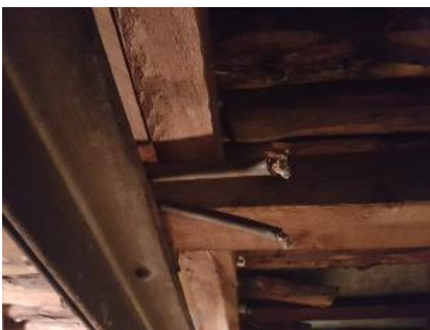
5.9.49. att. Nepieslēgtie/nedemontētie kabeļi bēniņos
