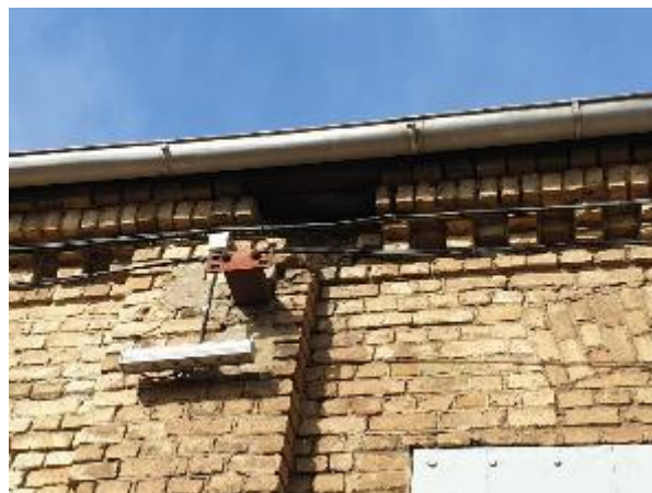
4.2.20.att. Nesošā ķieģeļu siena, mūra izdrupumi karnīzes daļā
