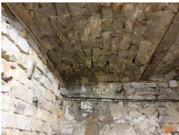
4.6.1.att. Pagrabstāva pārsegums, velvju mūra un mūrjavas erozija
