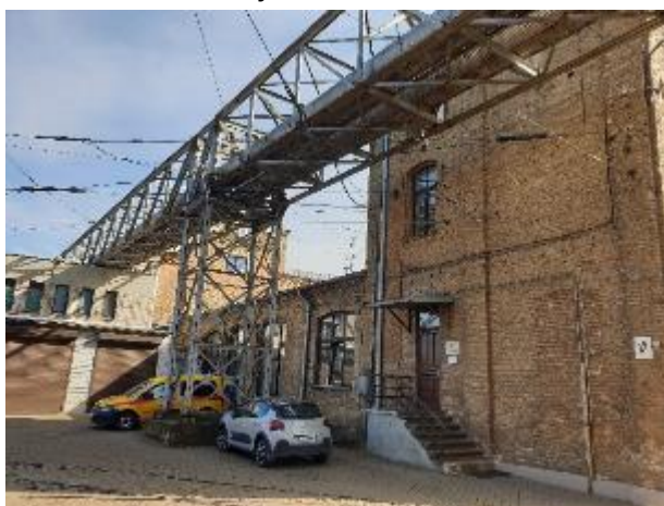
1.1. att. Apsekotā ēka, ziemeļrietumu fasāde
