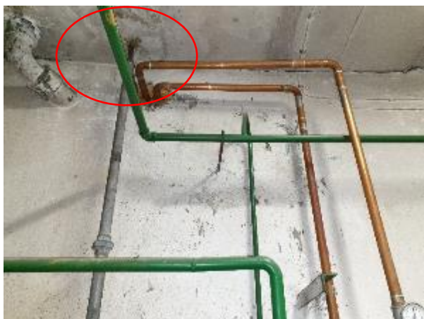
4.15.5.att. Inženiertīklu šķērsojums ugunsdrošajā konstrukcijā, veikta šķērsojumu aizdare ar neatbilstošiem būvizstrādājumiem
