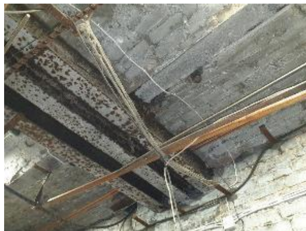
4.6.12 .att. Pagrabstāva pārsegums, nebūtiska metāla siju korozija
