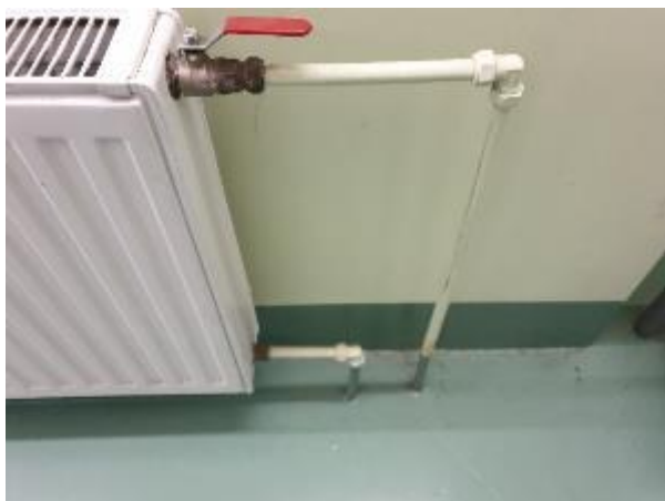
5.5.5.att. Tērauda apkures radiatora pieslēgums
