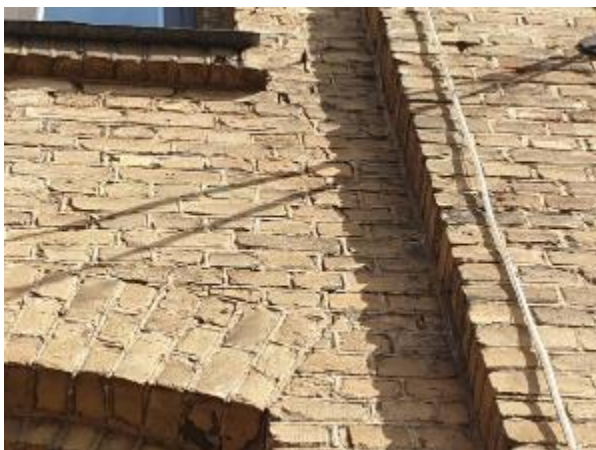
4.2.7.att. Nesošā ķieģeļu siena, nevienmērīgas sēšanās plaisa
