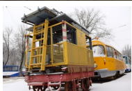
Uz koka tornīša blāns 2007. gadā būvētais gaikasvada remonts tornis ar pacelamo platformu, 2005. gada 26. janvāris. Fotogrāfijas autors: Imārs Žvutijs
