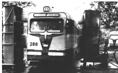
Mazgāšanas iekārtai tramvaja depo cauri brauc 11. maršruta tramvajs RM-56, 1967. gads. Fotogrāfijas autors nav zināms.
