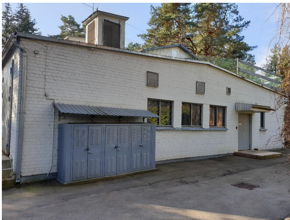
1. att. Apakšstacijas ēka
