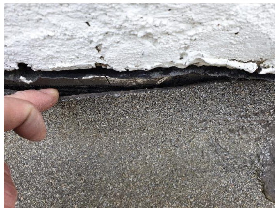
4.8.6.att. Jumta seguma izbūves nepilnības, nav nodrošināts hermētiskums
