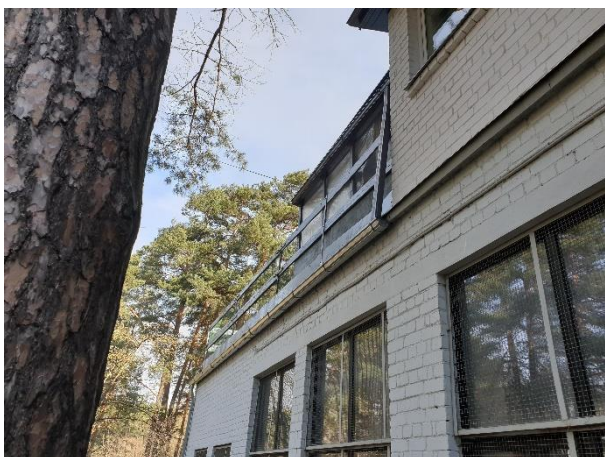
4.8.11.att. Neatbilstošs notekcaurules un teknes savienojums
