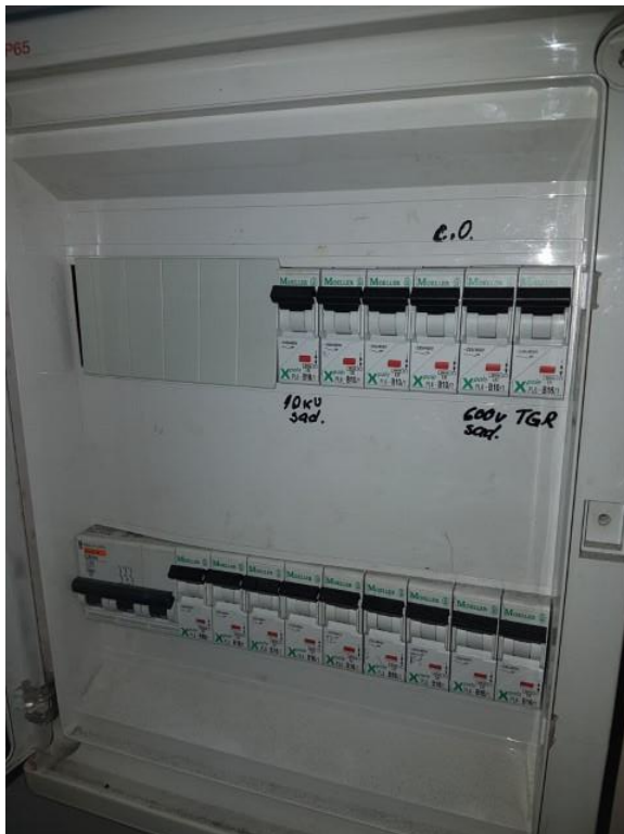
5.9.15. att. SS-1 spēka un apgaismojuma sadalne
