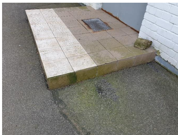
4.9.4.att. Nebūtiski lieveņa flīžu seguma bojājumi, uz seguma izveidojies nebūtisks apsūnojums
