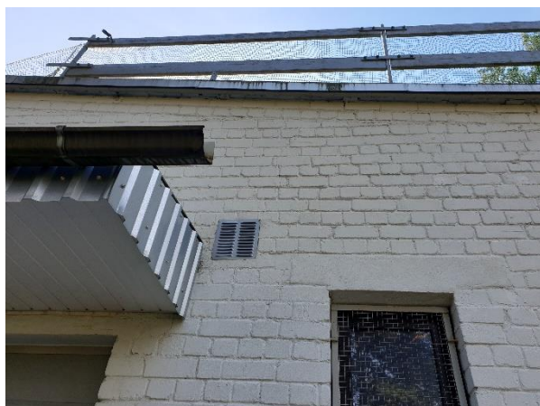
4.9.1.att. Jumtiņš virs ēkas ieejas, jumtiņa teknei nav uzstādīti stāvvedi
