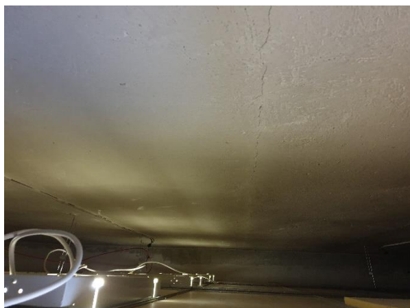
4.6.1.att. Plaisa panelu savienojuma vietā
