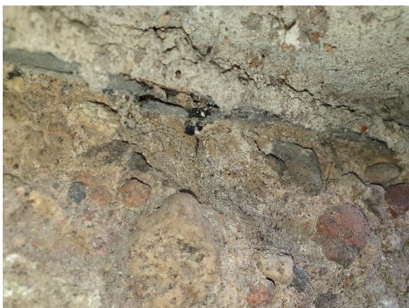
4.5.1.att. Ēkas horizontālā hidroizolācija
