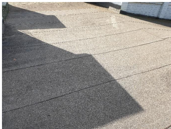
4.8.2.att. Jumta segums
