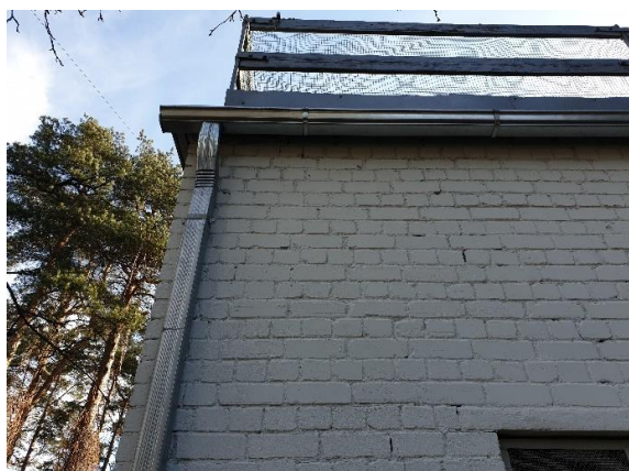
4.8.9.att. Ēkas ārējā lietus ūdens novadīšanas sistēma
