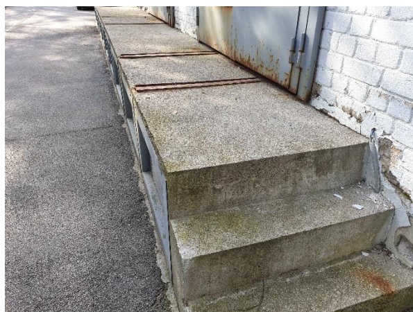
4.10.2.att. Rampa austrumu fasādes pusē
