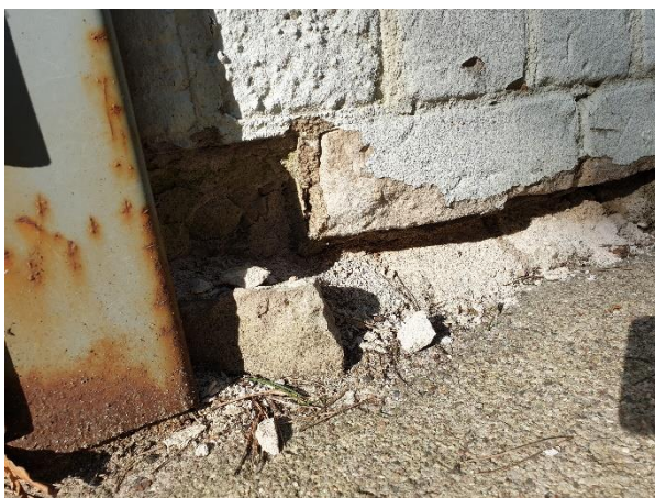
4.2.11.att. Mūra konstrukcijas austrumu fasādes pusē, mūra un mūrjavas erozija, izdrupumi
