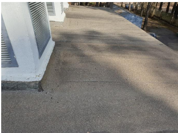
4.8.1.att. Jumta segums
