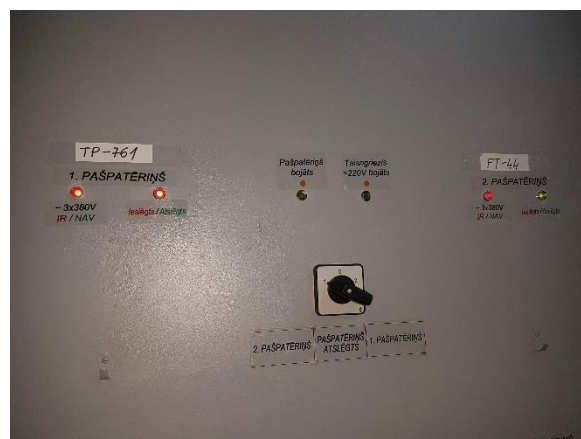
5.9.12. att. Pašpatēriņa ievada sadalnes barošanas izvēles slēdzis un indikācija
