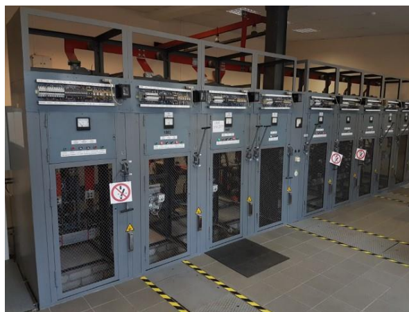
5.9.10. att. Līdzstrāvas 0,6 kV sadalne
