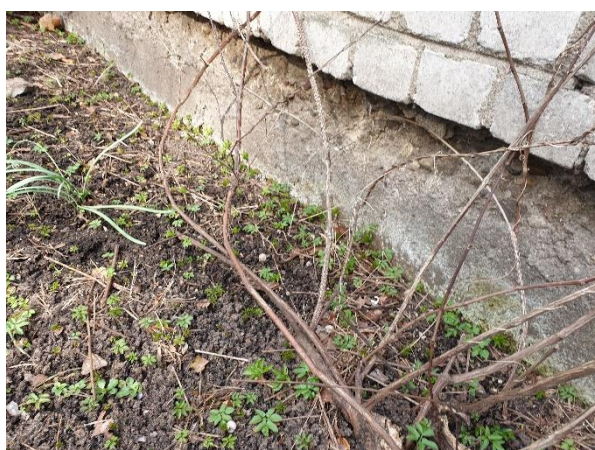
4.1.10.att. Dienvidu fasādes puse, nav ierīkota ēkas aizsargapmale
