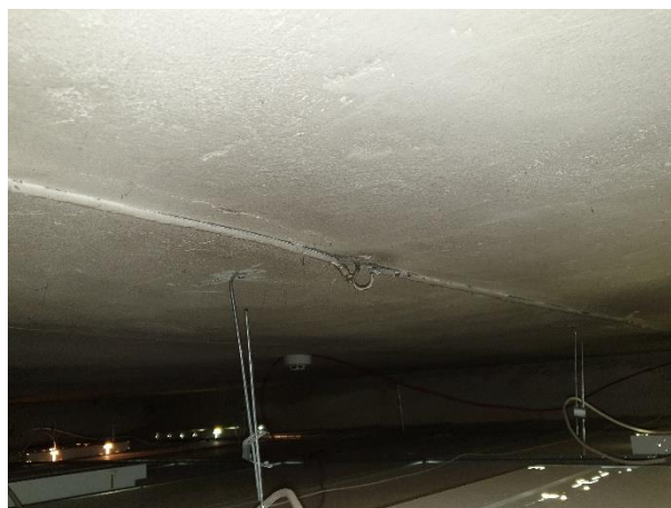
5.9.24. att. Elektrokabelis nav pieslēgts patēriņa ierīcei
