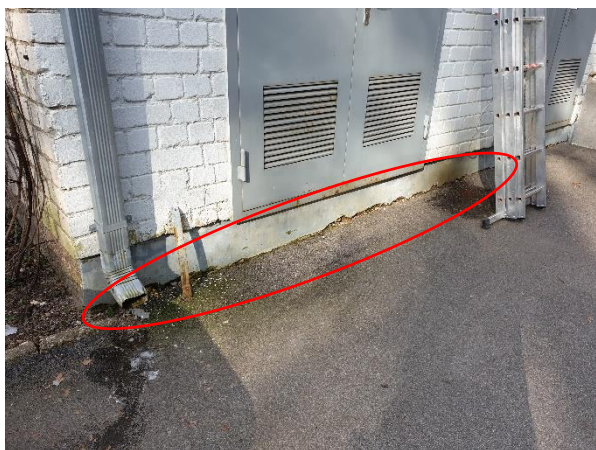
4.1.7.att. Nebūtiska pamata virszemes daļas betona erozija, uz betona virsmas izveidojies nebūtisks apsūnojums
