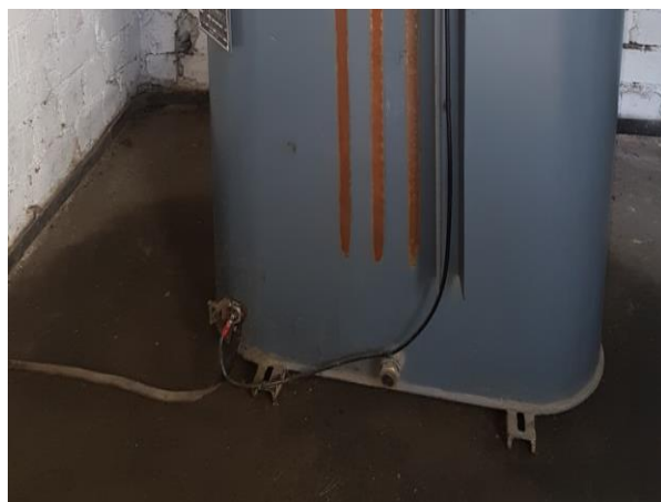
4.12.2.att. Betona grīdas segums
