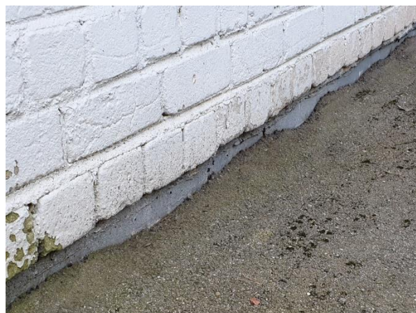
4.1.12.att. Ēkas aizsargapmale, seguma iesēdumi (nekvalitatīvi iestrādāta seguma virskārta)
