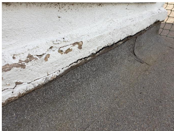
4.8.5.att. Jumta seguma izbūves nepilnības, nav nodrošināts hermētiskums
