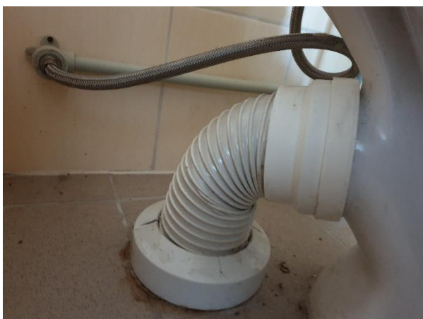
5.1.3.att. Sanitārtehniskās iekārtas pievienojums ar PVC caurulēm
