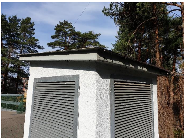
4.8.3.att. Segums virs ventilācijas izvadiem, segums tehniski nolietojies
