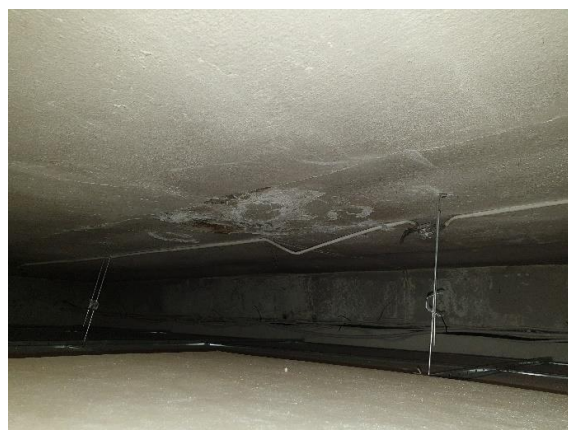
4.8.8.att. Jumta nesošās konstrukcija, uz apdares virsmas konstatēti veci mitruma caursūkšanās rezultātā radīti apdares bojājumi
