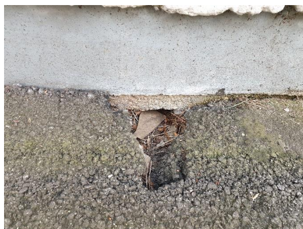
3.1.6.att. Asfaltbetona segums, seguma iesēdumi
