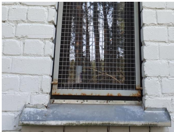
4.13.2.att. Logu aizsargrestes, nebūtiska tērauda profilu korozija
