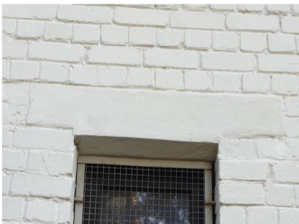
4.2.13.att. Dzelzsbetona pārsedzes
