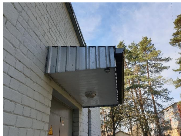
4.9.2.att. Jumtiņš virs ēkas ieejas, nebūtiska teknes deformācija
