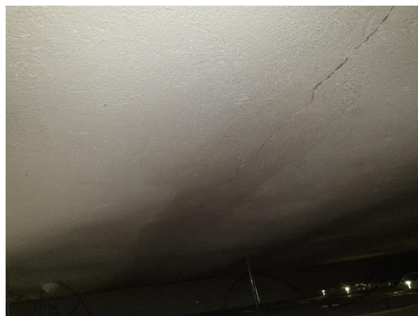
4.6.2.att. Plaisa panelu savienojuma vietā
