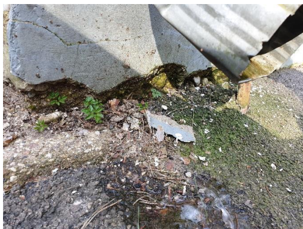
4.1.8.att. Nebūtiska pamata virszemes daļas betona erozija, uz betona virsmas izveidojies nebūtisks apsūnojums
