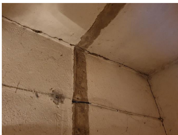
4.11.1.att. Demontētā starpsiena starp telpām Nr.2 un Nr.3
