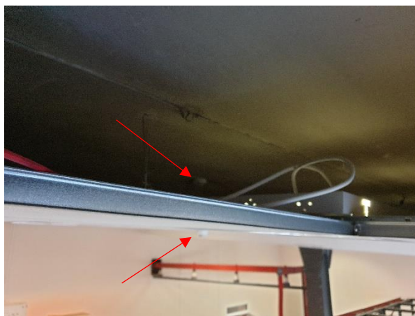
5.3.8.att. dūmu detektori zem un virs piekārtu griestu konstrukcijām
