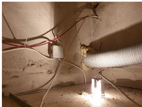
4.5.4.att. Inženiertīklu šķērsojums ēkas ārsienā, izmantoti neatbilstoši būvizstrādājumi – celtniecības putas
