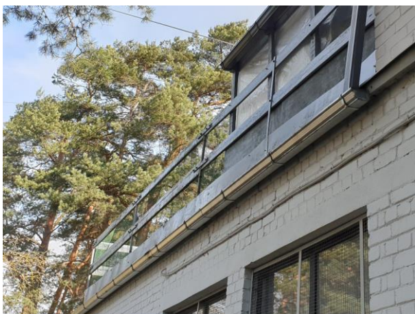
4.8.15.att. Uzstādītās ēkas jumta margas
