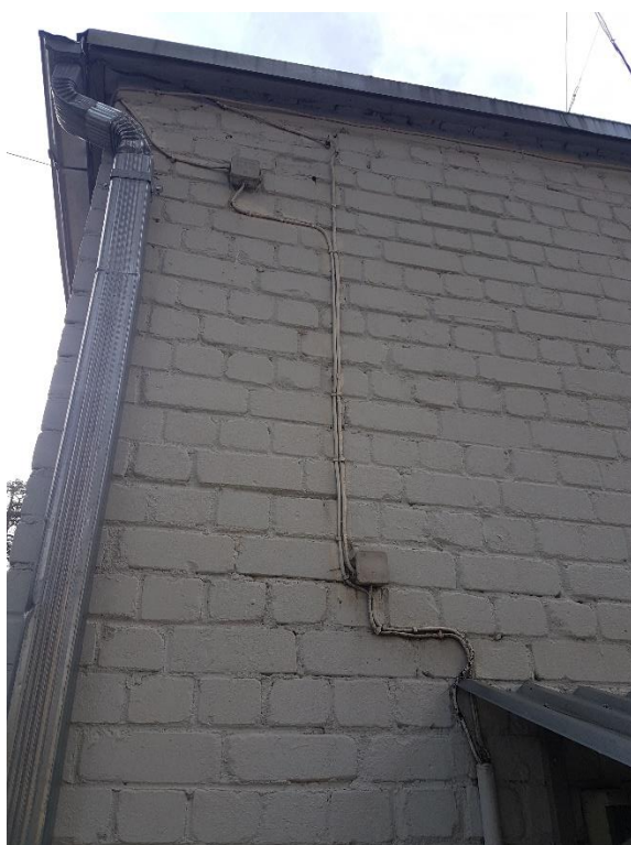
6.7.1. att. NYM kabelis uz fasādes sienas
