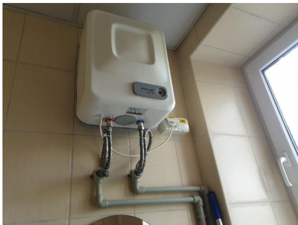
5.2.1.att. Karstā ūdens elektriskais sildītājs
