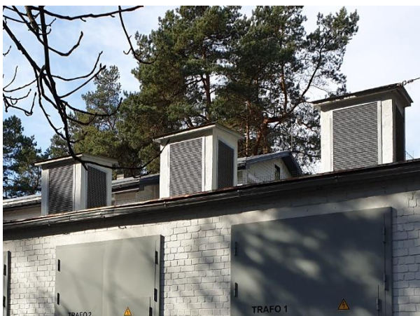
4.16.1.att. Transformatoru telpas ventilācijas izvadi
