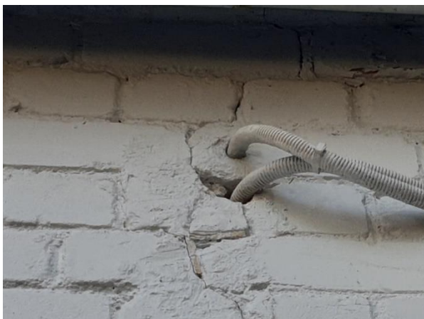
4.5.3.att. Inženiertīklu šķērsojums ēkas ārsienā, nav veikta šķērsojuma aizdare
