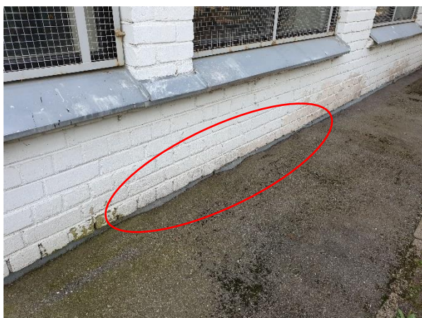
3.1.3.att. Asfaltbetona segums, seguma iesēdumi, uz seguma izveidojies nebūtisks apsūnojums
