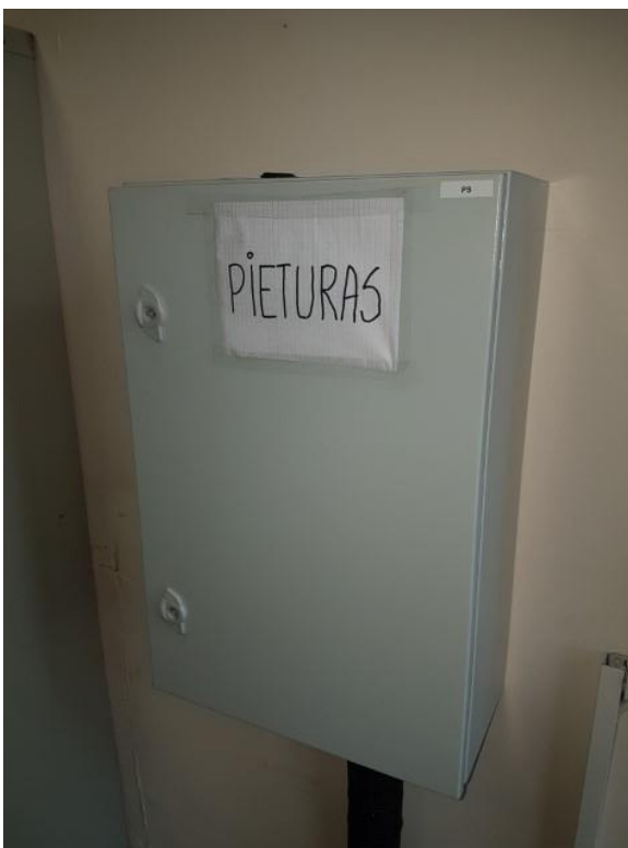
5.9.17. att. PS sadalnes durvis bez brīdinājuma zīmes "Bīstami, elektrība"
