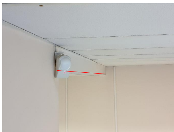
4.3.5. att. Dzelzsbetona rīģeļa izliece
