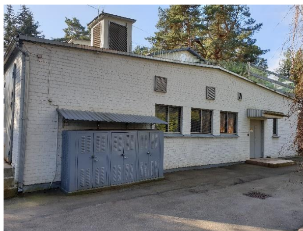
1.2. att. Apsekotā ēka, ziemeļu fasāde
