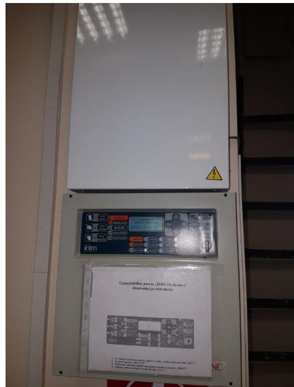
5.9.16. att. Ugunsdrošības signalizācijas panelis
