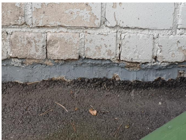
4.1.5.att. Nekvalitatīvi izveidota pamatu apdare
