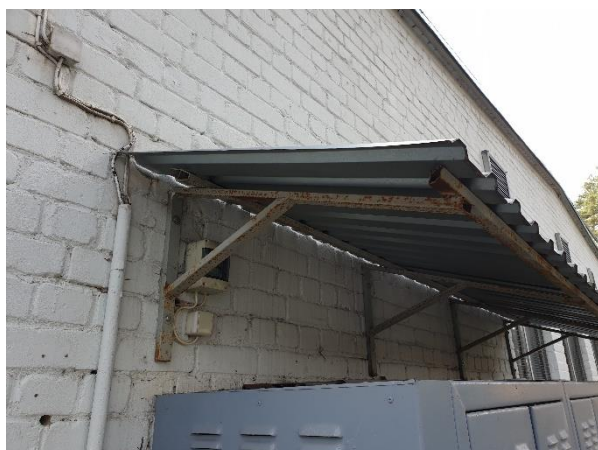
4.9.3.att. Jumtiņš virs metāla skapjiem, nebūtiska tērauda profilu korozija
