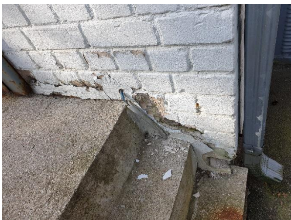
4.2.9.att. Mūra konstrukcijas austrumu fasādes pusē, mūra un mūrjavas erozija
