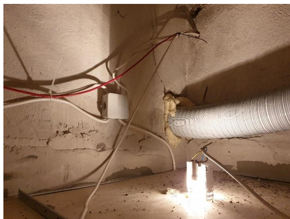
4.16.2.att. Sanitārtehniskās telpas ventilācijas gaisa vads
