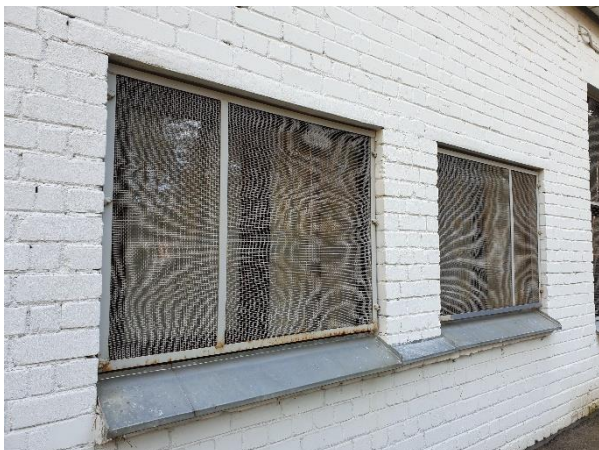
4.13.1.att. Logu aizsargrestes, nebūtiska tērauda profilu korozija
