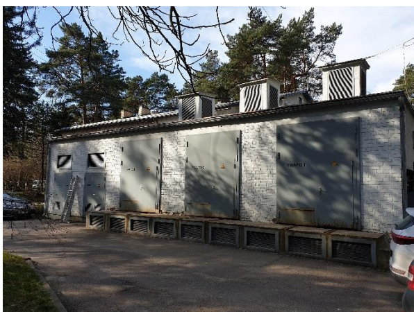
4.10.1.att. Rampa austrumu fasādes pusē
