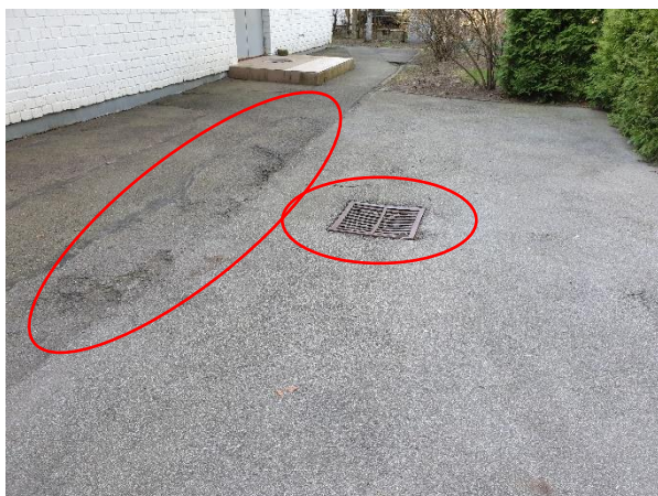
3.1.1.att. Asfaltbetona segums, seguma virskārtā izveidojušās plaisas un izdrupumi, seguma iesēdumi
