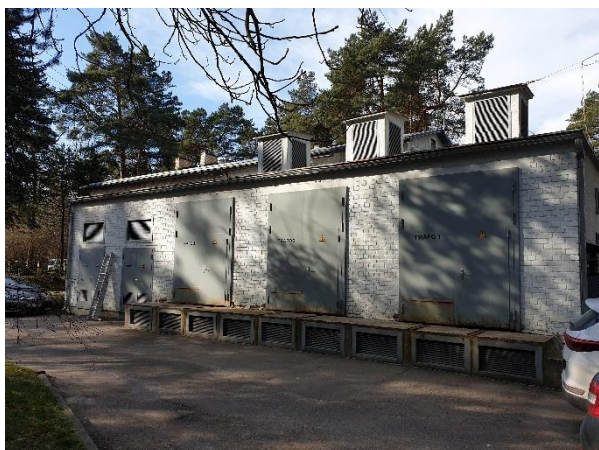
1.3. att. Apsekotā ēka, austrumu fasāde
