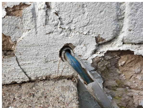
4.5.2.att. Inženiertīklu šķērsojums ēkas ārsienā, nav veikta šķērsojuma aizdare
