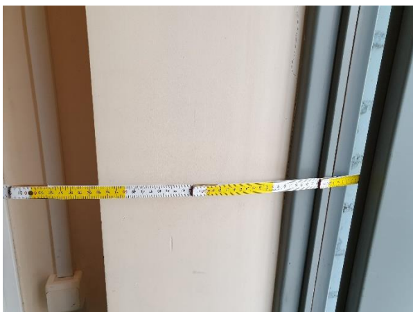
4.2.1.att. Nesošā silikātķieģeļu ārsiena, kopējais sienas biezums ~ 530 mm
