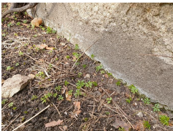
4.1.3.att. Nebūtiska pamata virszemes daļas betona erozija, uz betona virsmas izveidojies nebūtisks apsūnojums un izsālījumi
