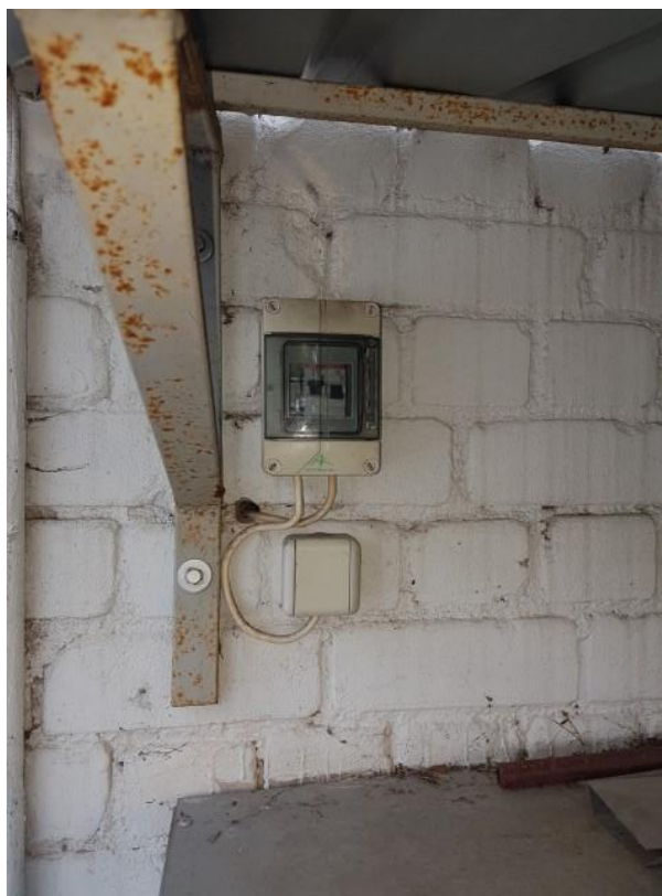
6.7.4. att. NYM kabelis uz fasādes sienas
