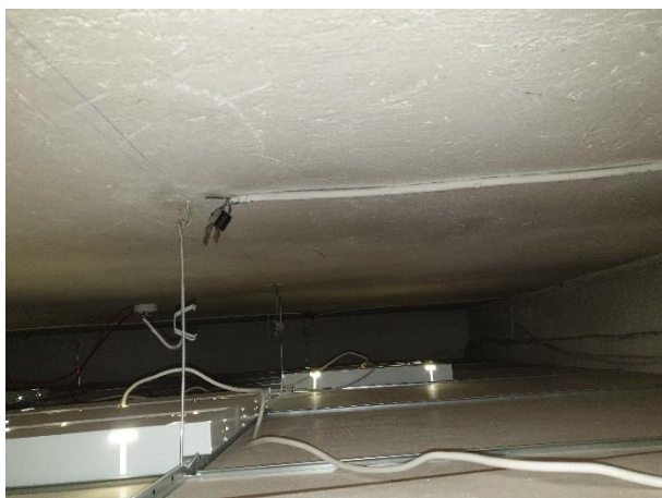
5.9.23. att. Elektrokabelis nav pieslēgts patēriņa ierīcei
