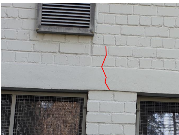
4.2.15.att. Plaisa caur dzelzsbetona pārsedzi
