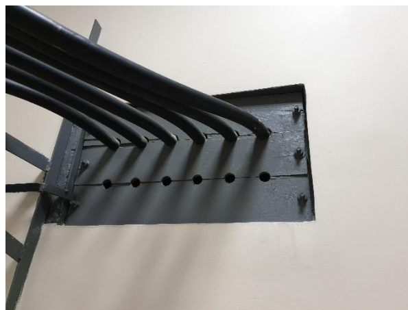
4.5.6.att. Inženiertīklu šķērsojums starpsienā starp apkurināmu un neapkurināmu telpu, nav veikta aizdare
