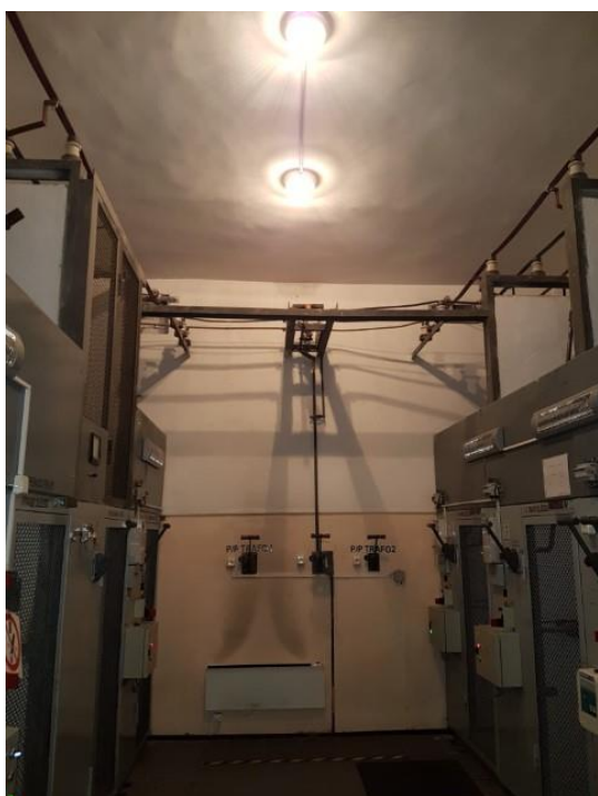
5.9.1. att. 10 kV iekštelpu sadalietais (ISI)
