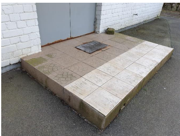
4.9.3.att. Nebūtiski lieveņa flīžu seguma bojājumi, uz seguma izveidojies nebūtisks apsūnojums
