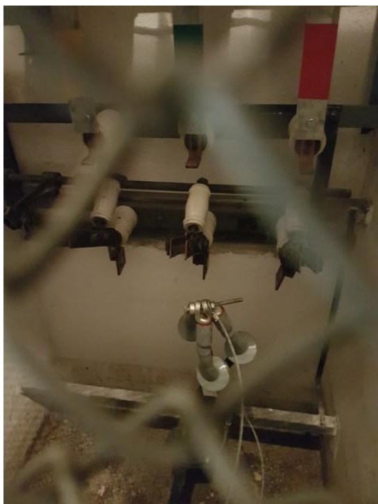
5.9.5. att. Atslēgts 10 kV kabelis no FP-44
