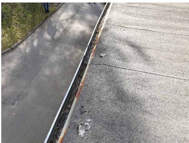
4.8.13.att. Pastiprināts tekņu aizsērējums
