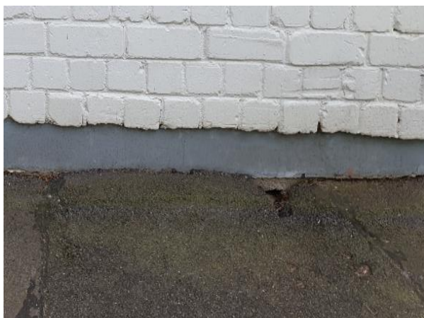
4.1.11.att. Ēkas aizsargapmale, seguma iesēdumi
