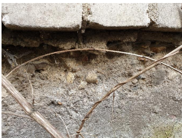
4.1.1.att. Nebūtiska pamata virszemes daļas betona erozija, uz betona virsmas izveidojies nebūtisks apsūnojums un izsālījumi
