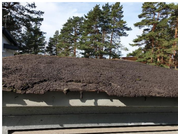
4.8.4.att. Segums virs ventilācijas izvadiem, segums tehniski nolietojies
