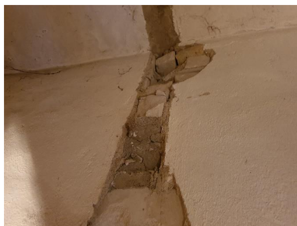
4.11.2.att. Demontētā starpsiena starp telpām Nr.2 un Nr.3
