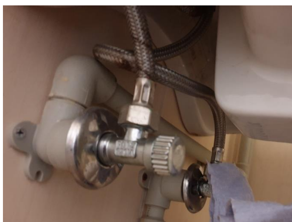
5.1.6.att. Sanitārtehniskās iekārtas pievienojums ar lokanās caurules palīdzību
