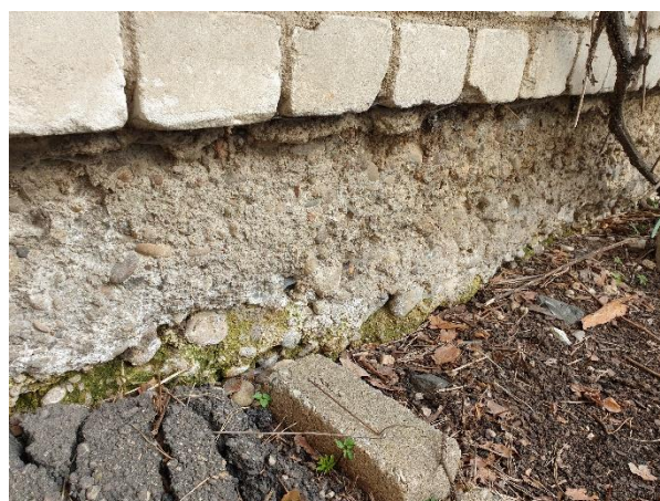
4.1.2.att. Nebūtiska pamata virszemes daļas betona erozija, uz betona virsmas izveidojies nebūtisks apsūnojums un izsālījumi
