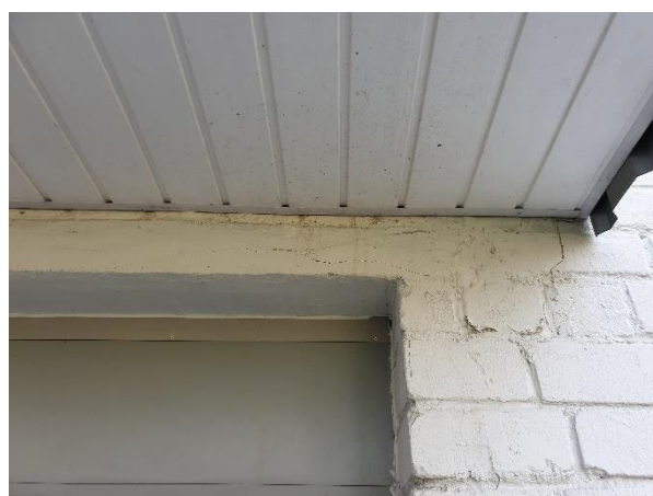
4.2.18.att. Plaisa dzelzsbetona pārsedzē
