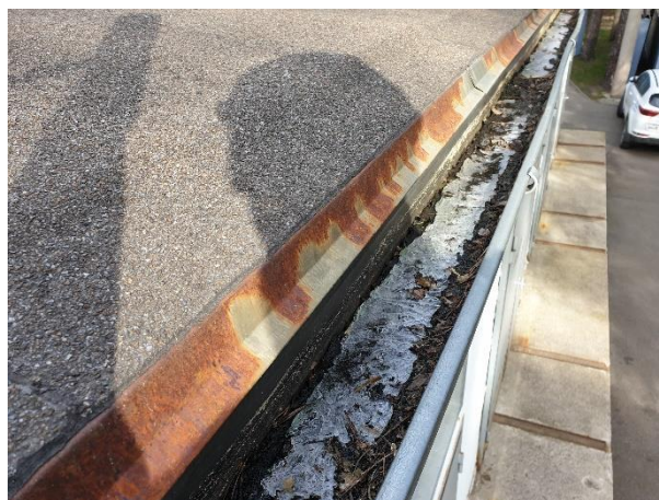
4.8.14.att. Pastiprināts tekņu aizsērējums
