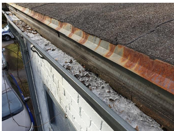
4.8.7.att. Lāseņa pastiprināta korozija, renes aizsērējums
