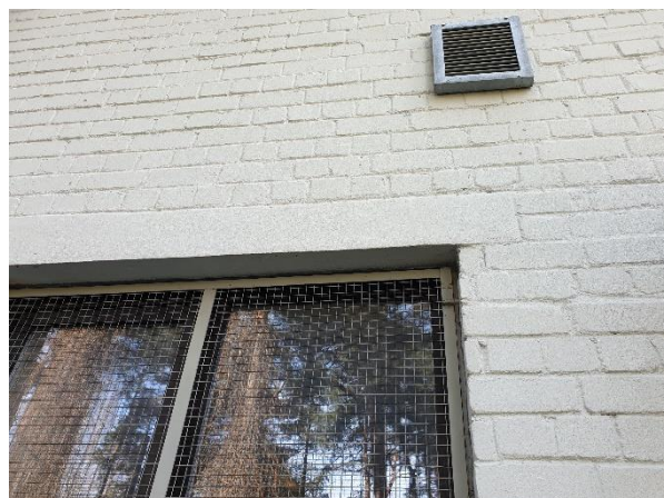
4.2.14.att. Dzelzsbetona pārsedzes
