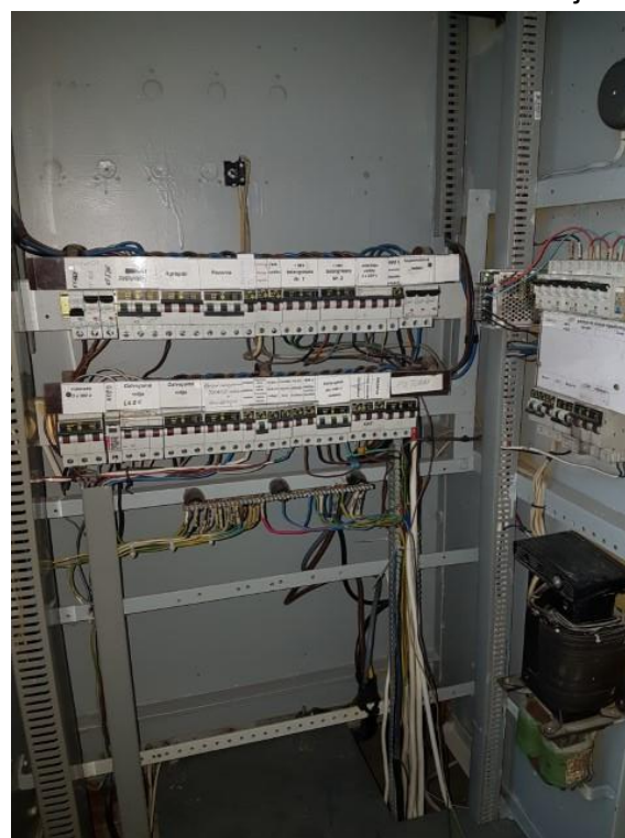
5.9.14. att. Pašpatēriņa ievada sadalnes pievienojumu grupu automātslēdži
