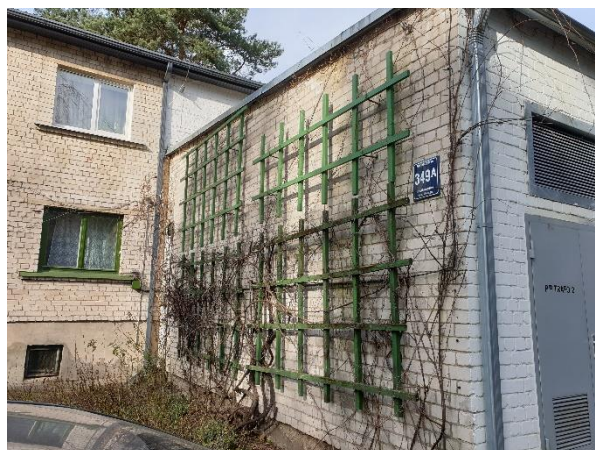
1.4. att. Apsekotā ēka, dienvidu fasāde
