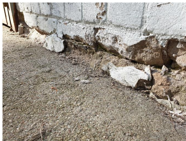
4.2.12.att. Mūra konstrukcijas austrumu fasādes pusē, mūra un mūrjavas erozija, izdrupumi
