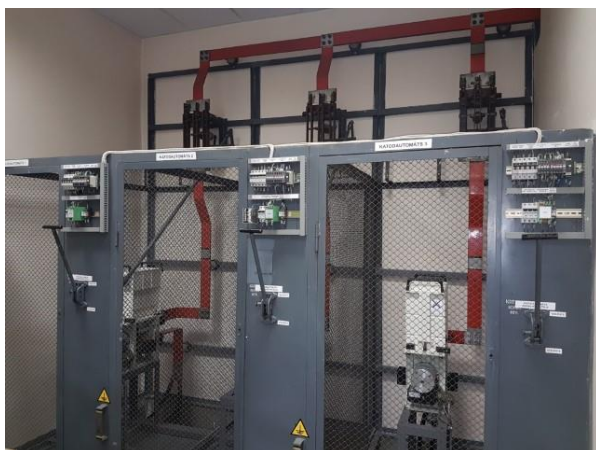
5.9.9. att. Izvadi no taisngriežu iekārtām – pieslēgums pie kopējās kopnes caur katodautomātiem
