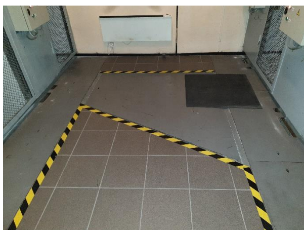
4.12.3.att. Keramisko flīžu segums, virs kanāliem uzstādītas rievotās tērauda loksnes
