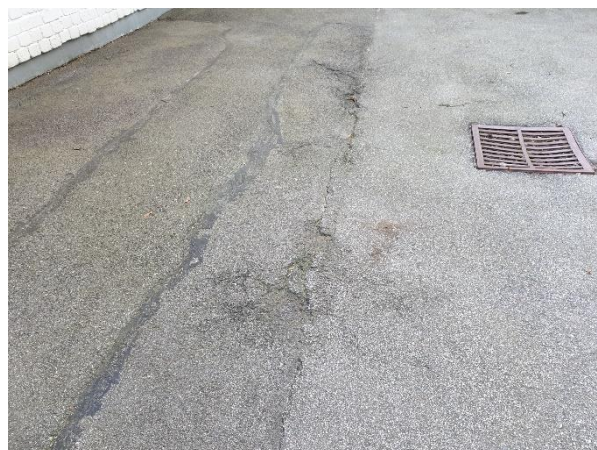
3.1.2.att. Asfaltbetona segums, seguma virskārtā izveidojušās plaisas un izdrupumi, seguma iesēdumi
