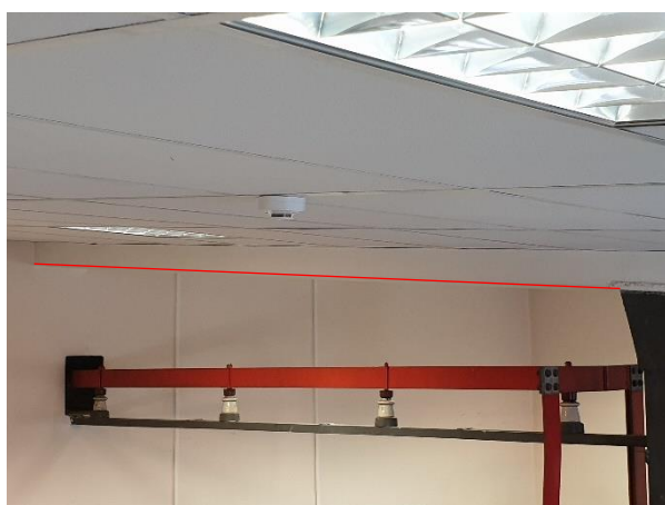
4.3.4. att. Dzelzsbetona rīģeļa izliece
