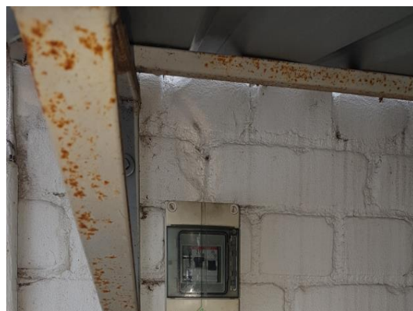
4.9.4.att. Jumtiņš virs metāla skapjiem, nebūtiska tērauda profilu korozija
