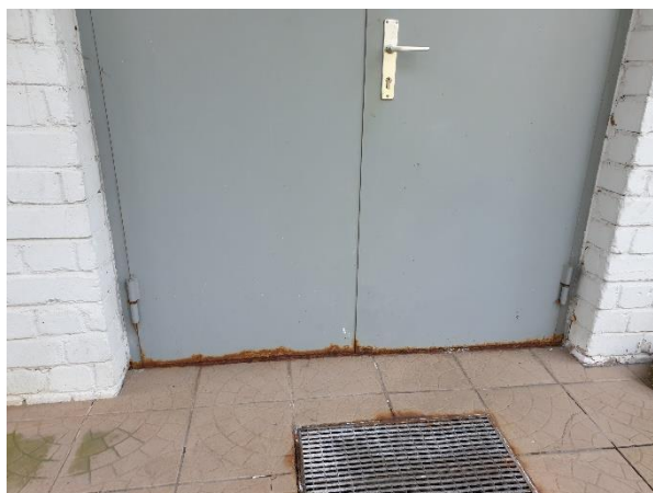
4.13.4.att. Ēkas metāla ārdurvis, nebūtiska korozija
