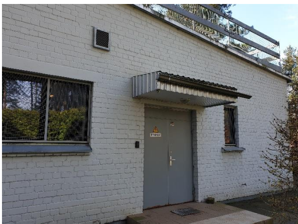
4.13.3.att. Ēkas metāla ārdurvis
