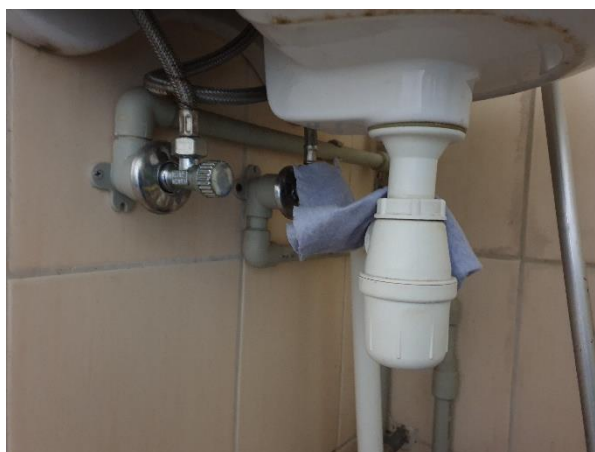
5.1.4.att. Sanitārtehniskās iekārtas pievienojums ar PVC caurulēm
