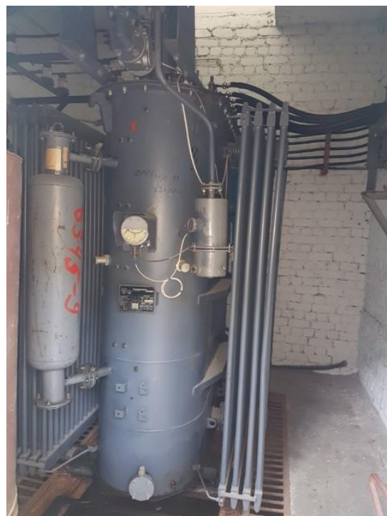
5.9.6. att. Vilces 10/0,565 kV transformators
