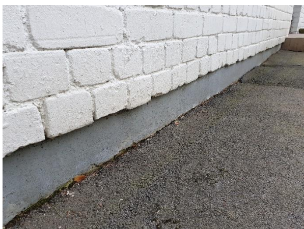
3.1.5.att. Asfaltbetona segums, seguma iesēdumi
