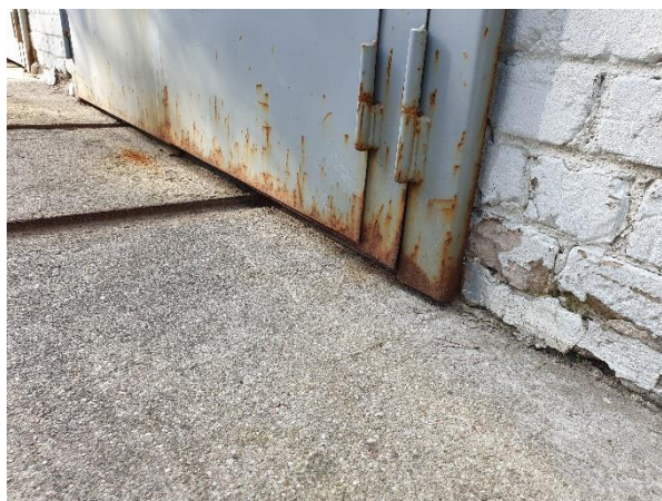
4.13.6.att. Transformatoru telpas vārti, nebūtiska korozija
