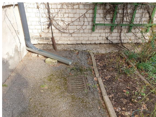
3.1.4.att. Asfaltbetona segums, seguma iesēdumi, uz seguma izveidojies nebūtisks apsūnojums
