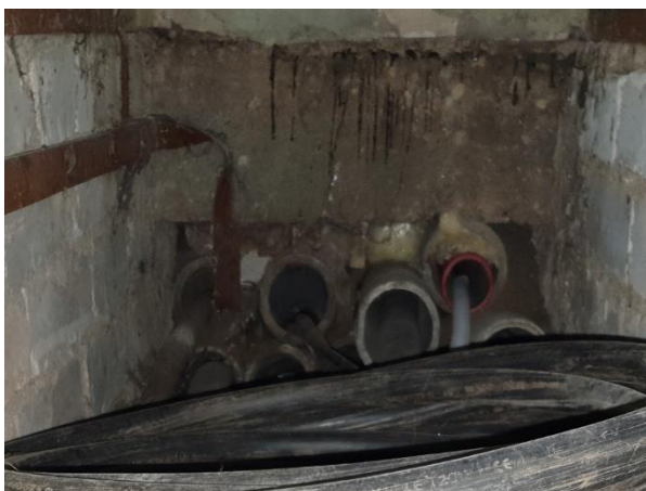
4.5.5.att. Inženiertīklu šķērsojums ēkas ārējas pamatu konstrukcijā, izmantoti neatbilstoši būvizrādājumi – montāžas putas
