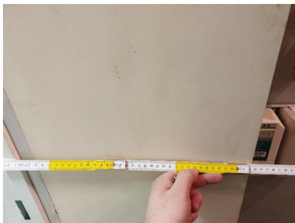
4.2.1.att. Nesošā silikātķieģeļu iekšsiena, kopējais sienas biezums ~ 420 mm
