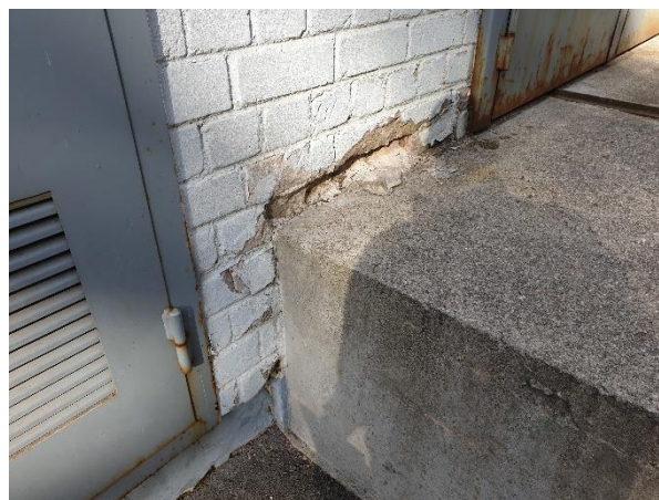
4.2.10.att. Mūra konstrukcijas austrumu fasādes pusē, mūra un mūrjavas erozija
