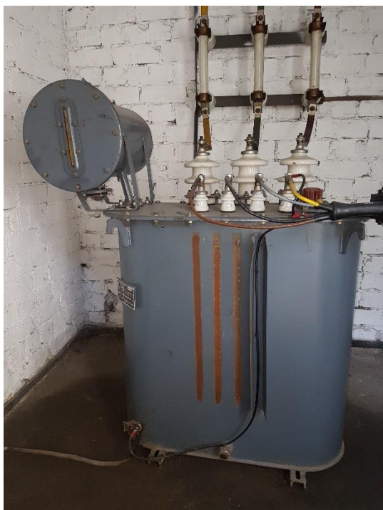
5.9.7. att. Pašpatēriņa 10/0,4 kV transformators
