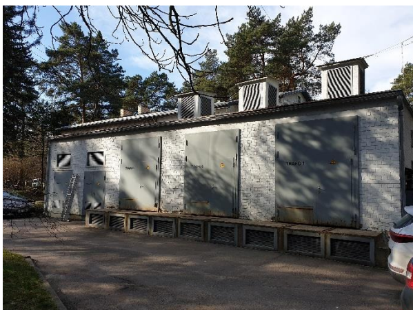
4.13.5.att. Transformatoru telpas vārti
