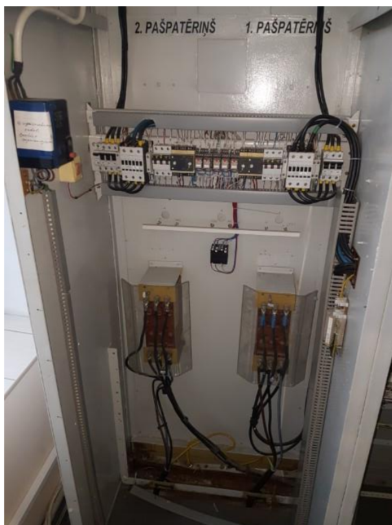
5.9.13. att. Pašpatēriņa ievada sadalnes ievadaautomātslēdžu aizmugurējā puse
