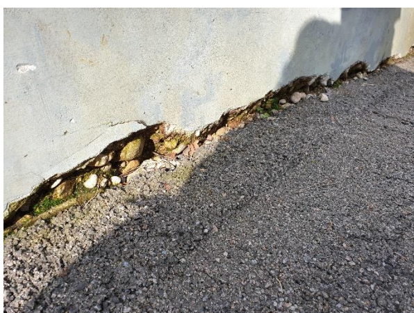
4.1.9.att. Nebūtiska pamata virszemes daļas betona erozija, uz betona virsmas izveidojies nebūtisks apsūnojums
