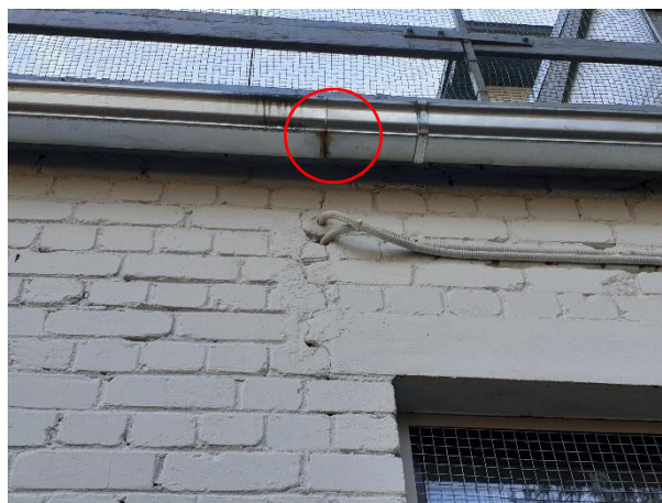
4.8.12.att. Nehermētiski tekņu savienojumi
