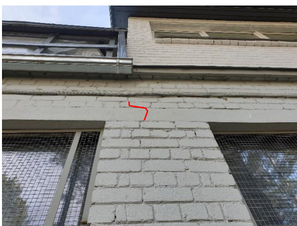
4.2.17.att. Plaisa dzelzsbetona pārsedzē
