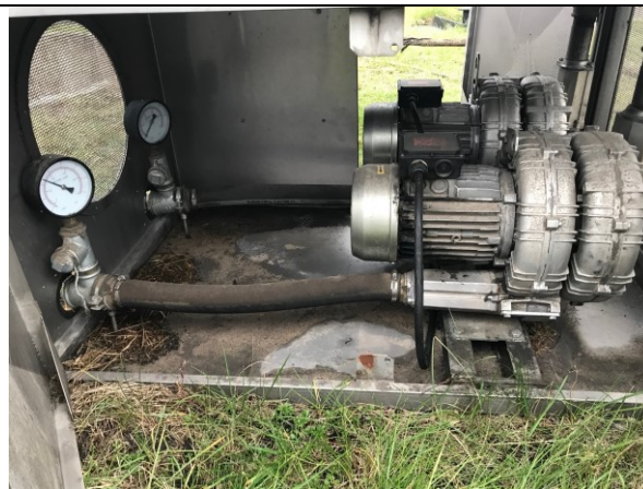
6.6. Foto. Bioloģisko notekūdeņu attīrīšanas iekārtas Bioekol-vrt-500 kompresori ar manometriem un gaisa padeves vadiem (29.10.2020.)
