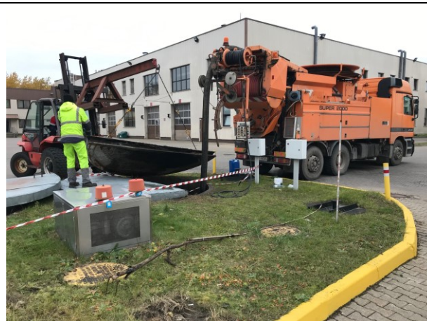
6.2. Foto. Bioloģisko notekūdeņu attīrīšanas iekārtas Bioekol-vrt-500 biobloku vāku atvēršanas process (26.10.2020.)
