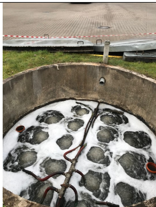
6.3. Foto. Bioloģiskās notekūdeņu attīrīšanas iekārtas Bioekol-vrt-500 biobloka BNAI-2 skats pēc tīrīšanas (29.10.2020.)
