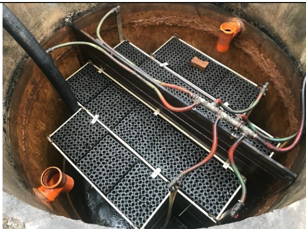
6.5. Foto. Bioloģisko notekūdeņu attīrīšanas iekārtas Bioekol-vrt-500 biobloks (BNAI-2), ko veido propilēna biobloks alumīnija rāmī ar lamelām baktēriju augšanai un difuzori ar gaisa padeves vadiem (27.10.2020.)
