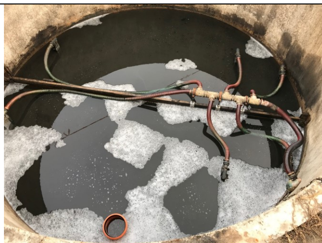
6.2. Foto. Bioloģisko notekūdeņu attīrīšanas iekārtas Bioekol-vrt-500 biobloku vāku atvēršanas process (26.10.2020.)
