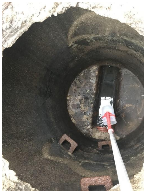
1. Foto. Notekūdēns vizuālais skats aimnieciskās kanalizācijas skatakā Nr. K-40 (pieslēguma punktā Nr. 2) parauga ņemšanas brīdī (14.11.2019.)
