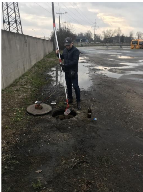
2. Foto. Saimnieciskās notekūdēns parauga ņemšanas vieta jeb skataka Nr. K-40 (pieslēguma punkts Nr. 2) (14.11.2019.)
