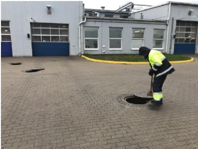
7.1. Foto. Atrāšanās vieta saimnieciskās notekūdens skatai K-19, kura nav saistīta ar ražošanas kanalizācijas skatā RN-1. (14.11.2019.)
