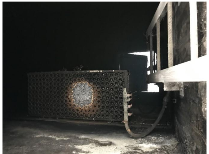
6.2. Motoru ceha ražošanas notekūdeņu attīrīšanas iekārtu aerācijas bloks (20.11.2019.)
