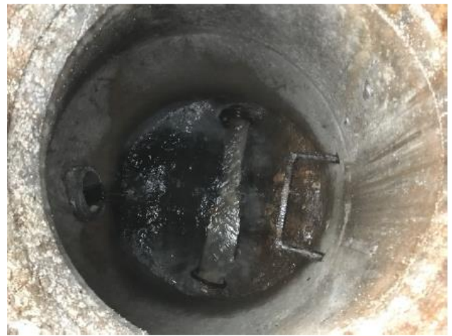
7.2. Foto. Saimnieciskās kanalizācijas skatakas K-19 iekšējais skats bez ražošanas kanalizācijas pieslēguma no skatakas RN-1. (14.11.2019.)
